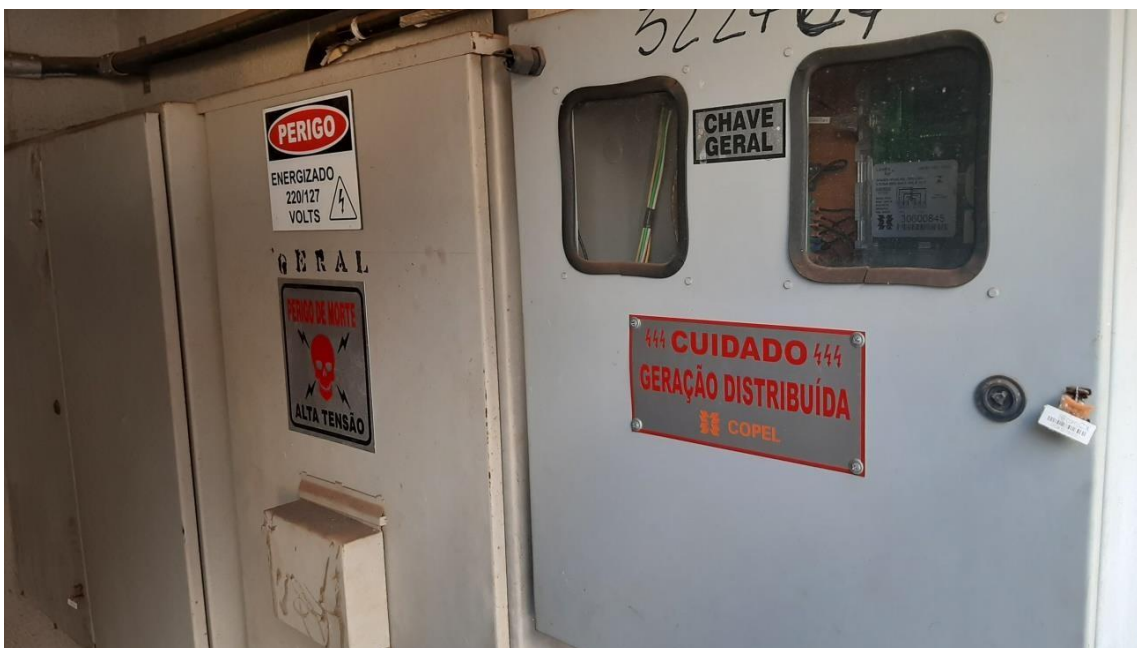
Figura 15 – Chave geral de energia elétrica com indicação da geração distribuída Foto: Próprio autor (2020)
