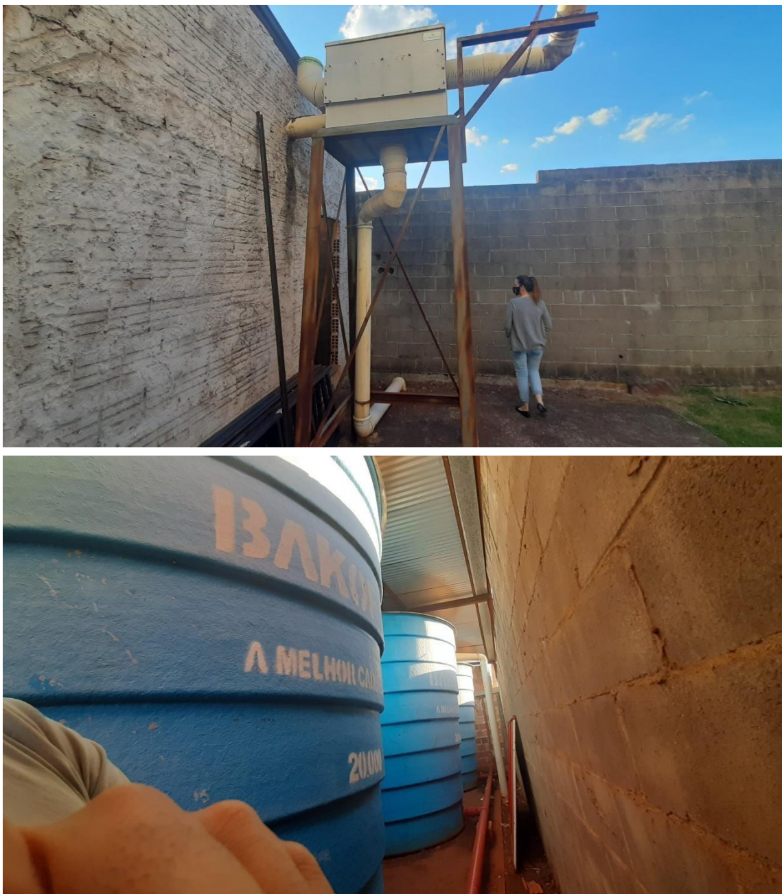
Figura 8 – a) entrada do sistema de abastecimento das cisternas e b) tanques de armazenamento de água, com capacidade nominal de 2000 litros cada. Foto – próprio autor
