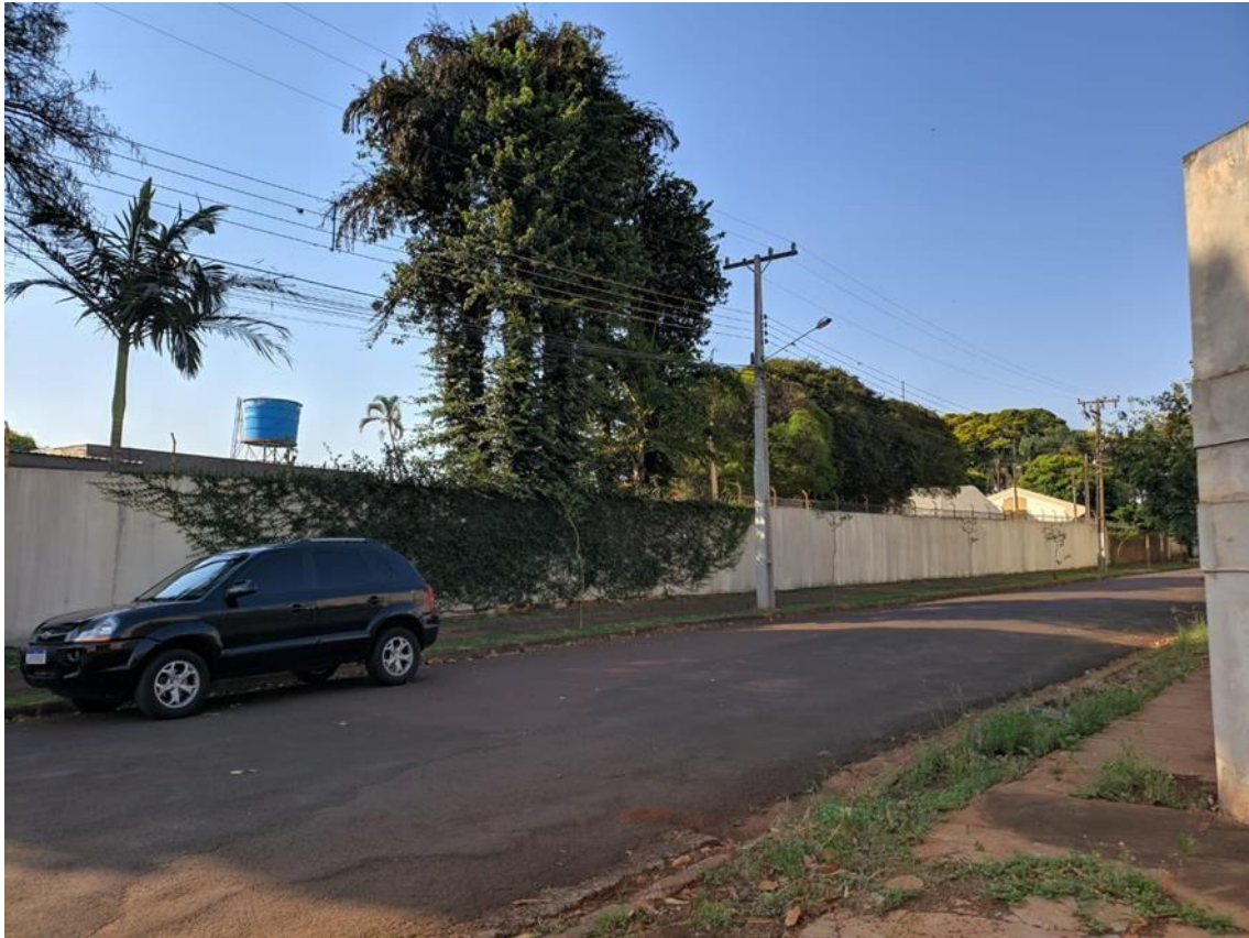
Figura 16 – Muro do empreendimento, localizado na Rua Isaías Canete, nº 530.
