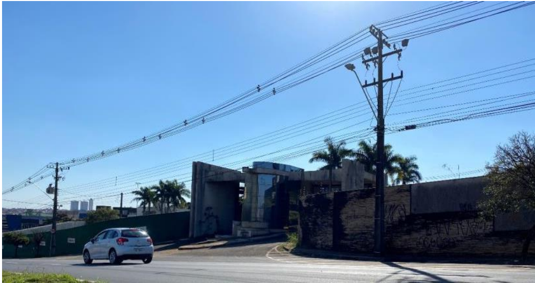
Figura 51: Poste de iluminação em frente ao empreendimento. Fonte: Master Ambiental, 2021.
