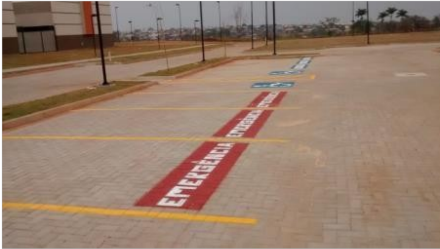
Figura 97: Vagas demarcadas para emergência. Fonte: Master Ambiental, 2016.
