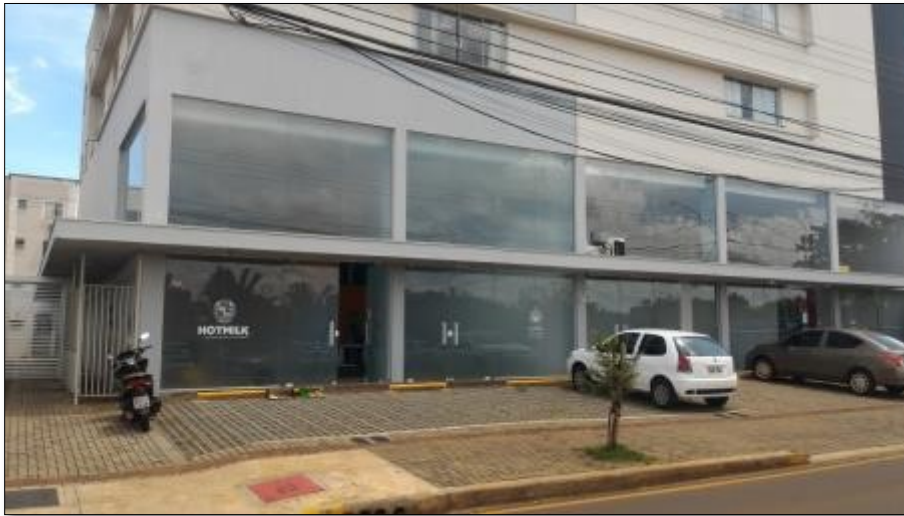
Figura 42: Lançamento Imobiliário na Av. Jockey Club, em frente ao empreendimento. Fonte: Master Ambiental, 2018.
