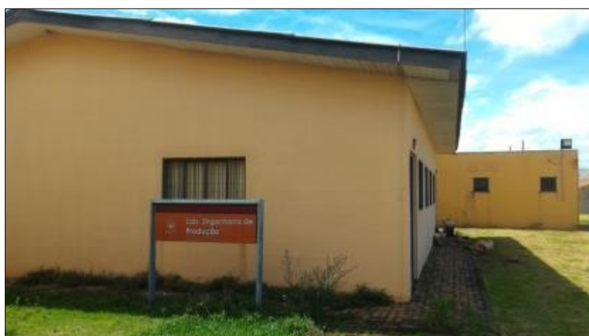
Figura 7: Laboratório de Engenharia de Produção. Fonte: Master Ambiental, 2018.
