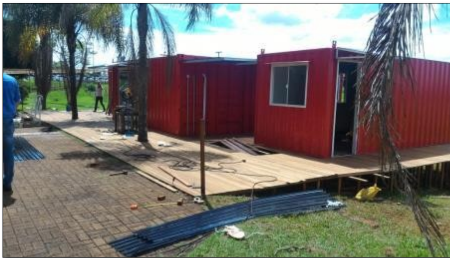
Figura 13: Anexo ao Bloco Didático em obras. Fonte: Master Ambiental, 2018.
