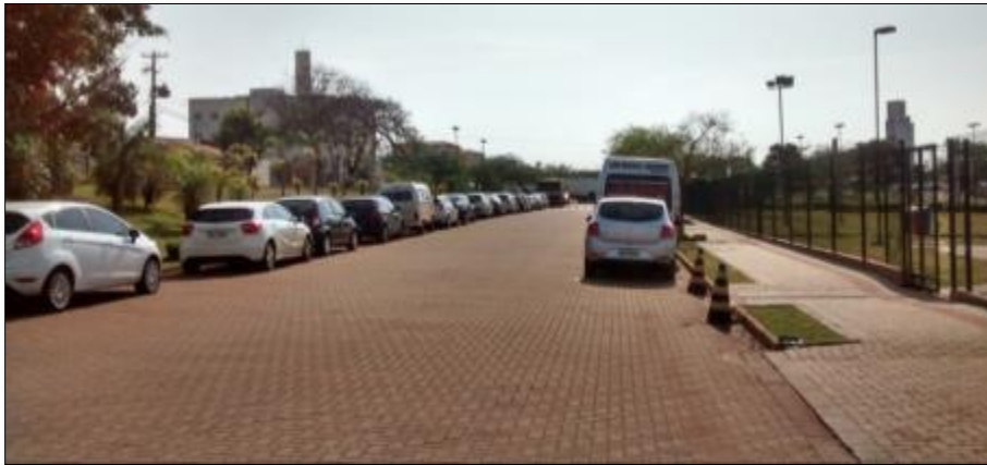
Figura 64: Trecho duplicado da Avenida Jockey Club, em frente ao empreendimento PUC. Fonte: Master Ambiental, 2018.
