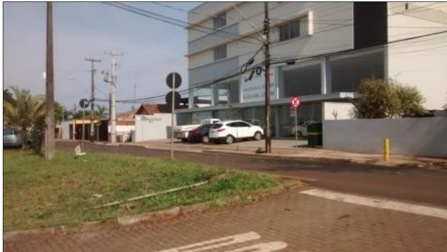
Figura 37: Empreendimento misto residencial, comercial e serviços – Av. Jockey Club. Fonte: Master Ambiental, 2018.
