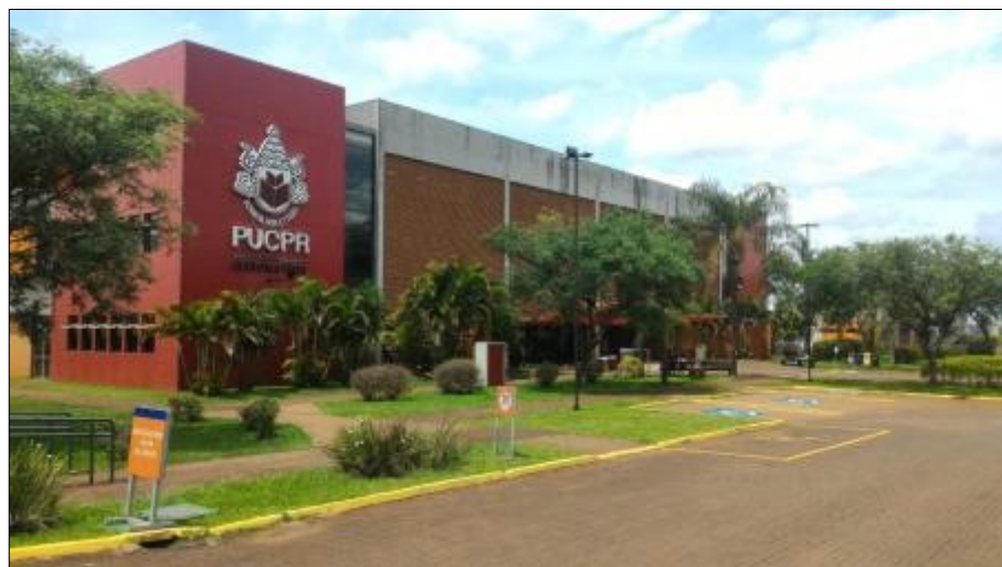
Figura 54: Fachada principal do empreendimento. Fonte: Master Ambiental, 2018.
