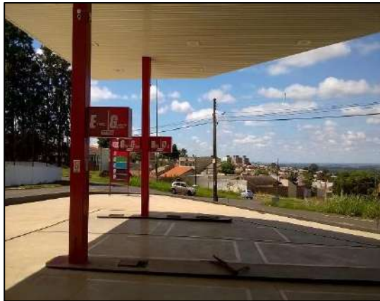
Figura 9: Posto já finalizado.
