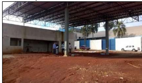
Figura 4: Posto em construção.
