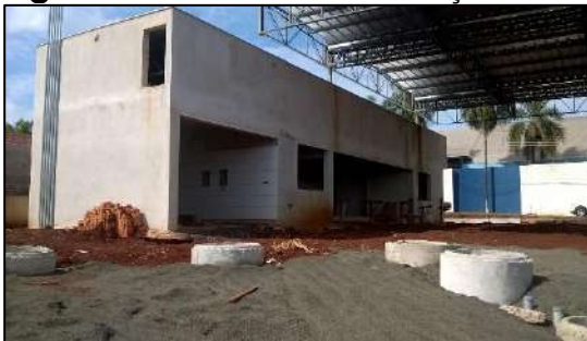
Figura 5: Loja de conveniência em construção.
