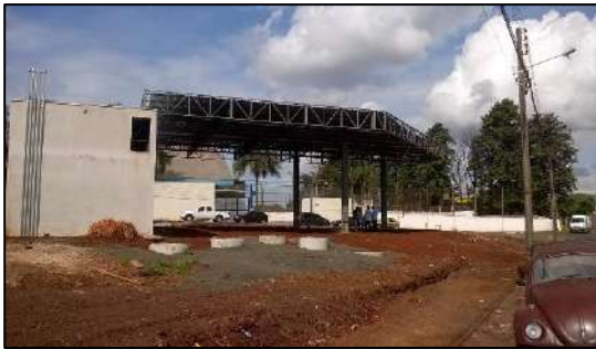
Figura 1: Posto em construção.
