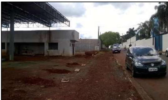
Figura 3: Posto em construção.
