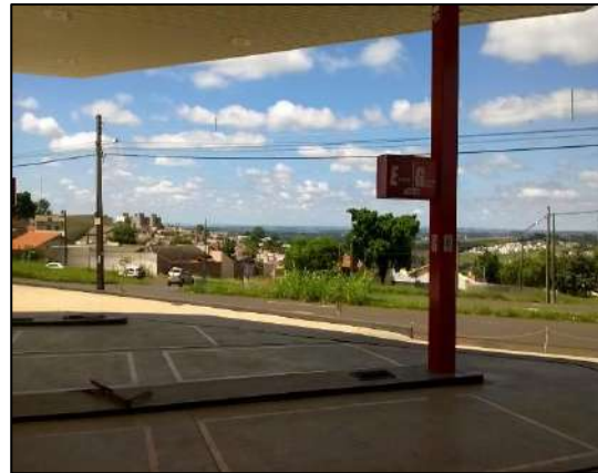
Figura 10: Área interna com acabamento.
