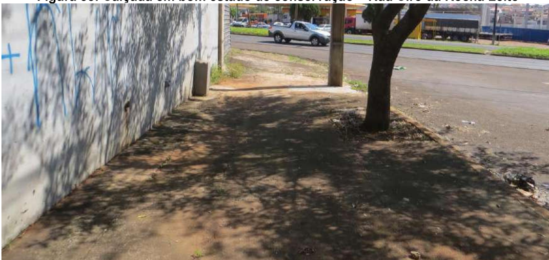
Figura 55: Calçada em bom estado de conservação – Rua Ciro da Rocha Leite
