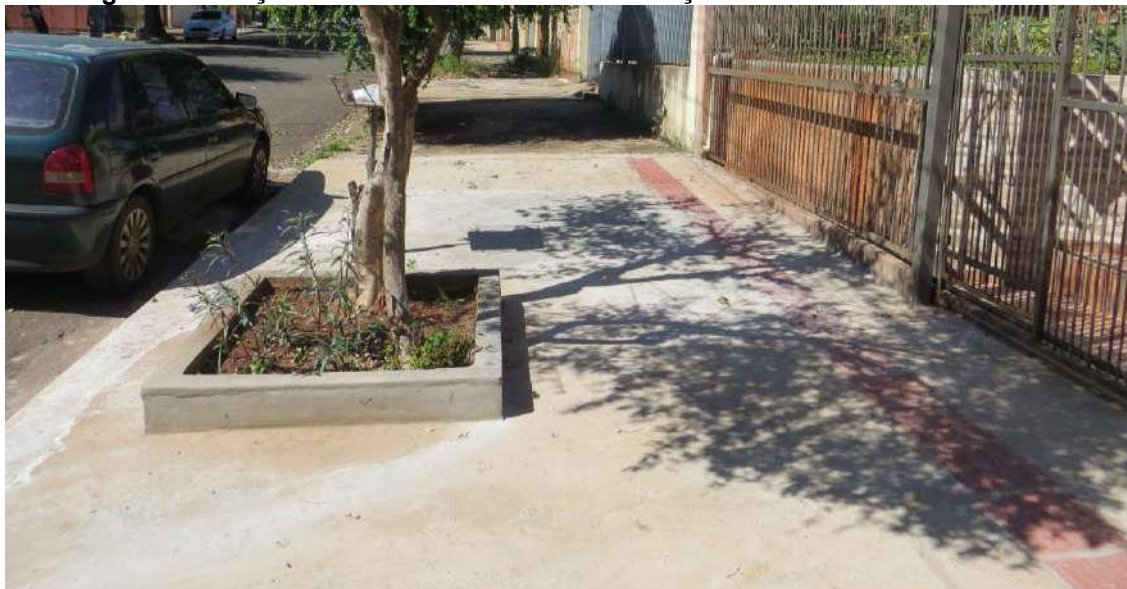
Figura 56: Calçada em bom estado de conservação – Rua Ciro da Rocha Leite
