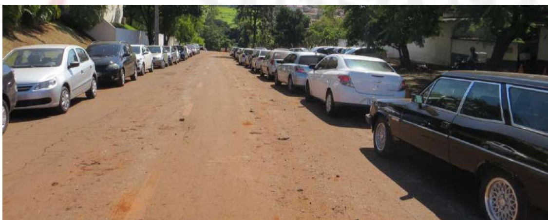
Figura 52: Sinalização Horizontal desgastada – R. Jair Assunção
