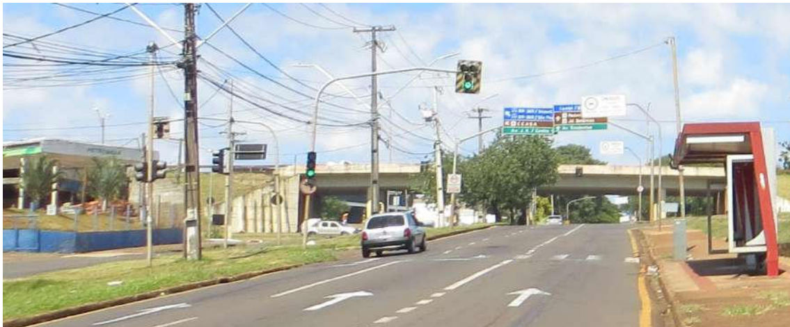
Figura 71: Sinalização horizontal desgastada – Ponto de parada tipologia 2
