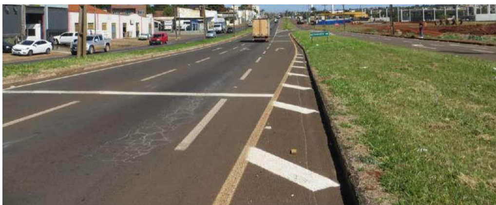
Figura 46: Sinalização horizontal em bom estado – Av. Brasília
