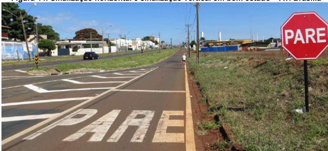
Figura 44: Sinalização horizontal e sinalização vertical em bom estado – Av. Brasília
