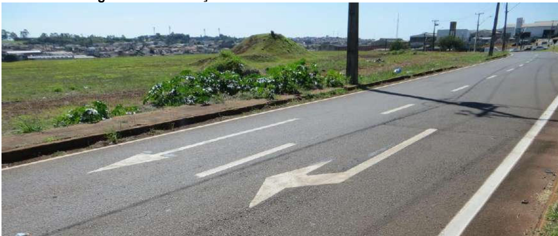
Figura 45: Sinalização horizontal em bom estado – Av. Brasília
