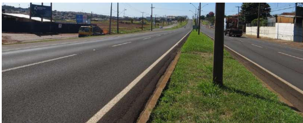
Figura 47: Sinalização Horizontal em bom estado – Av. Brasília
