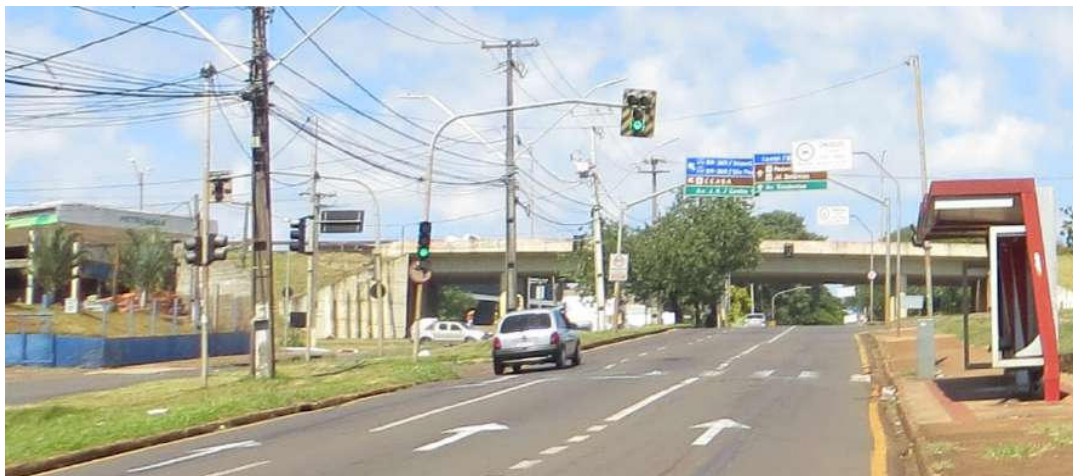
Figura 51: Sinalização Horizontal desgastada – Av. Winston Churchill x Av. Rio Branco
