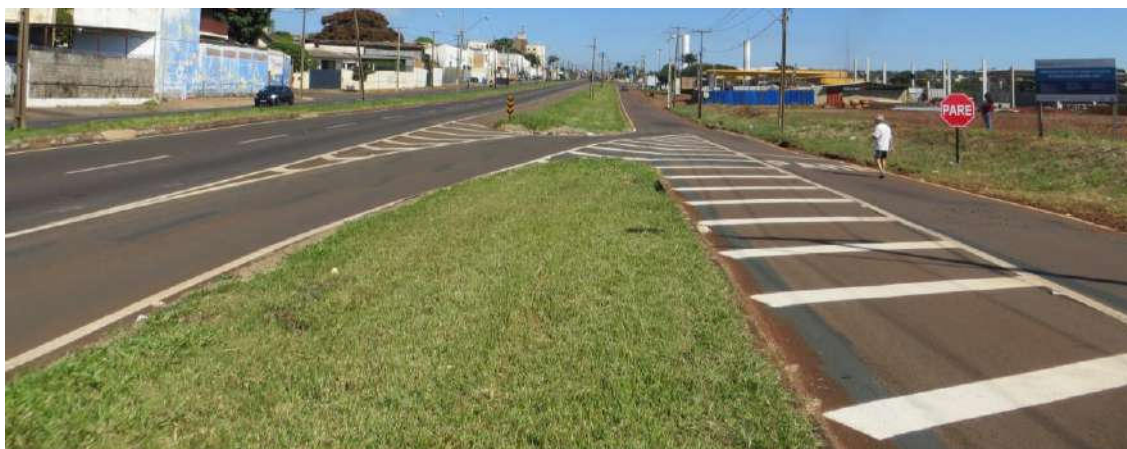
Figura 43: Sinalização horizontal em bom estado – Av. Brasília
