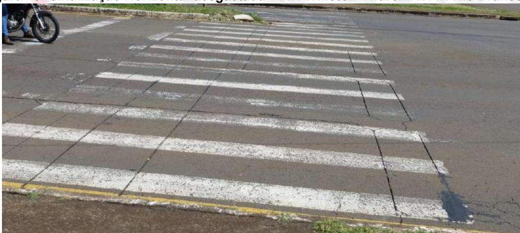
Figura 49: Sinalização Horizontal desgastada – Av. Winston Churchil x Av. Rio Branco
