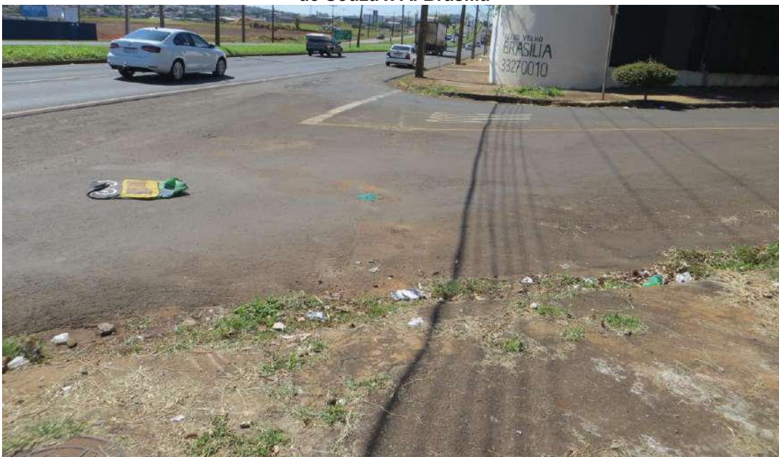
Figura 58: Travessia de pedestres sem sinalização e acessibilidade – Rua Gumercindo de Souza x A. Brasília
