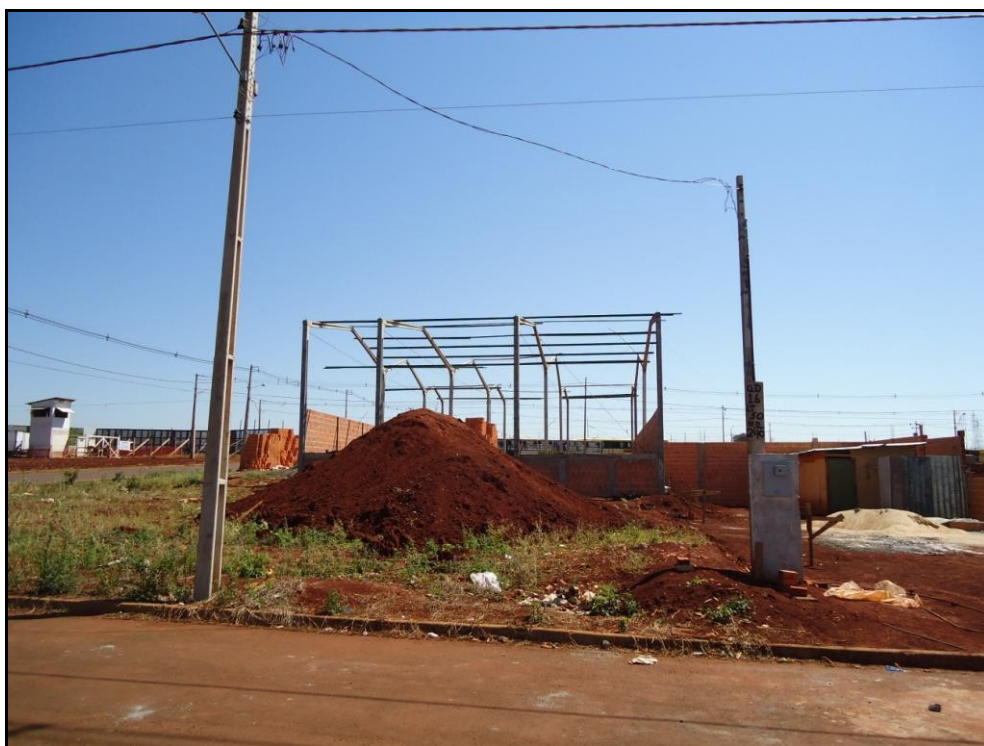
Foto 5 – Fundos do empreendimento e postes de fornecimento de energia elétrica
