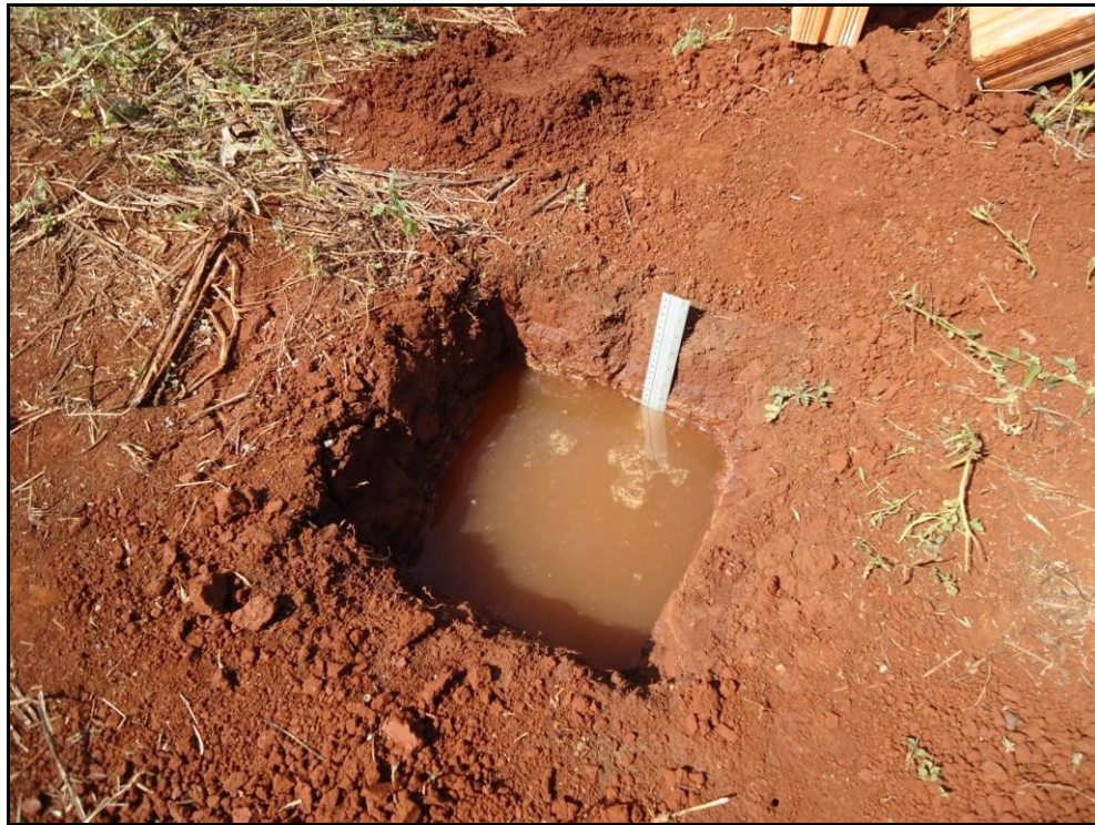
Foto 3 – Rebaixamento do nível de água durante teste de percolação
