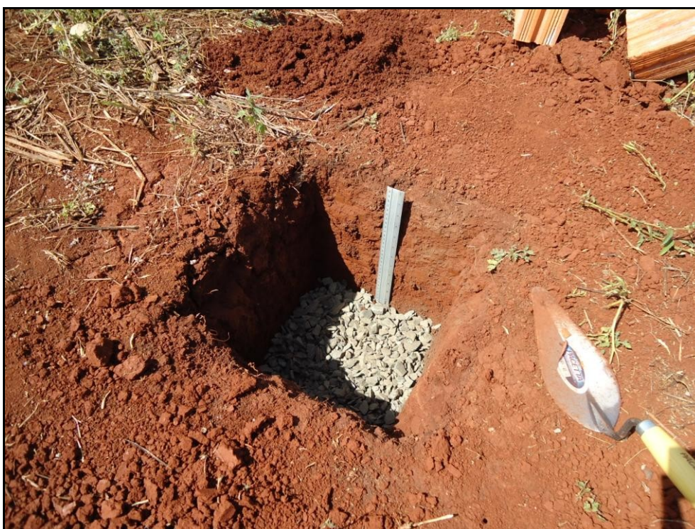
Foto 2 – Preparação da cava para elaboração do teste de percolação
