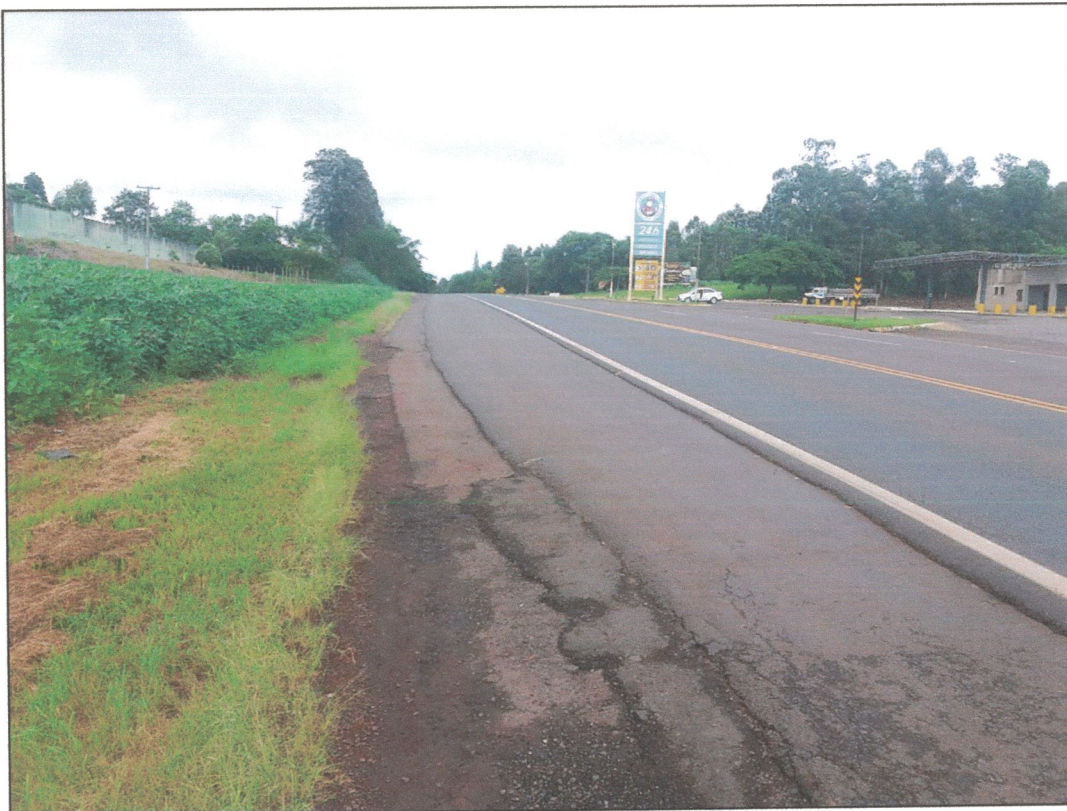
Figura 5 – Via PR 323 / acesso empreendimento Fonte – Cs consultoria Ambiental
