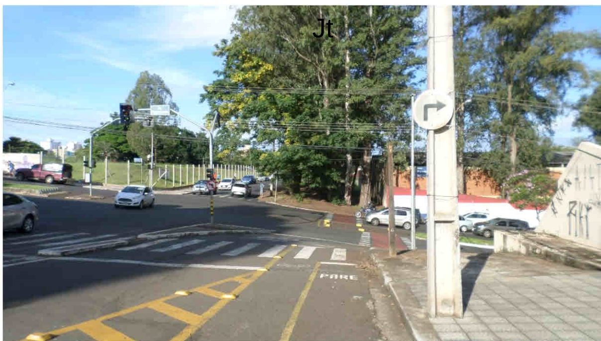
Figura 40: Sinalização horizontal e vertical na Av. Amintas de Barros com a Av. Higienópolis. Fonte: Autor, 2017.
