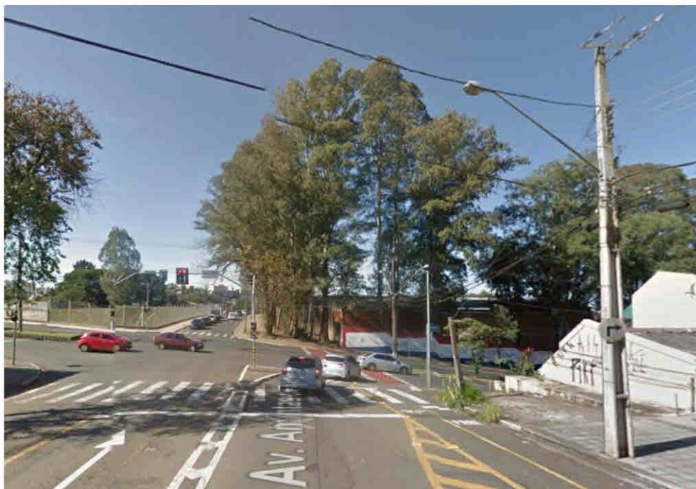
Figura 20: Iluminação pública na Av. Amintas de Barros. Fonte: Autor, 2017.
