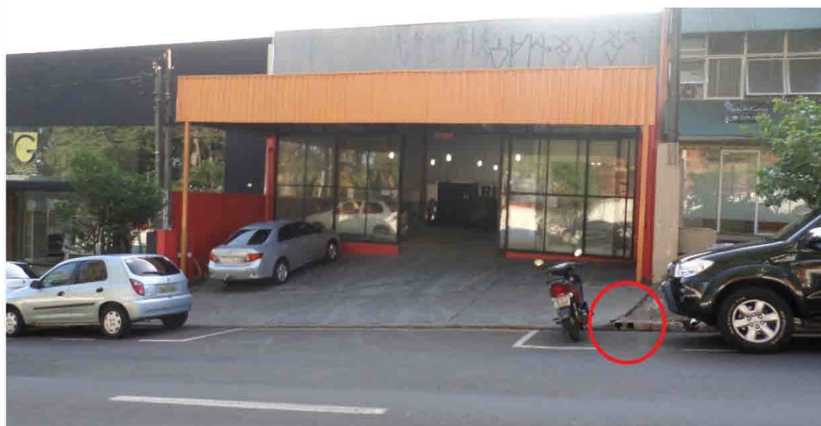
Figura 15: Saída de águas pluviais do empreendimento na calçada. Fonte: Autor, 2017
