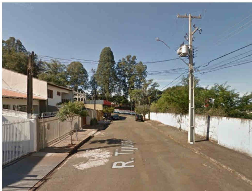
Figura 19: Iluminação pública na Rua Tijuca. Fonte: Autor, 2017.
