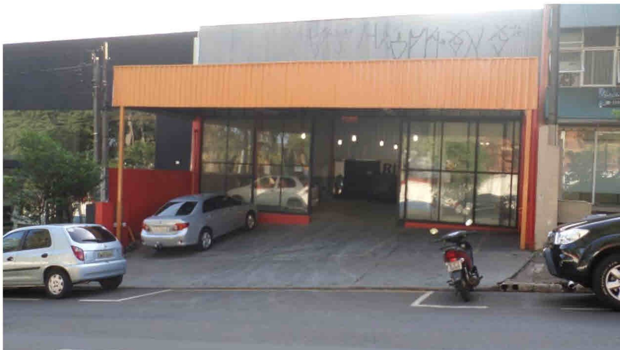
Figura 33: Estacionamento de veículos do empreendimento. Fonte: Autor, 2017.
