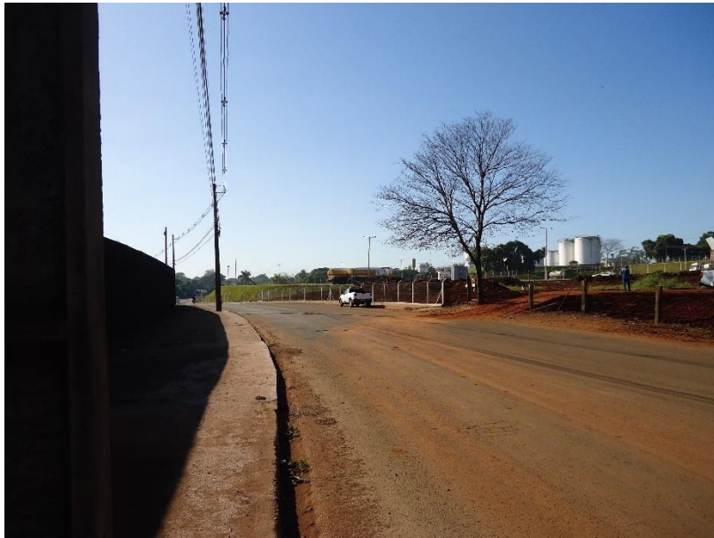
Foto 12 – Sinalização horizontal na via inexistente
