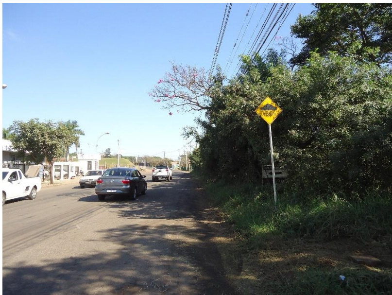
Foto 11 – Sinalização vertical precária
