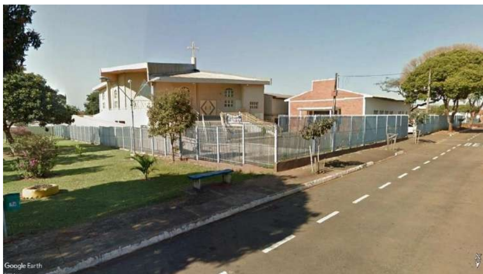
Figura 57: Paróquia Nossa Senhora do Carmo. Fonte: Google Earth, 2021.
