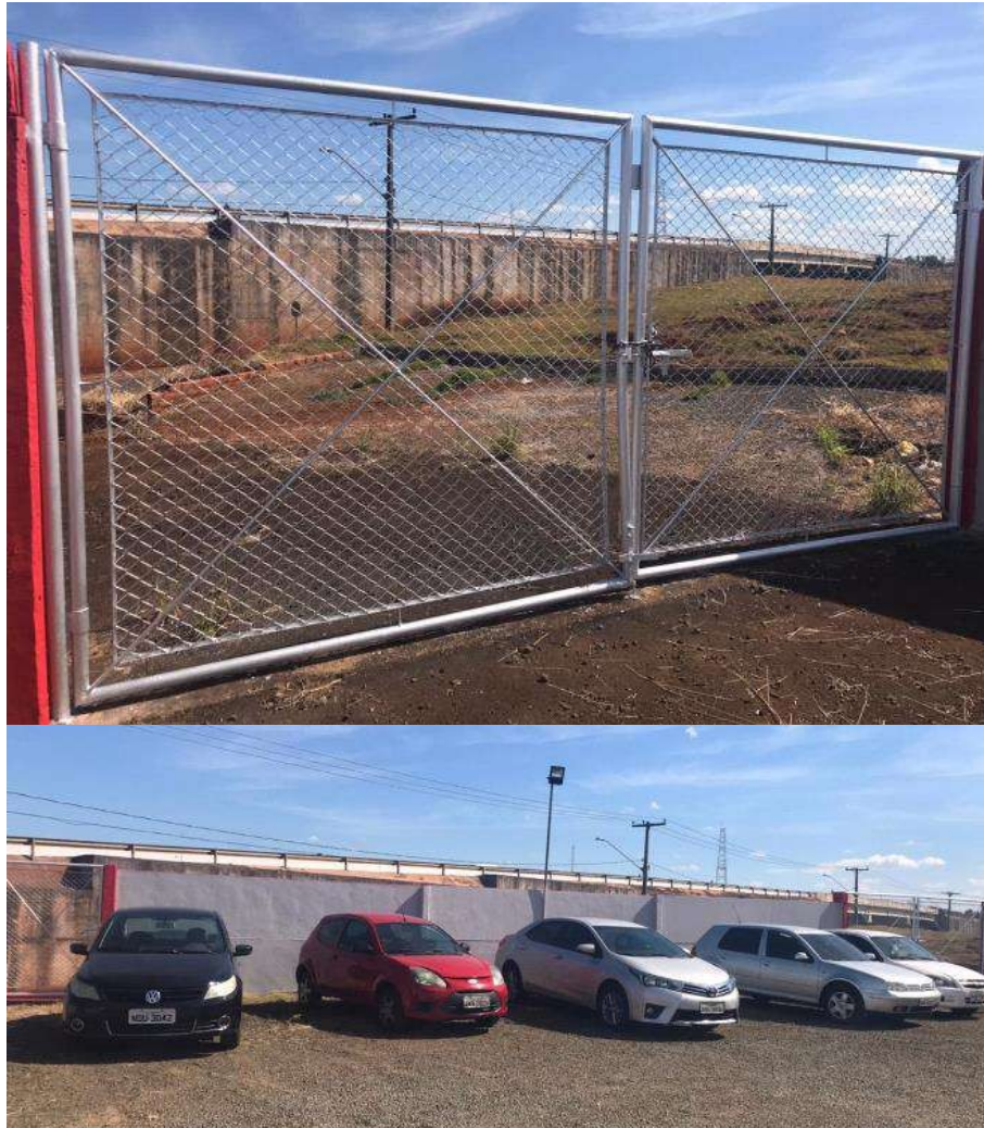
Figura 70: Portões desativados. Fonte: Master Ambiental, 2021.
