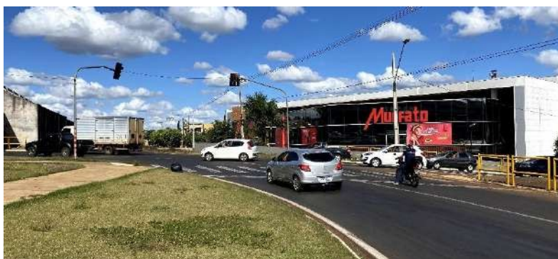
Figura 33: Empreendimento do Supermercado Muffato. Fonte: Master Ambiental, 2021.
