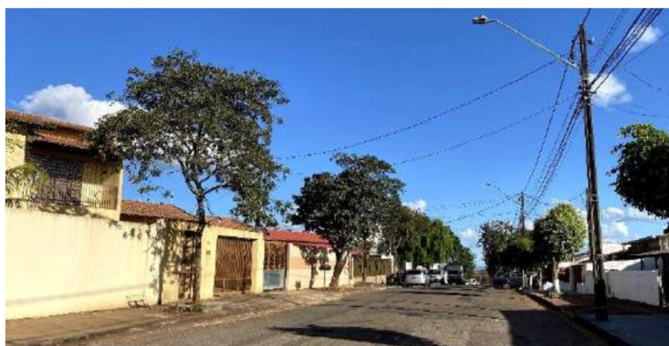
Figura 38: Usos residenciais unifamiliares na Rua Serafim França. Fonte: Master Ambiental, 2021.
