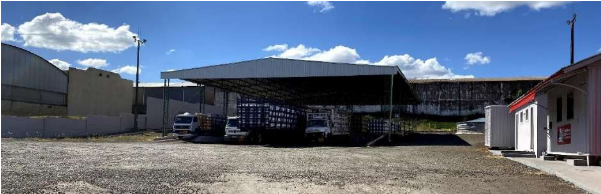
Figura 51: Imagem da edificação sem fechamentos. Fonte: Master Ambiental, 2021.
