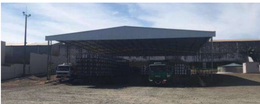
Figura 66: Estacionamento de carga/descarga. Fonte: Master Ambiental, 2021.
