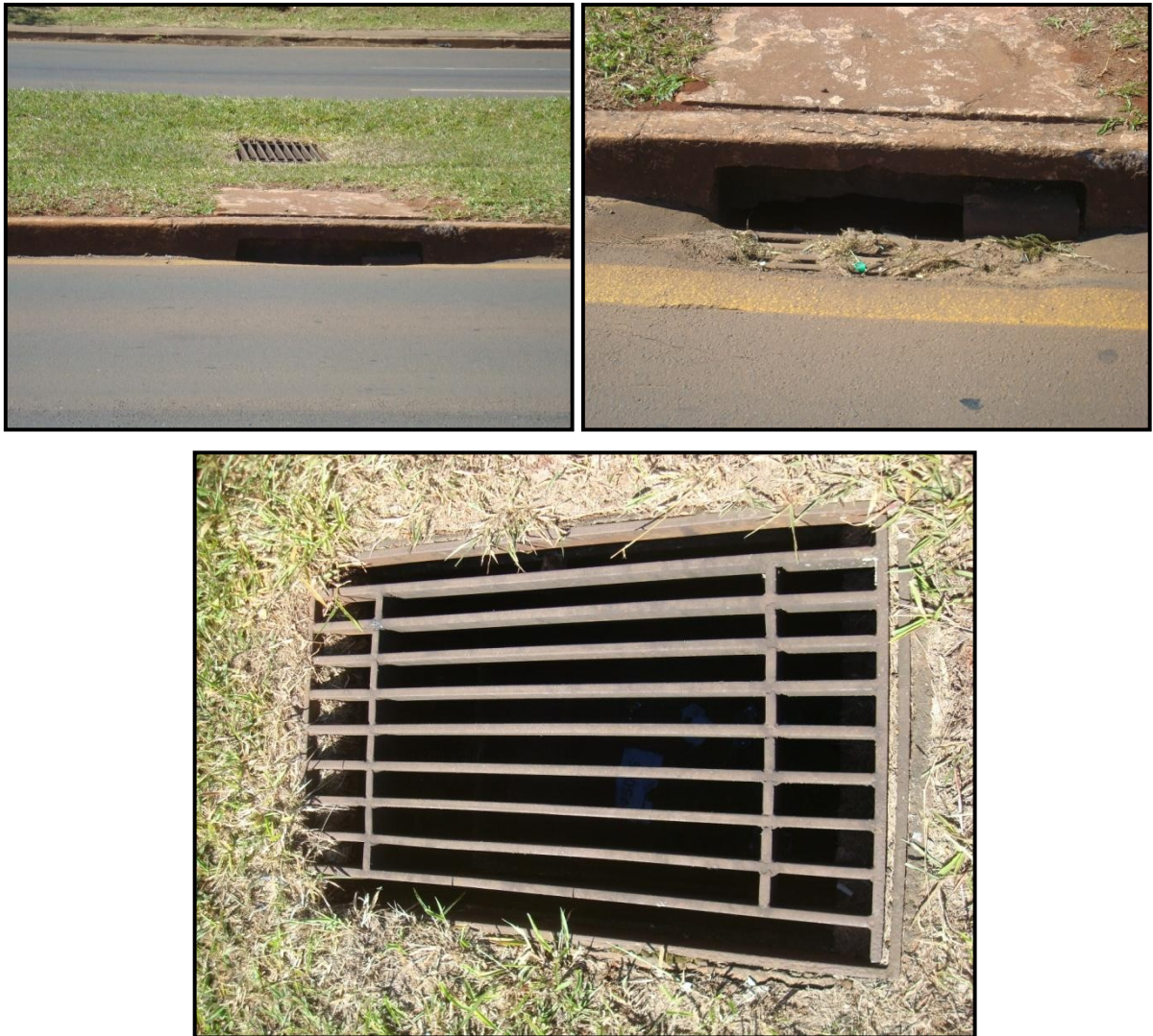
Figura 24 – Bocas de lobos e bueiros que existentes ao redor do empreendimento
