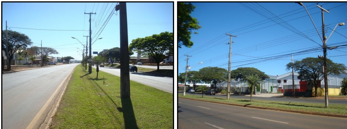
Figura 27 – Fiação elétrica existente na vizinhança da Giro Londrina.
