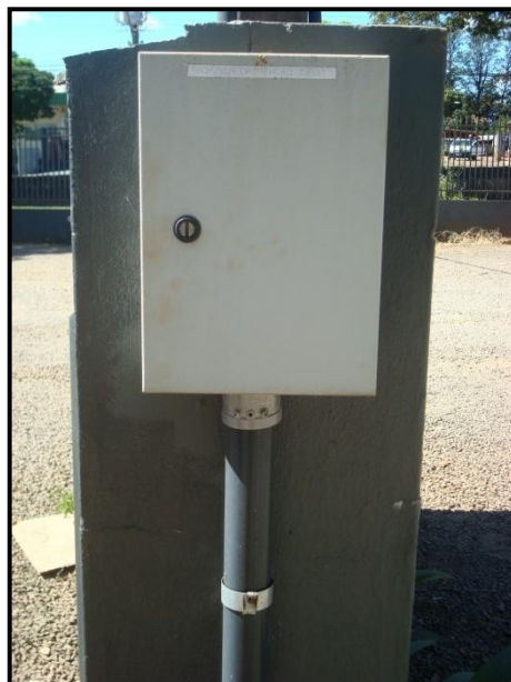
Figura 32 – Bomba destinada para incêndio, existente no pátio da empresa.
