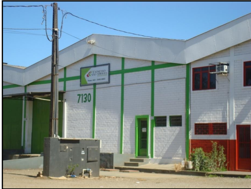
Figura 31 – empreendimento existente na mesma quadra da empresa Giro Londrina.
