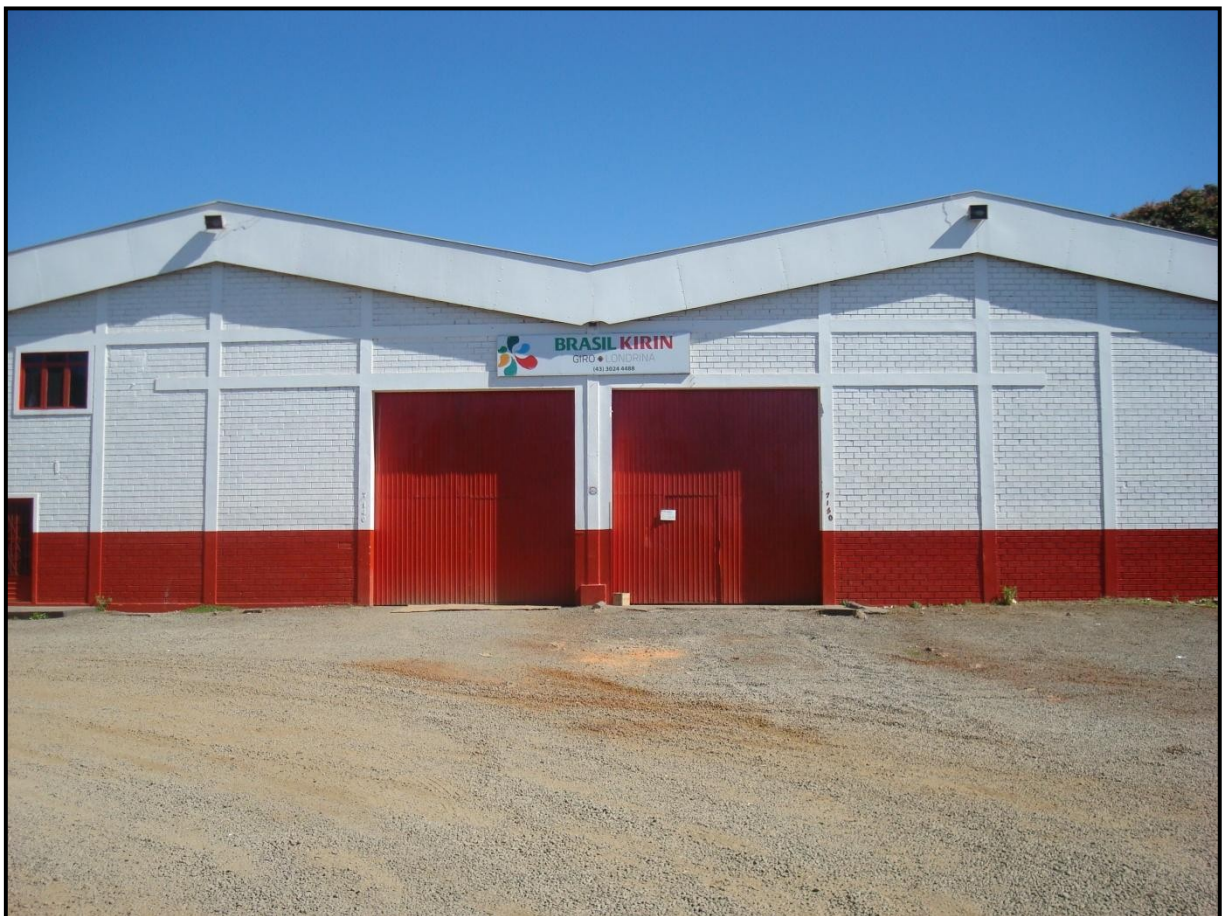
Figura 3 – Vista frontal do empreendimento.
