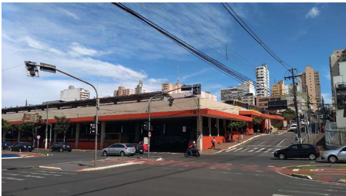
Figura 122: Terminal Urbano Central. Fonte: Master Ambiental, 2022.
