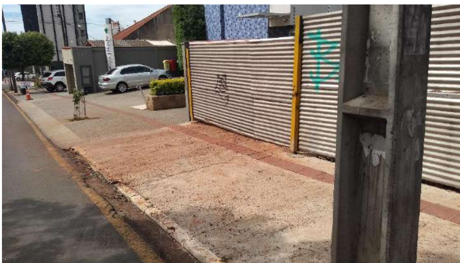
Figura 153: Acesso de Veículos ao Canteiro de Obra. Fonte: Master Ambiental (2022).
