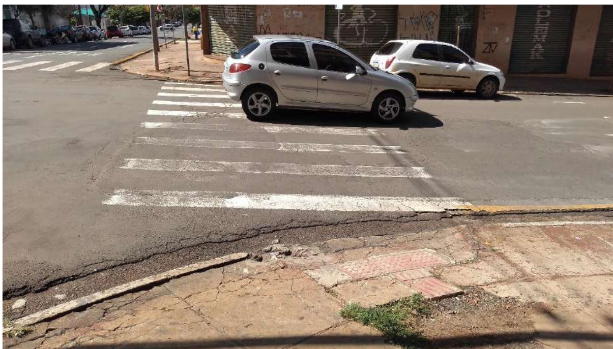
Figura 147: Rampa de acessibilidade no passeio público do entorno do empreendimento. Fonte: Master Ambiental, 2022.
