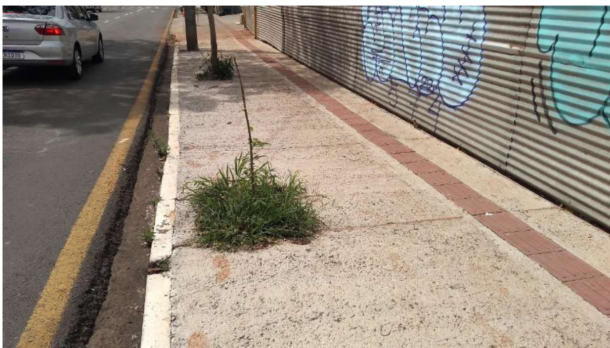
Figura 139: Calçada limite ao lote do empreendimento na testada da Rua Prof. Hugo Cabral. Fonte: Master Ambiental, 2022.
