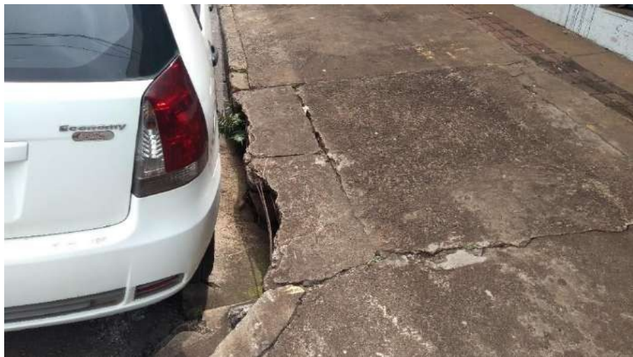
Figura 61: Boca de lobo – Rua Fernando de Noronha com Av. Arcebispo Dom Geraldo Fernandes. Fonte: Master Ambiental (2022).
