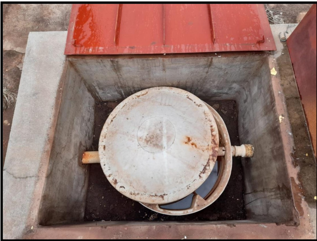
Figura 24. CSAO Modelo Industrial com placas coalescentes
