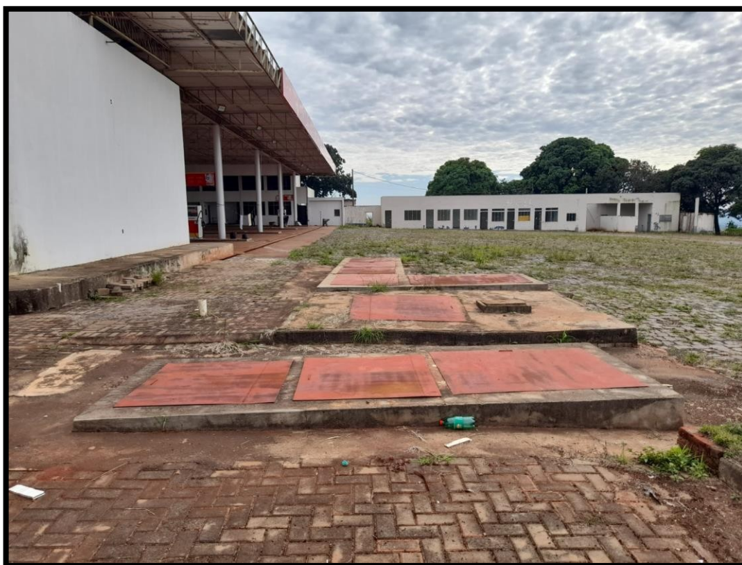
Figura 16. Local de instalação da CSAO e Cisterna
