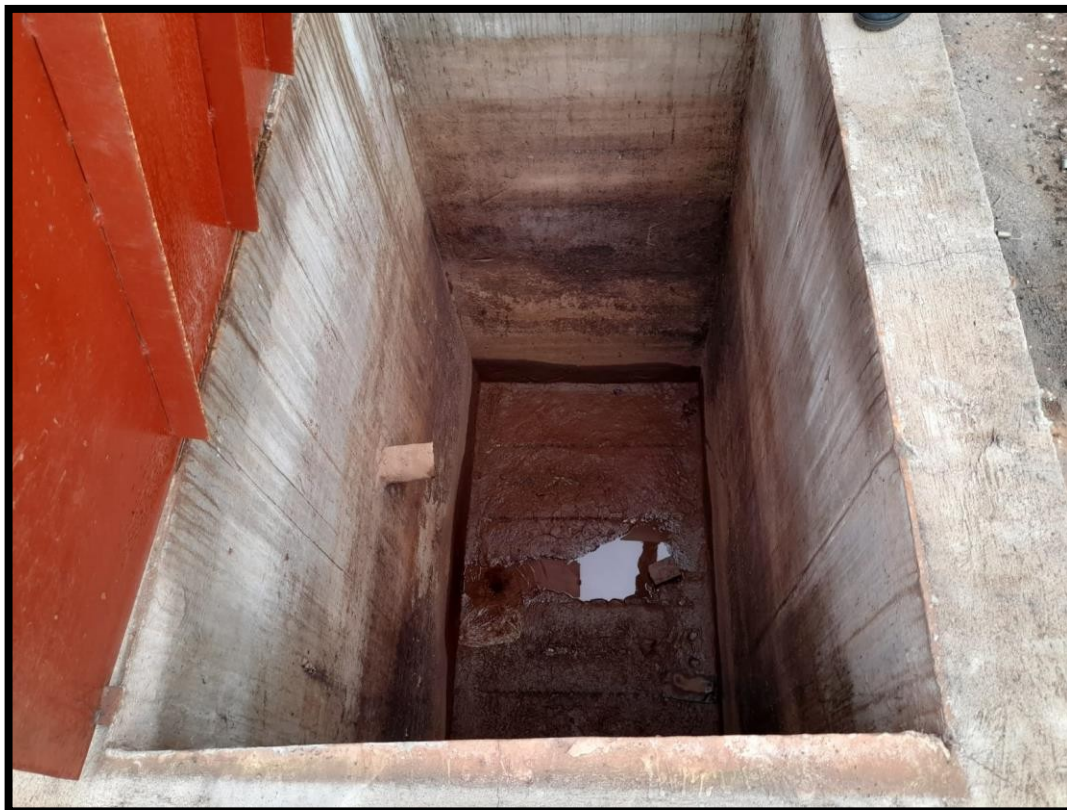
Figura 25. Cisterna em Alvenaria instalada no local
