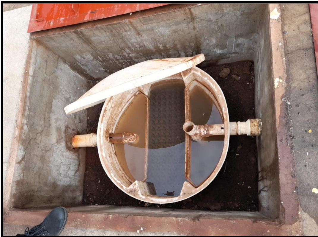
Figura 23. CSAO Modelo Industrial com placas coalescentes
