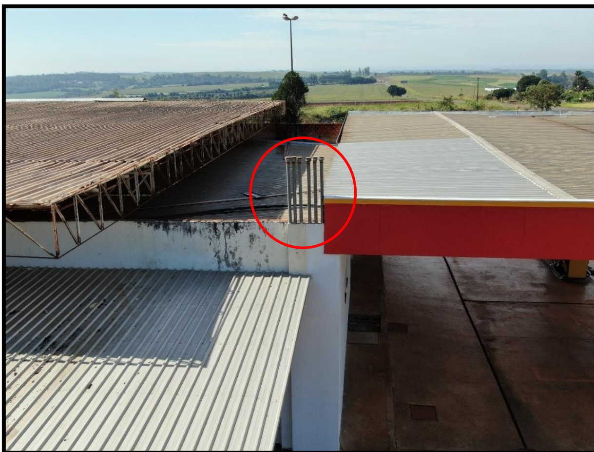
Figura 14. Sistema de respiros dos tanques (destacado com o círculo em vermelho)
