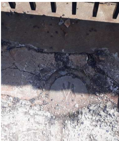
Figura 33: Dispositivo Tubular de Inspeção - DTI, rua Roberto Romanelli.
