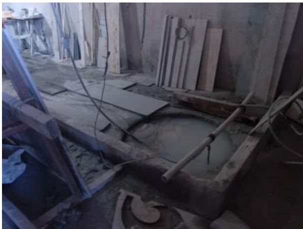
Figura 25: Tanque de corte com serra circular em úmido.
