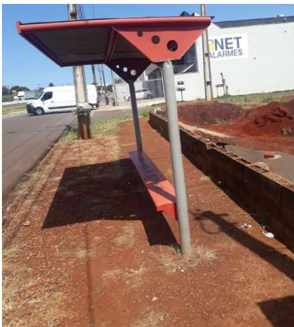
Figura 52: Ponto de ônibus na rua Roberto Romanelli.
