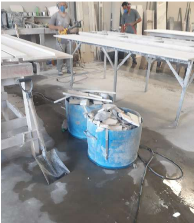
Figura 27: Piso com transbordamento de água da mesa de corte. Fonte: Elaborado pelas autoras, 2023.
