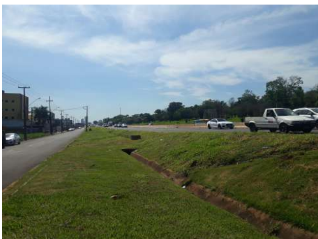
Figura 30: Valeta no canteiro central da Rod. Celso Garcia Cid.
