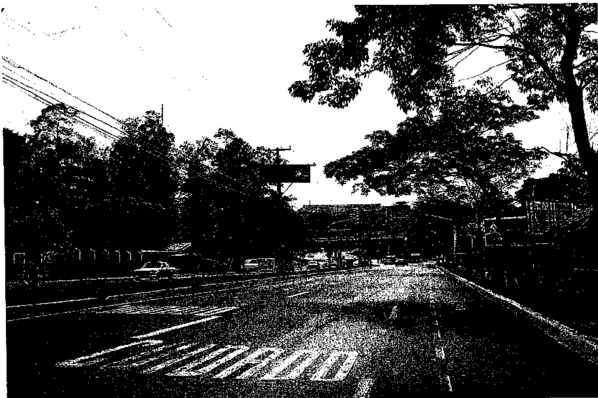
FOTO 10 – AV. MADRE LEÔNIA MILITO – ACESSO AOS LOTES.
