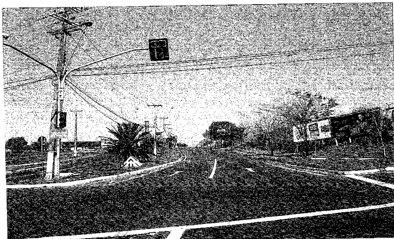
FOTO 15: Rod. Mabio G. Palhano – sob o Viaduto da PR445
