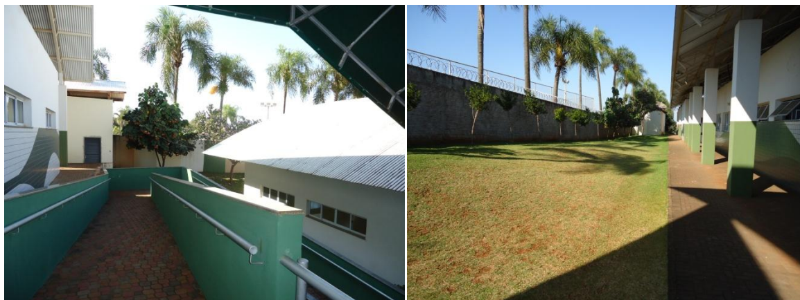
Figura 12: Vista da arborização interna da Escola St. James, em Londrina PR.
