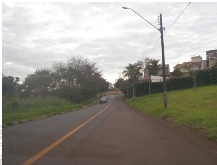
Figura 58: Avenida Ruy Ferraz de Carvalho e a sinalização viária horizontal existente no local.
