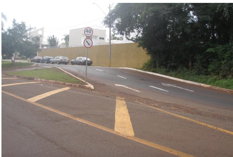
Figura 51: Local de início do canteiro central da Avenida Gil de Abreu e Souza, em Londrina PR e a sinalização vertical.
