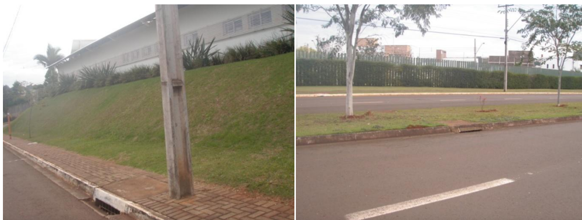
Figura 28: Bocas de lobo na Avenida Gil de Abreu Souza, em frente ao empreendimento.
