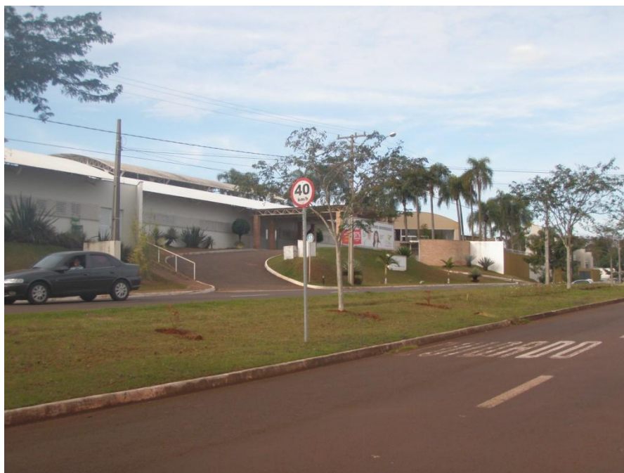
Figura 27: Vista frontal do empreendimento, com a infraestrutura de pavimentação instalada.
