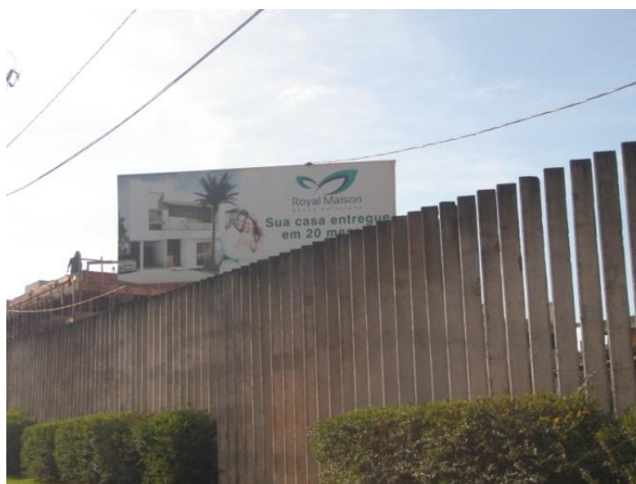
Figura 9: Vista do novo condomínio, em fase de instalação ao lado da Escola St. James, em Londrina PR.
