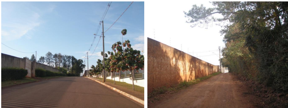
Figura 57: Vista da via lateral ao terreno da Escola St. James e a falta de sinalização vertical e horizontal e a parte não pavimentada, respectivamente.
