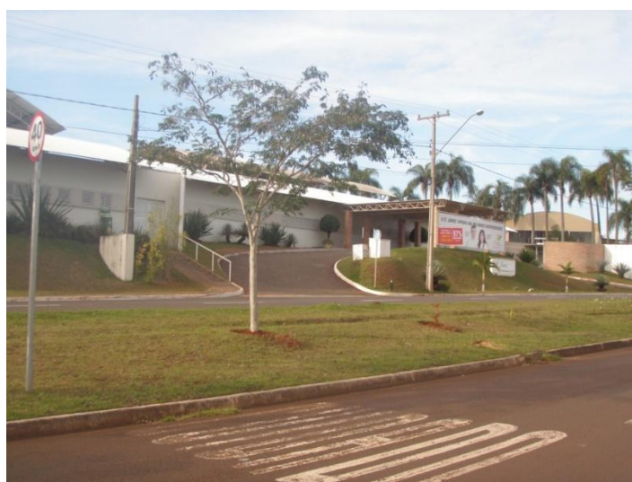
Figura 68: Vista da saída da baía de acomodação, presente na Escola St. James.
