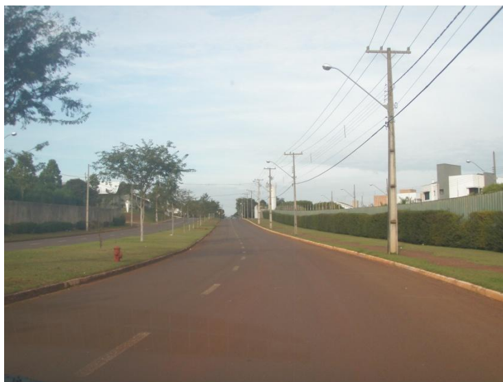
Figura 29: Detalhe das instalações de iluminação pública.
