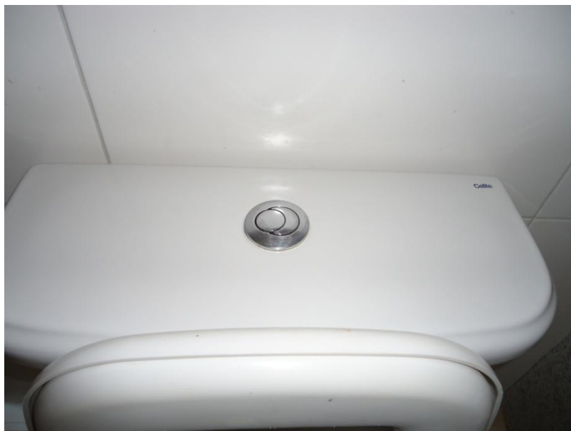
Figura 63: Vista da válvula de dois fluxos nos sanitários da primeira expansão da Escola St. James, em Londrina PR.
