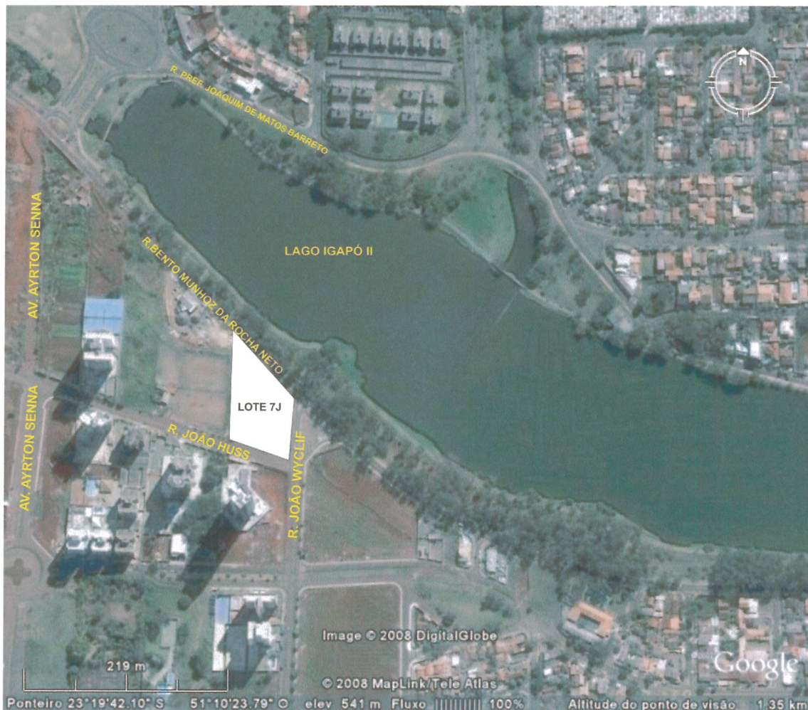
Foto n. 06 – Arruamento no entorno do Lote.
