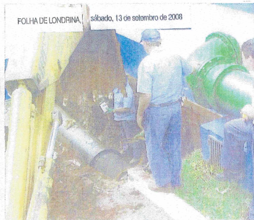
Tubos da nova rede de captação serão instalados em 15 dias; obra tem 4,3 km de extensão
