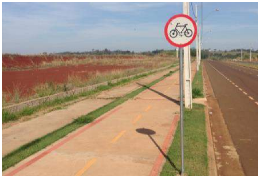
Figura 82: Ciclovia situada na Rua 01, na Área de Influência Direta do Empreendimento. Fonte: Master Ambiental, 2018.
