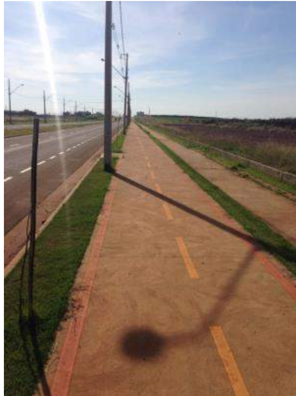
Figura 75: Passeio público com mudas recém-plantadas na Rua 01. Fonte: Master Ambiental, 2018.
