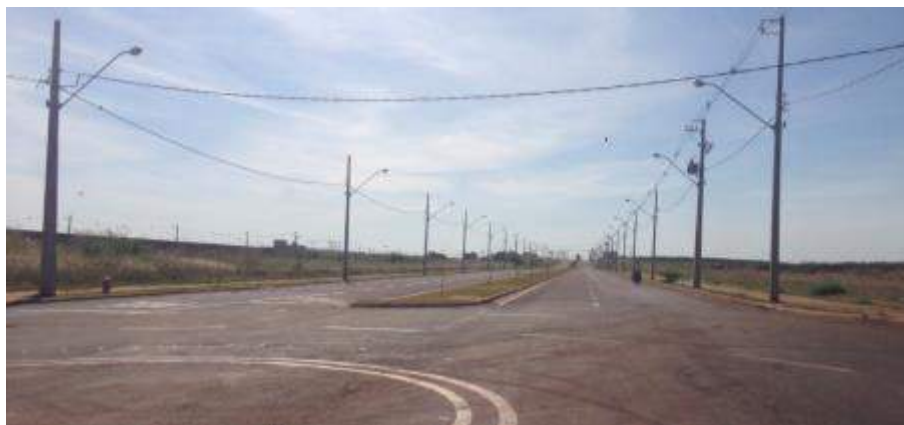
Figura 60. Rua 01, trecho dotado de infraestrutura. Fonte: Master Ambiental, 2018.
