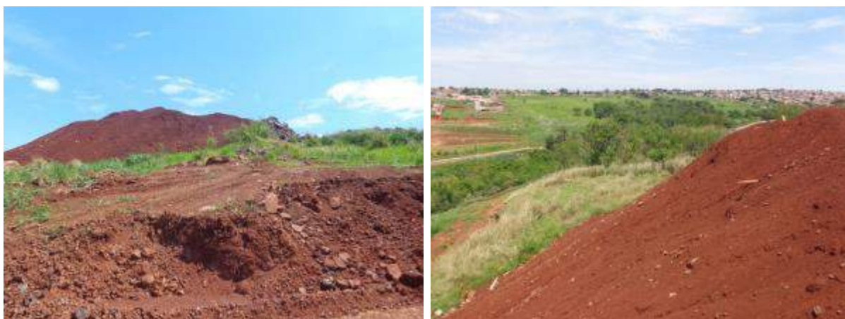
Figura 19: Solo depositado no lote. Fonte: Master Ambiental, 2019.
