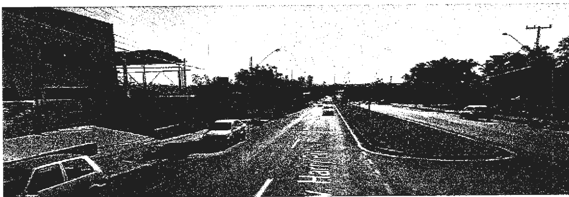
Avenida Harry Prochet principal via acesso ao empreendimento
