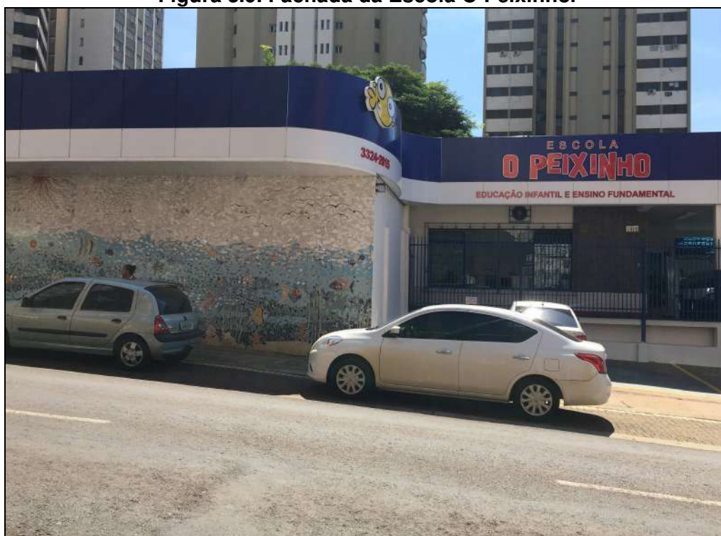
Figura 3.9. Fachada da Escola O Peixinho.
