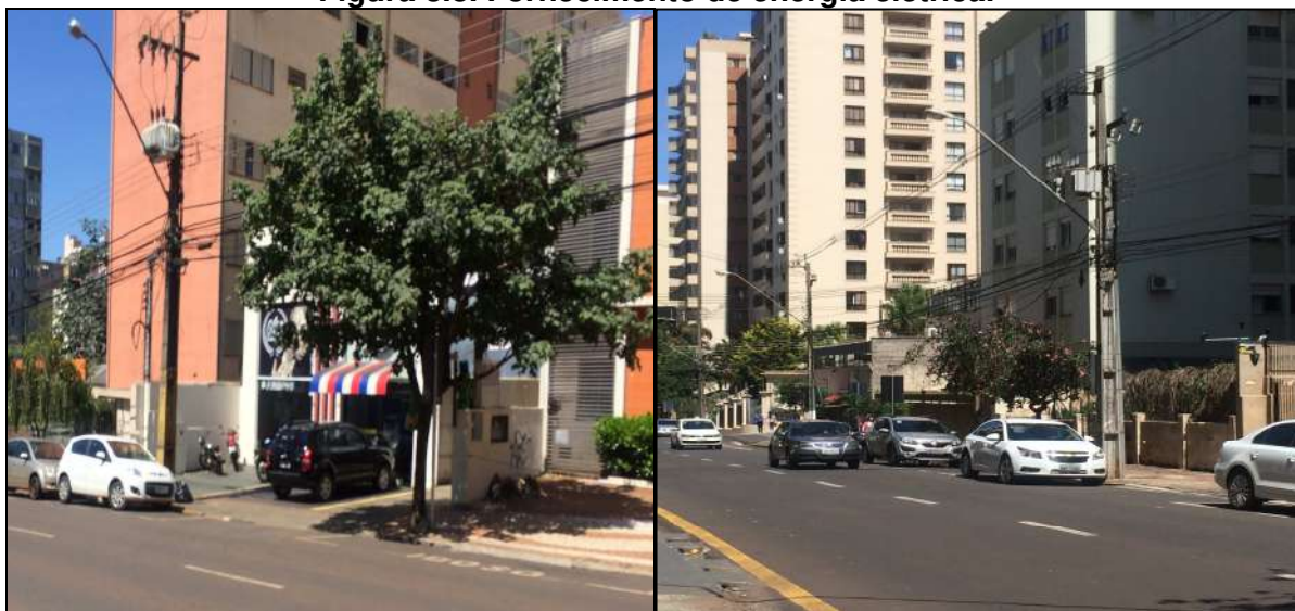
Figura 3.8. Fornecimento de energia elétrica.
