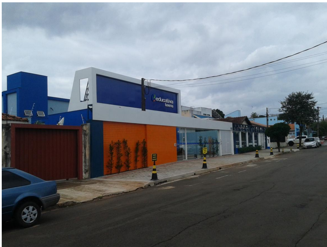
Figura 4 - Fachada do empreendimento, em destaque, seguindo a legislação vigente. Fonte: Autor/Fev./2018.
