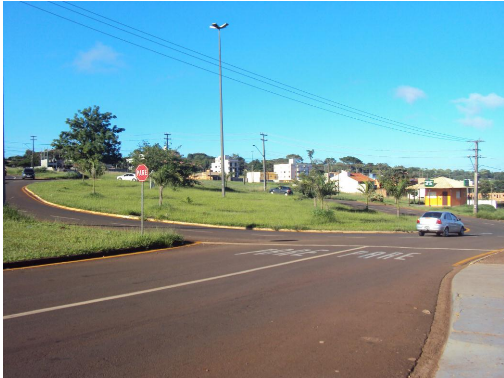
Rotatória de Acesso Av. Castelo Branco e Bairros Adjacentes
