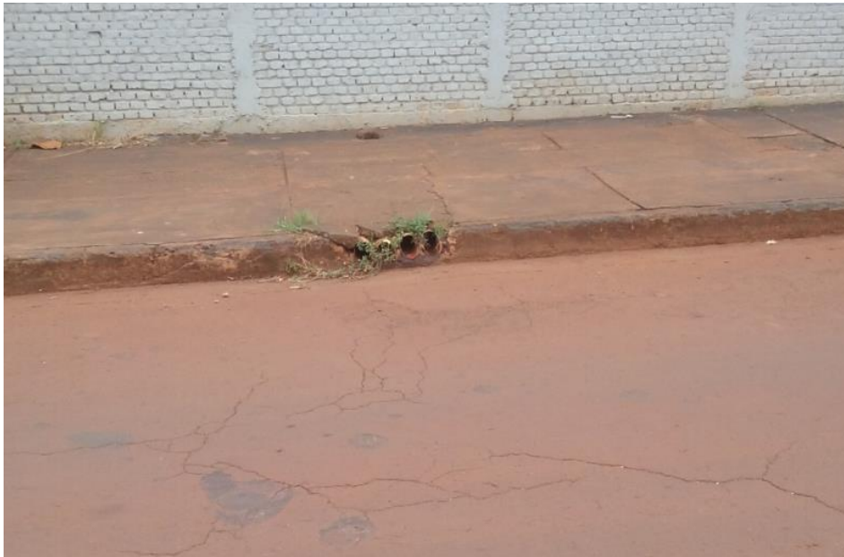
Figura 21: Saída de águas pluviais do empreendimento na calçada. Fonte: Autor, 2017.
