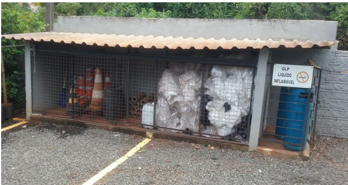
Figura 26: Local que será adequado e identificado para ser a futura Área de Transbordo Temporário de Resíduos (ATT). Fonte: Autor, 2017.
