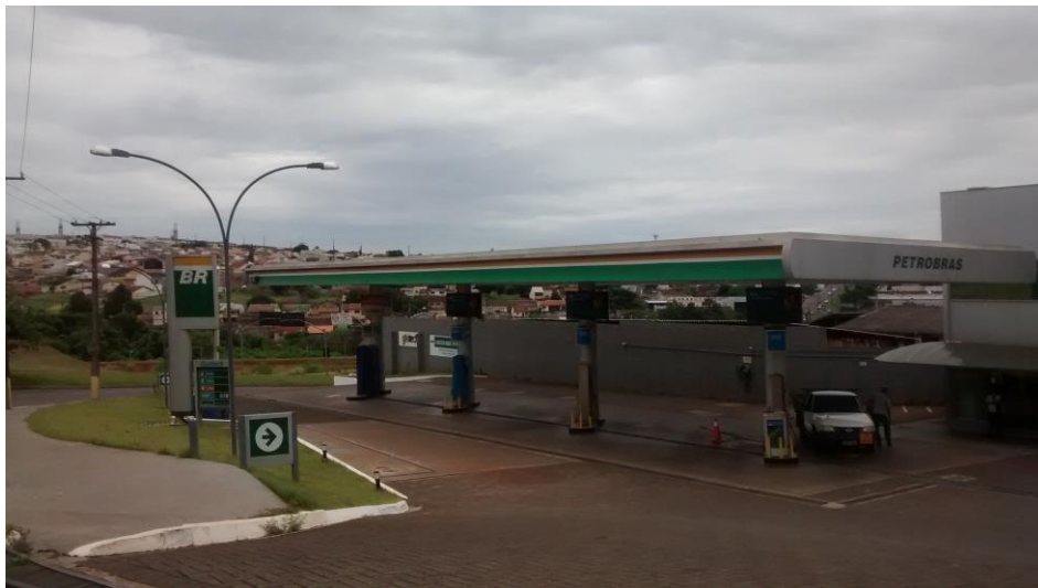
Figura 16: Posto de Combustíveis, Av. Brasília com Av. Rio Branco. Fonte: Autor, 2017.
