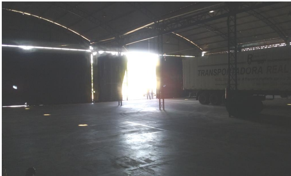
Figura 5: área interna – galpão. Fonte: Autor, 2017.
