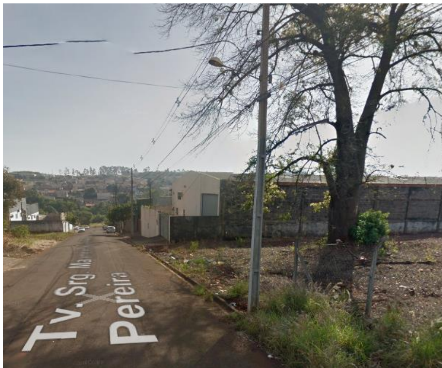
Figura 25: Iluminação pública na Rua Antônio Piovesan. Fonte: Autor, 2017.
