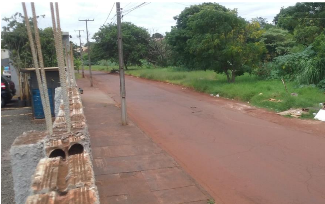
Figura 56: Talude de aterro sendo segurado pelo muro de frente do empreendimento. Fonte: Autor, 2017.
