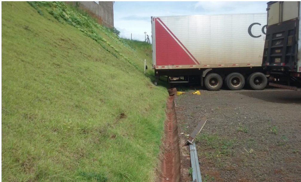
Figura 54: Talude de corte revestido por gramínea. Fonte: Autor, 2017.
