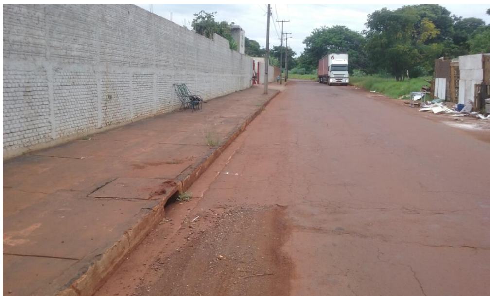
Figura 61 - Fachada do empreendimento ausente de poluição visual. Fonte: Autor, 2017.
