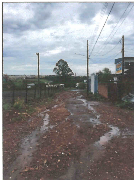
Figura 30: Condição atual da Rua Jaçanã.
