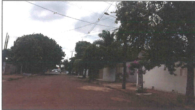
Figura 31: Pavimentação, Rua Araguari. Fonte: CS Consultoria Ambiental.
