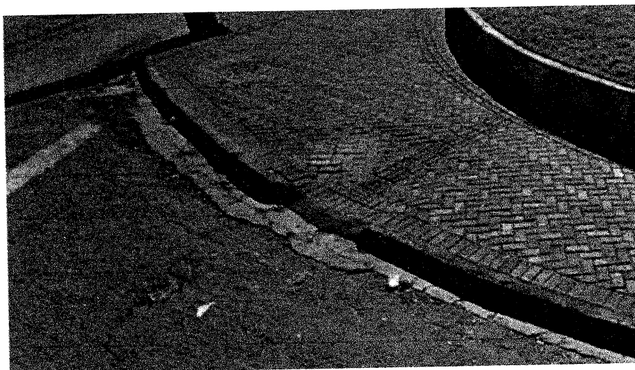
Figura 6 – Acesso de cadeirantes pela esquina da quadra. 21/12/2016. Fonte: Vítor Ricci
