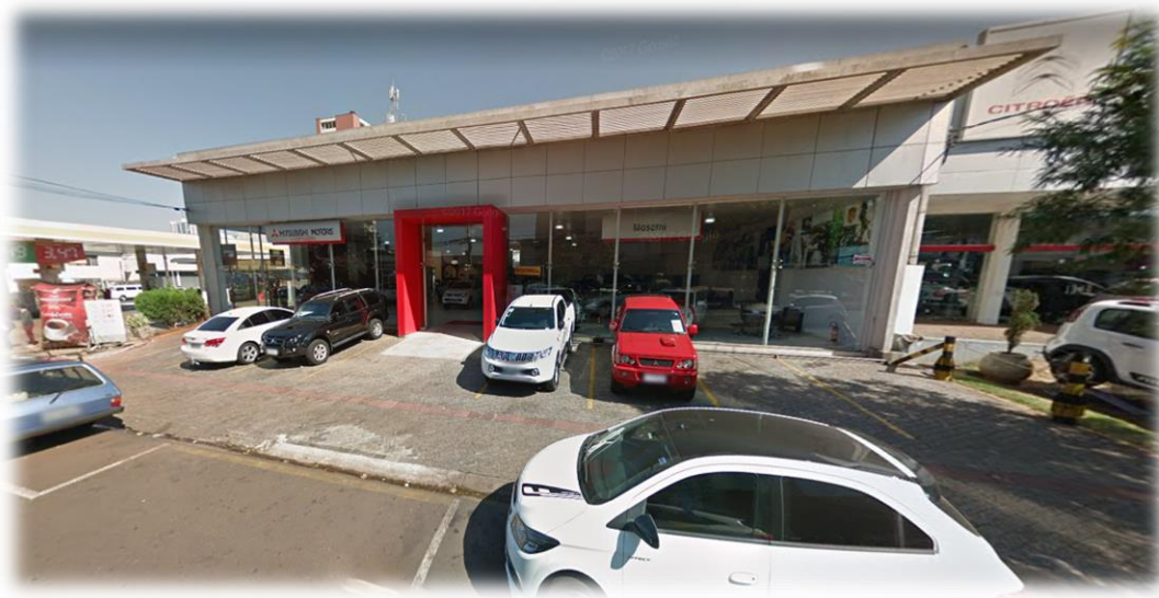
Figura 11. Iluminação natural na fachada da concessionária com vidros transparentes.
