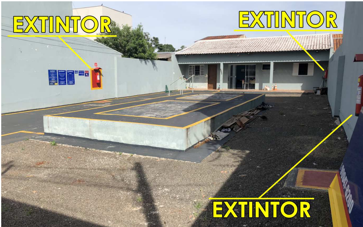
Figura 04 — Posicionamento dos extintores
