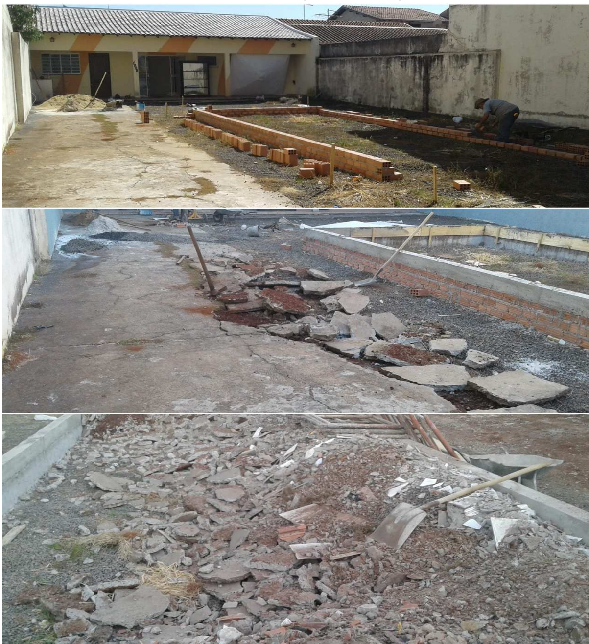
Figura 04 — Etapa da construção e adequação de normas
