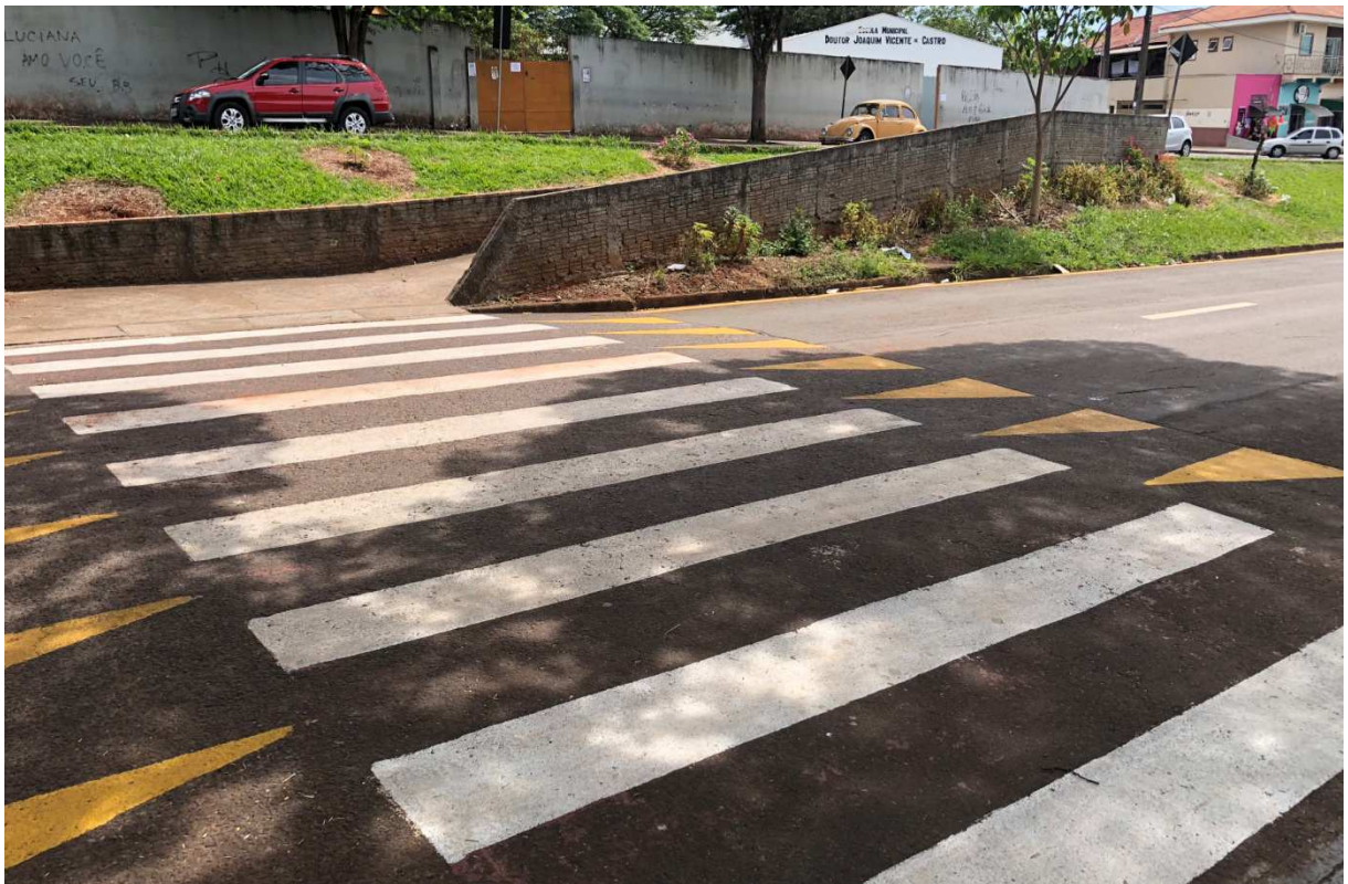
Figura 04 — Travessia elevada para acesso ao posto de saúde da AID após cruzamento do canteiro viário por uma rampa de piso cimentado com guarda corpo.
