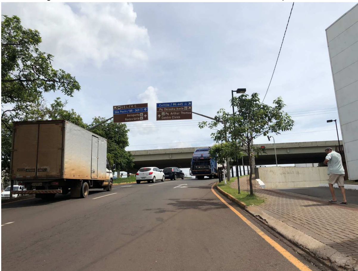
Figura 04 — Semáforos no início da Av. Pres. Eurico Gaspar Dutra
