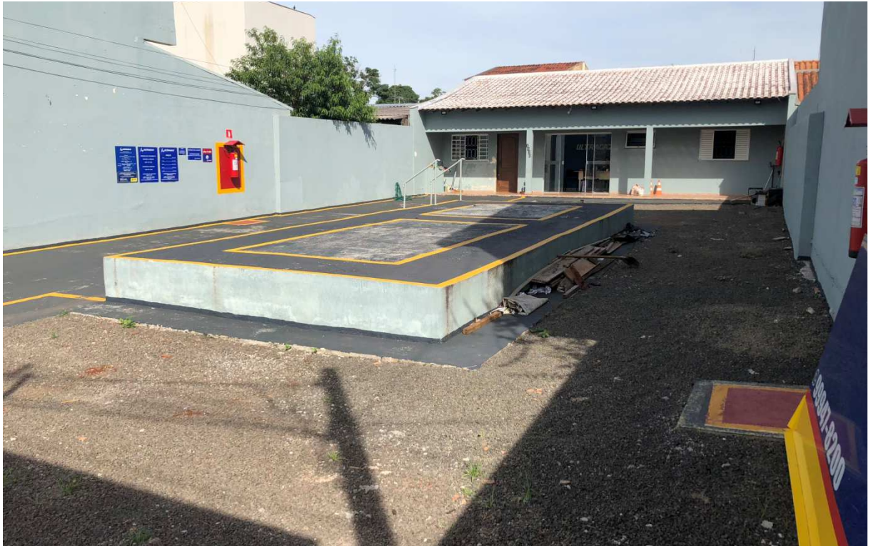
Figura 04 — Vista da plataforma elevada para armazenamento dos botijões
