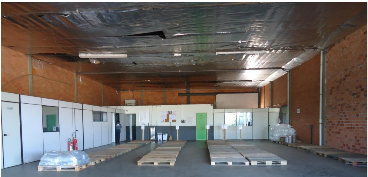
Figura 30: Manta térmica subcobertura. Fonte: Master Ambiental, 2017.
