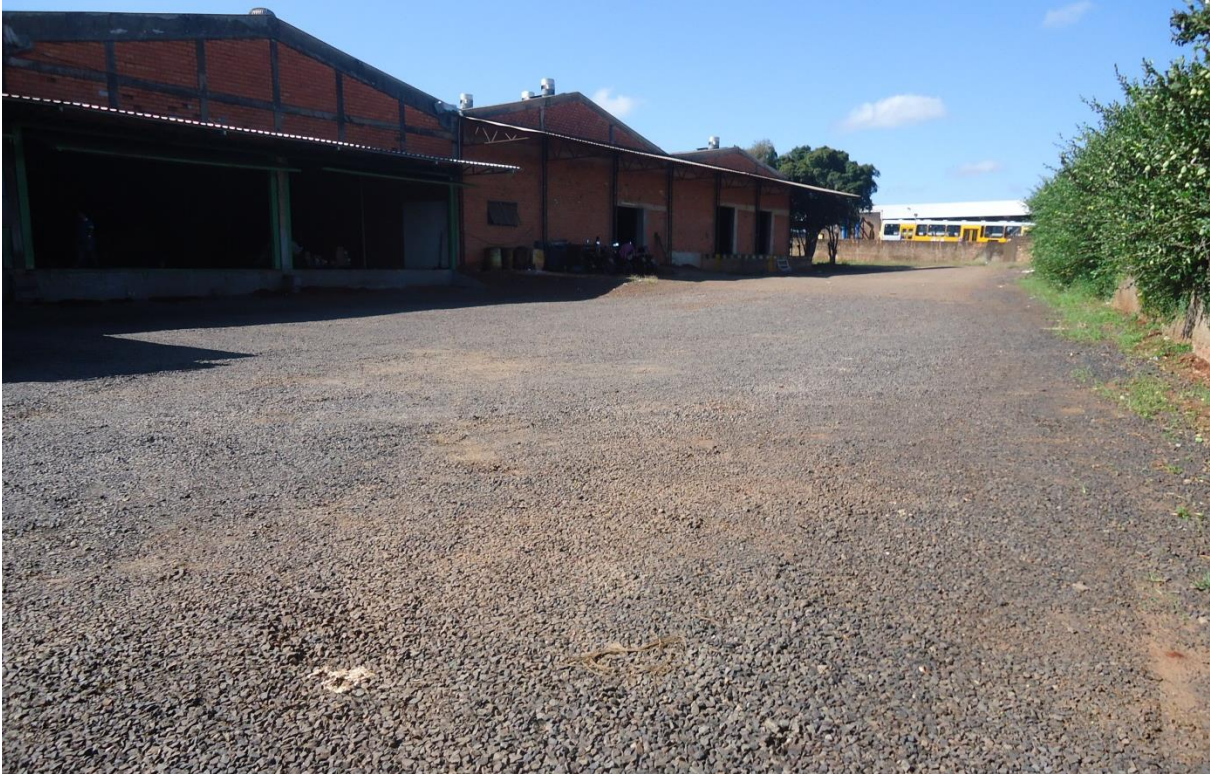
Figura 10: Cobrimento de área permeável em brita. Fonte: Master Ambiental, 2017.
