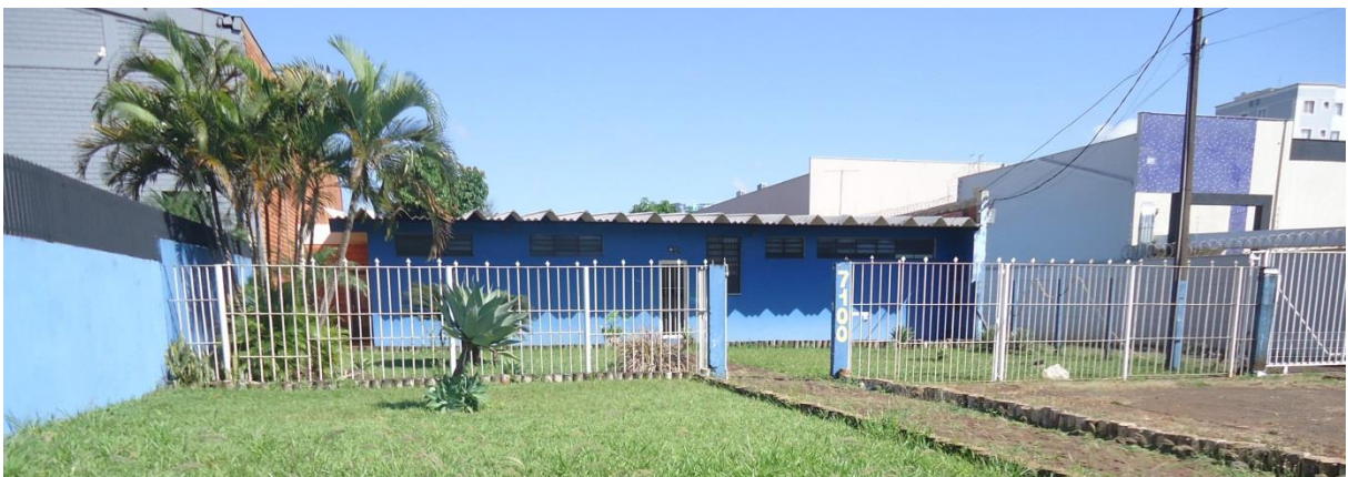
Figura 27: Edificação vizinha - uso de serviço. Fonte: Master Ambiental, 2017.
