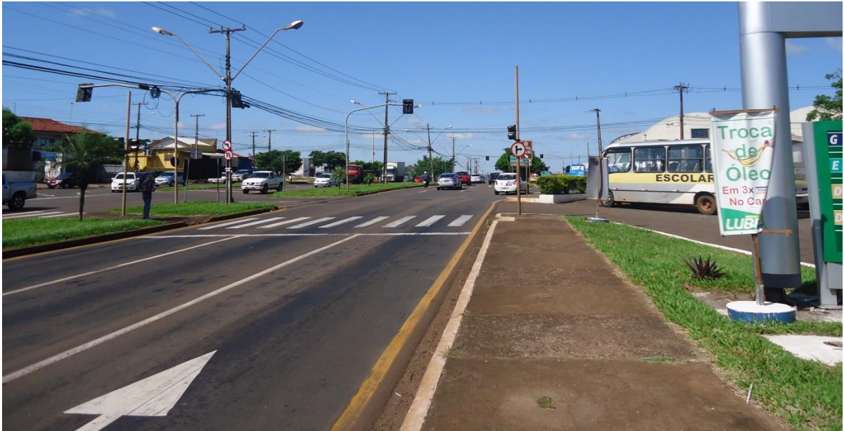
Figura 36: Sinalização viária fotografada na calçada do empreendimento frente ao posto de combustíveis. Fonte: Master Ambiental, 2017.
