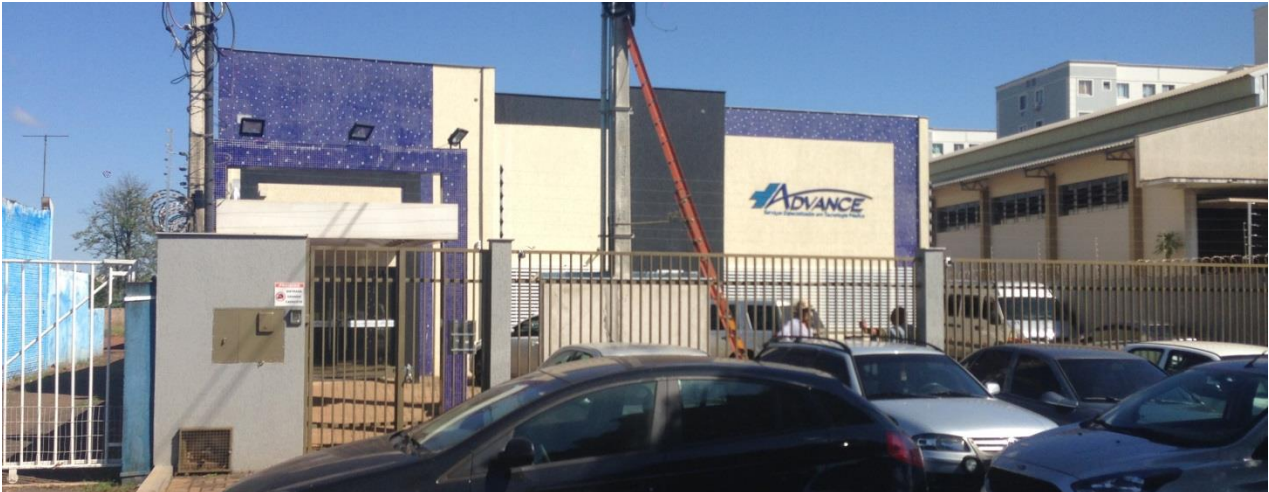
Figura 28: Edificação vizinha: uso de serviço. Fonte: Master Ambiental, 2017.
