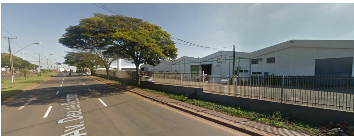
Figura 76: Empreendimento e vizinhos. Fonte: Google Street View, 2016.
