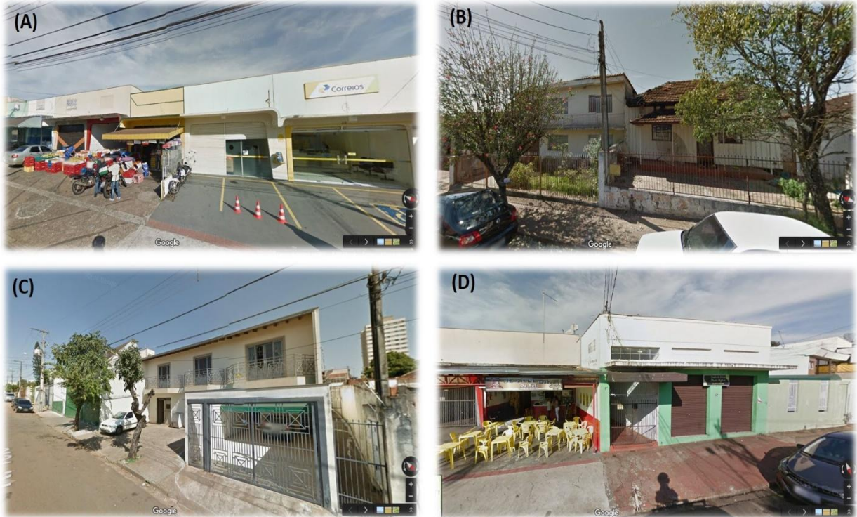
Figura 10: A) Comércio de um pavimento na Rua Guaporé; B) Residência de um e dois pavimentos na Rua Tefé; C) Residência de dois pavimentos na Rua Tefé; D) Comércio na rua Araguaia.
