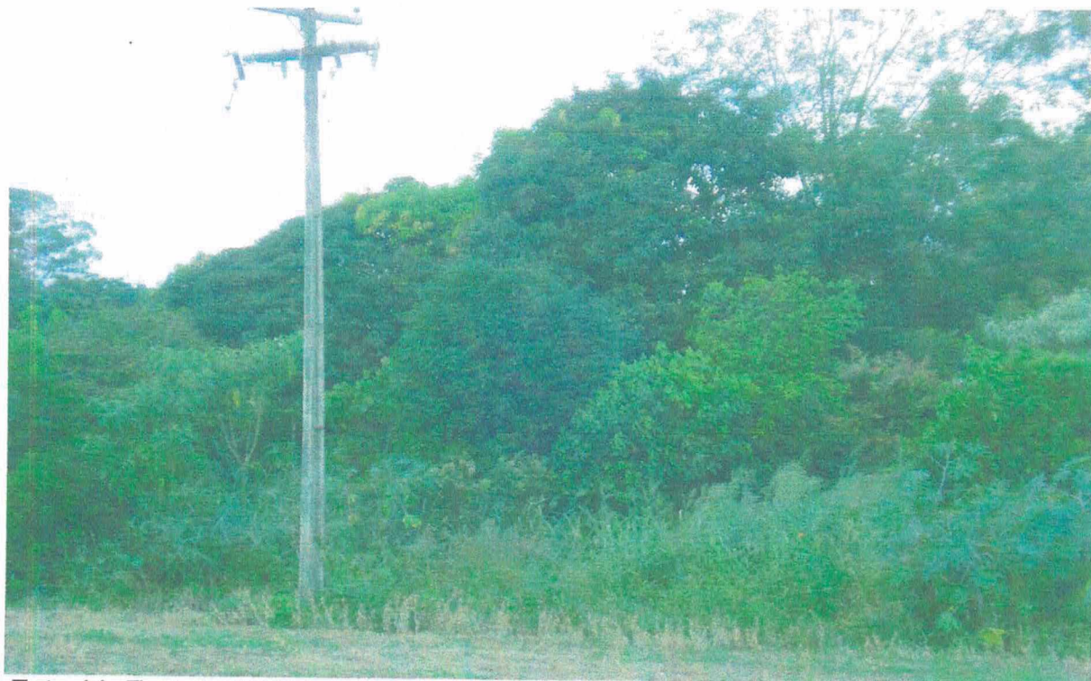
Foto 11: Energia elétrica existente nos lotes.
