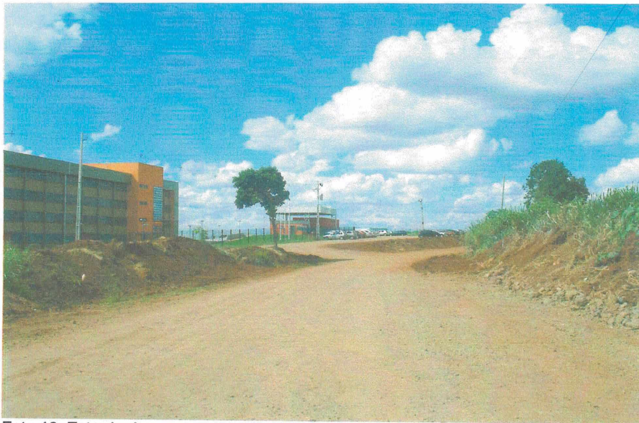
Foto 10: Estrada de acesso aos Lotes.
