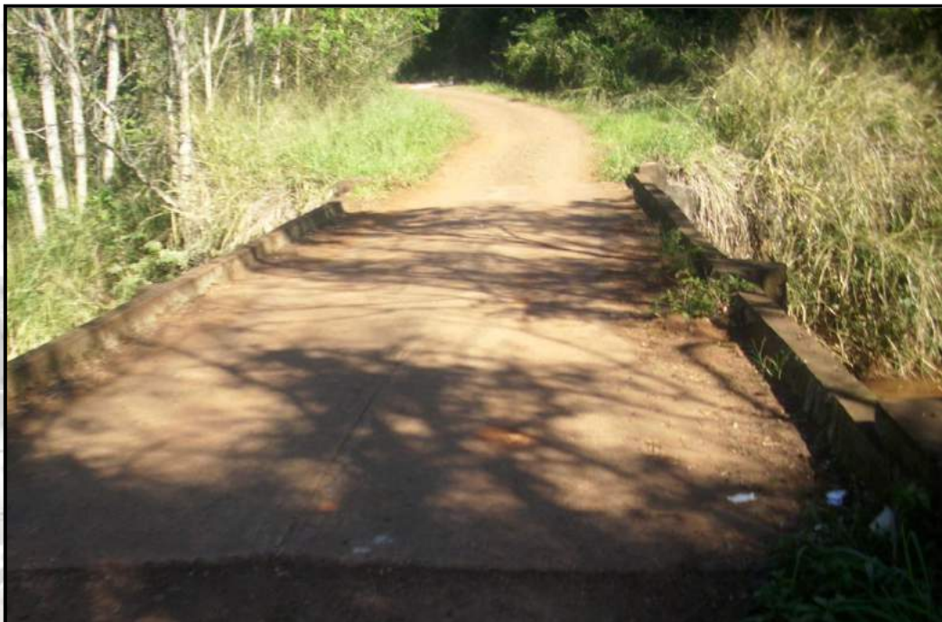
Figura 18: Ponte existente sobre o ribeirão Três Bocas.
