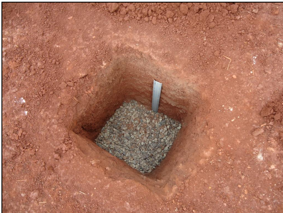
Foto 1 – Preparação da cava para elaboração do teste de percolação
