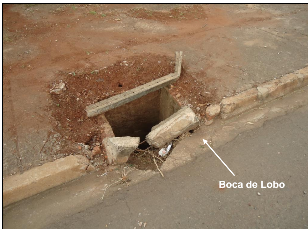
Foto 8 – Boca de lobo que interliga na rede de drenagem urbana
