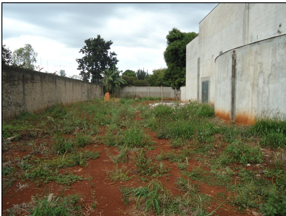
Foto 4 – Vista parcial da área onde deverá ser o estacionamento de veículos e que continuará permeável
