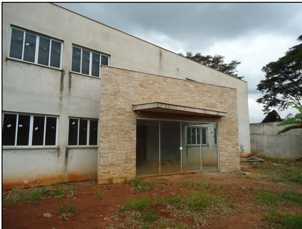
Foto 3 – Entrada principal em fase de acabamento
