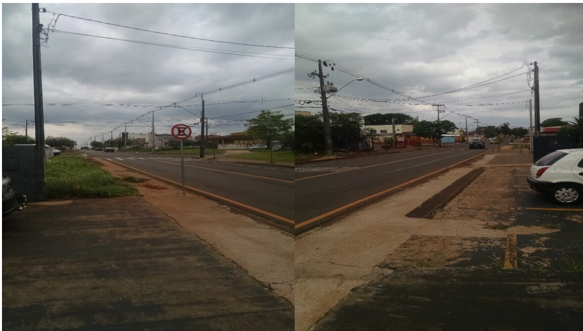
Figura 5 – Vista dos dois sentidos da Avenida São João 4092.
