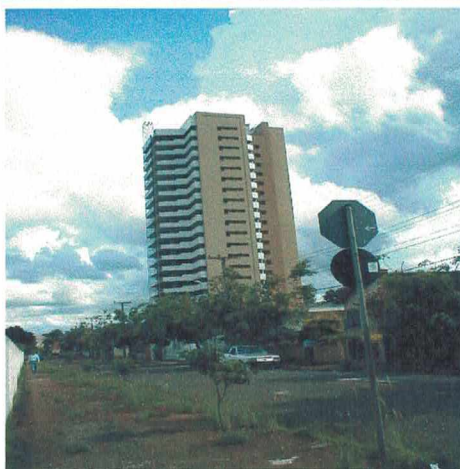
foto 02 . Edifício 20 pavimentos Rua João Kawassak
