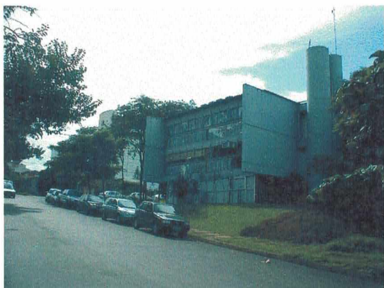
foto 01 . Vista geral AONP, a partir rua João XXIII
