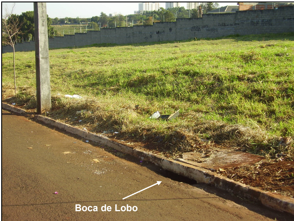
Foto 2 – Rua Alcides Zaninelli, lateral aos lotes em estudo. Com detalhe para a boca de lobo da galeria de drenagem pluvial urbana.
