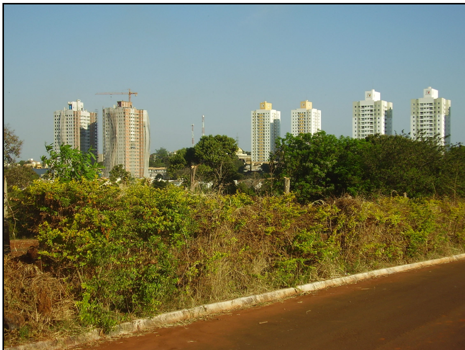
Foto 5 – Vista de uma das laterais da área em estudo e edificações ao fundo, inclusive com edifícios em fase de execução.
