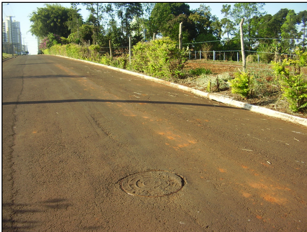
Foto 3 – Rua Alcides Zaninelli, lateral aos lotes em estudo. Com detalhe para a tampa da galeria de drenagem pluvial urbana.
