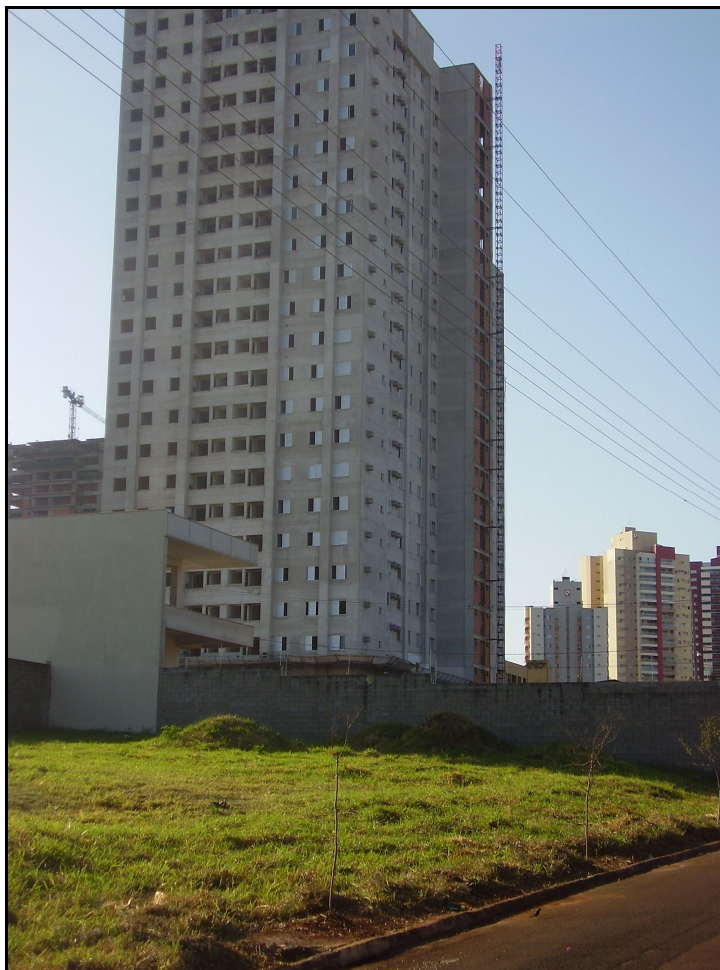
Foto 6 – Edifício em fase de construção, divisa na Rua Alcides Zaninelli, adjacente à área dos lotes em estudo.
