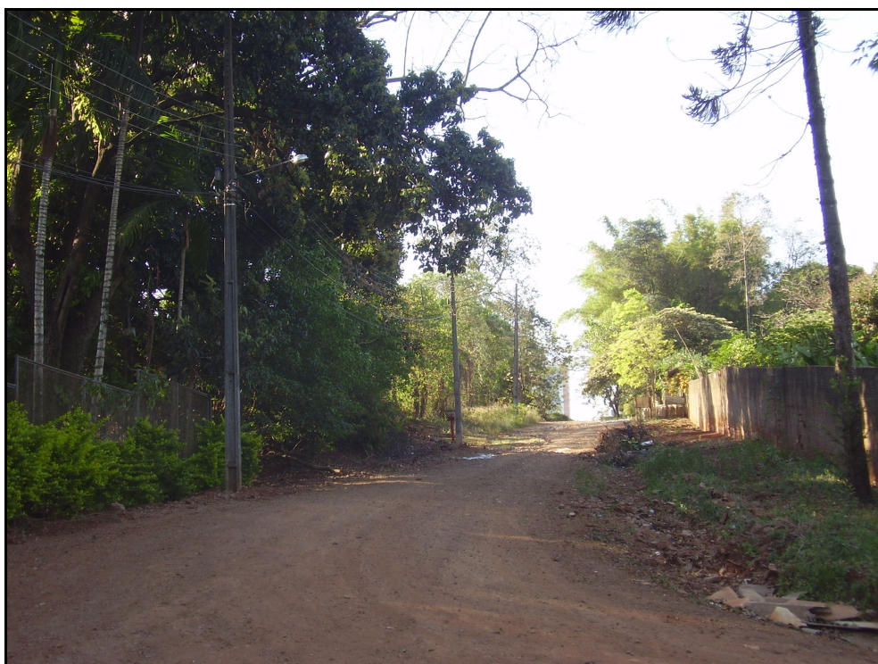
Foto 4 – Fim da Rua Mar Vermelho, junto aos lotes nº 14 e 19. Sem pavimentação, com postes de fornecimento de energia elétrica.
