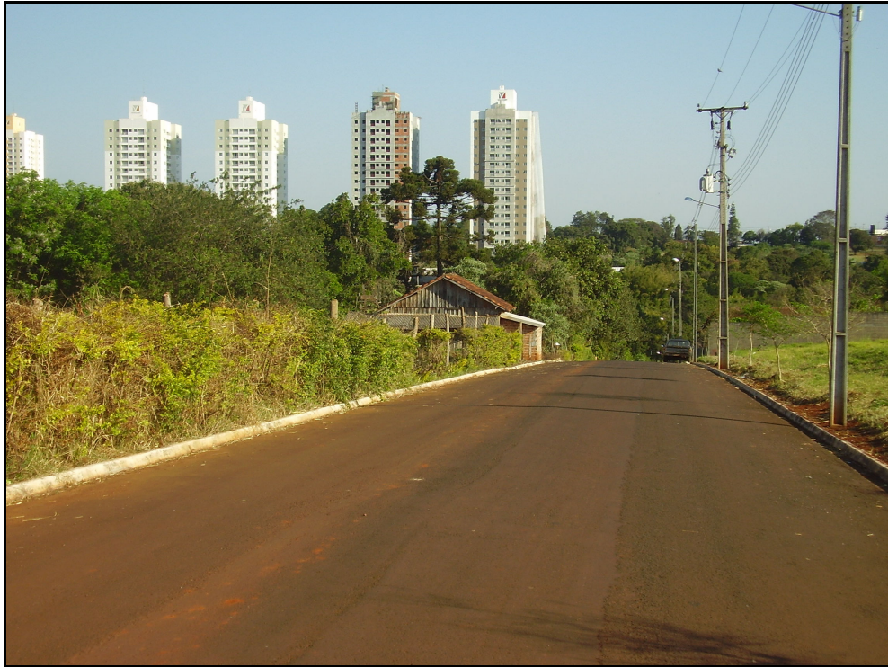
Foto 1 – Rua Alcides Zaninelli, lateral aos lotes em estudo. Com pavimentação em asfalto e postes de rede elétrica.
