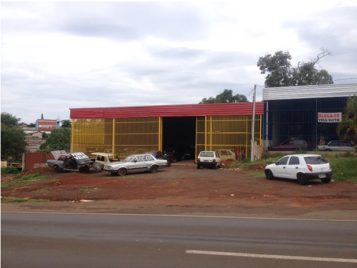
Figura 6 – Área permeável (área de estacionamento). 24/10/2016. Fonte: Vítor Ricci
