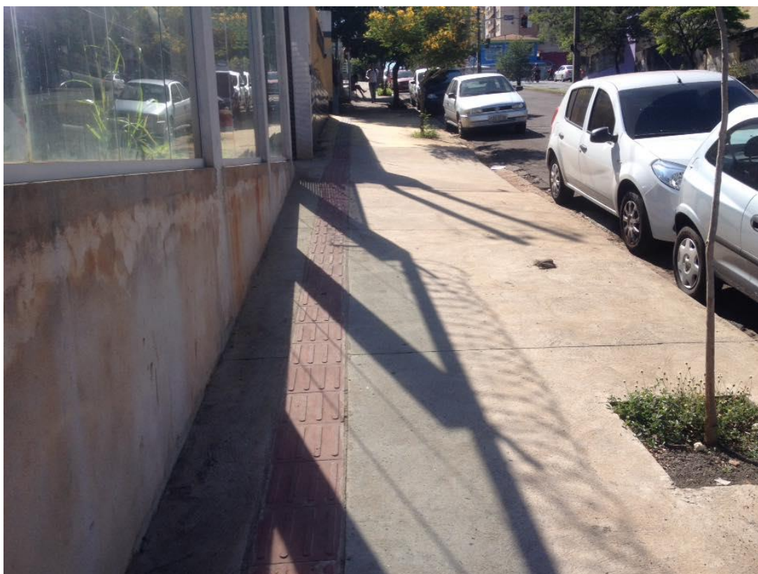
Figura 5 – Visão da calçada frente ao empreendimento. 29/09/2016. Fonte: Vítor Ricci
