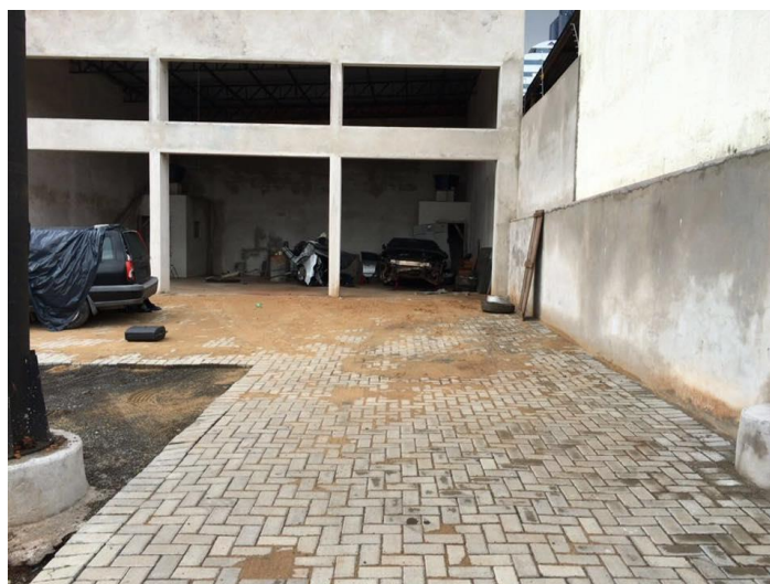
Figura 2 – Parte interna do empreendimento e estacionamento. 29/09/2016. Fonte: Vítor Ricci
