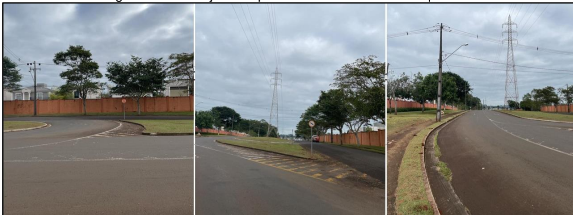
Figura 15 - Condições do pavimento no entorno do empreendimento.
