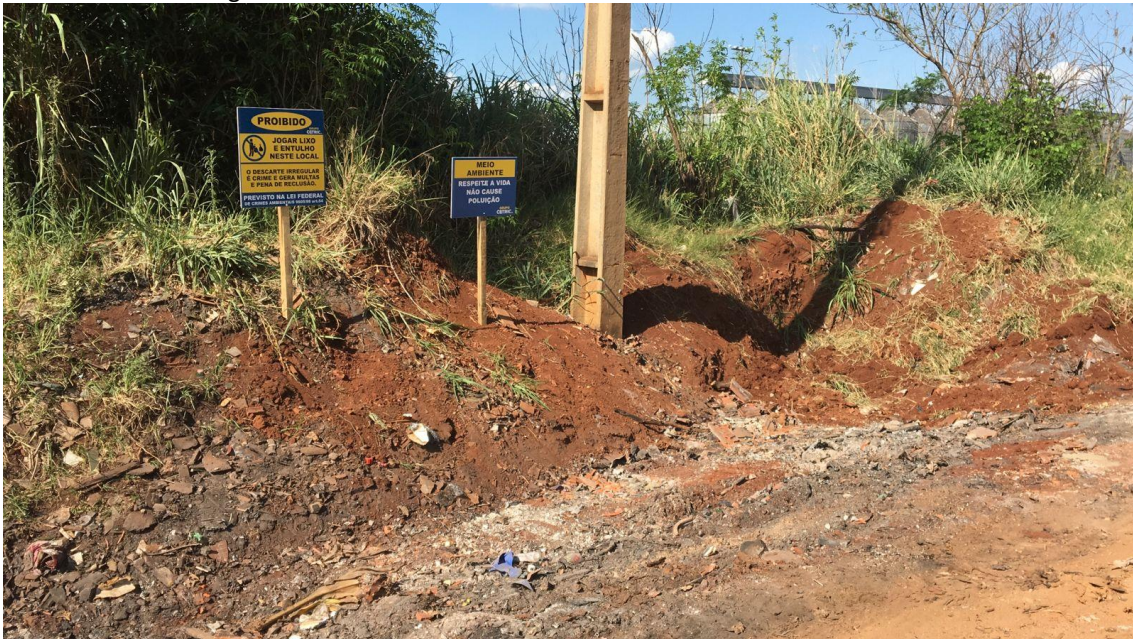
Imagem 50 – Via de acesso a Rua Capitão Jacy da Silva Pinheiros após a inclusão das placas educativas sobre o descarte irregular
