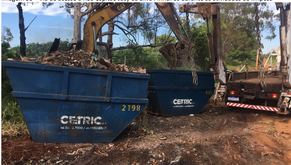
Imagem 36 – Via de acesso a Rua Capitão Jacy da Silva Pinheiros durante as atividades de limpeza
