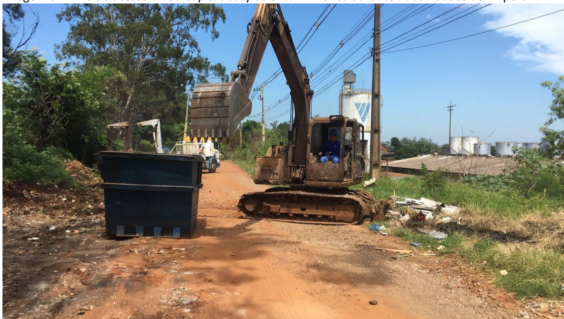
Imagem 34 – Via de acesso a Rua Capitão Jacy da Silva Pinheiros durante as atividades de limpeza
