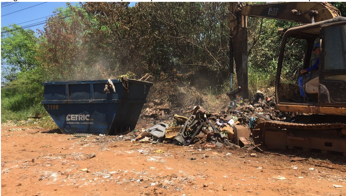
Imagem 37 – Via de acesso a Rua Capitão Jacy da Silva Pinheiros durante as atividades de limpeza
