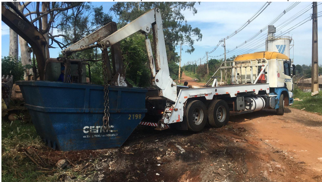
Imagem 33 – Via de acesso a Rua Capitão Jacy da Silva Pinheiros durante as atividades de limpeza
