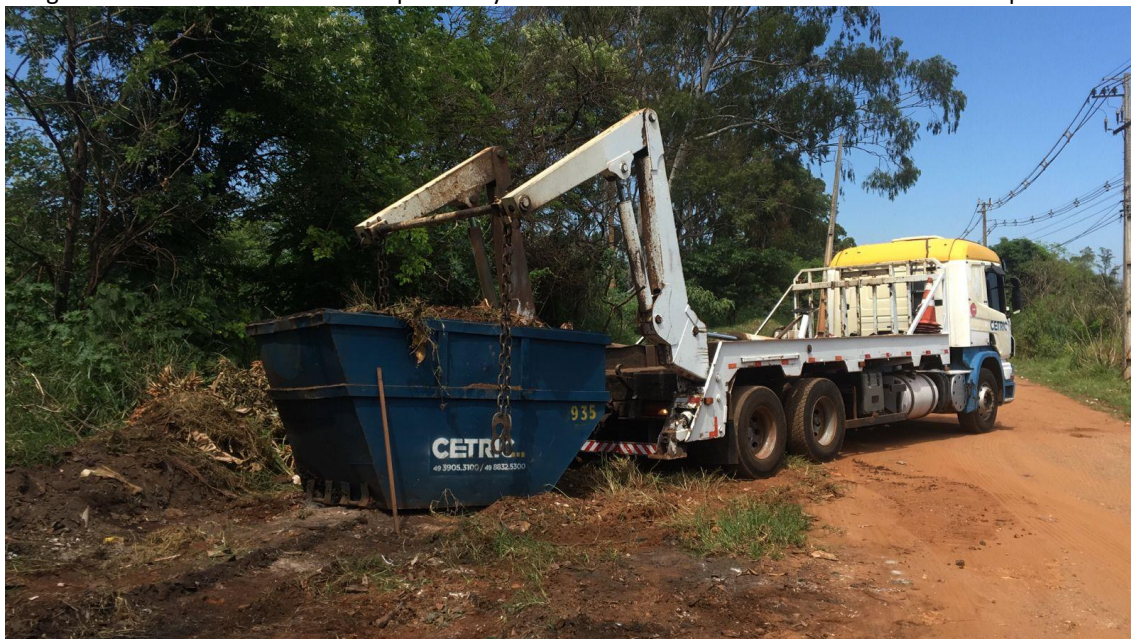
Imagem 35 – Via de acesso a Rua Capitão Jacy da Silva Pinheiros durante as atividades de limpeza
