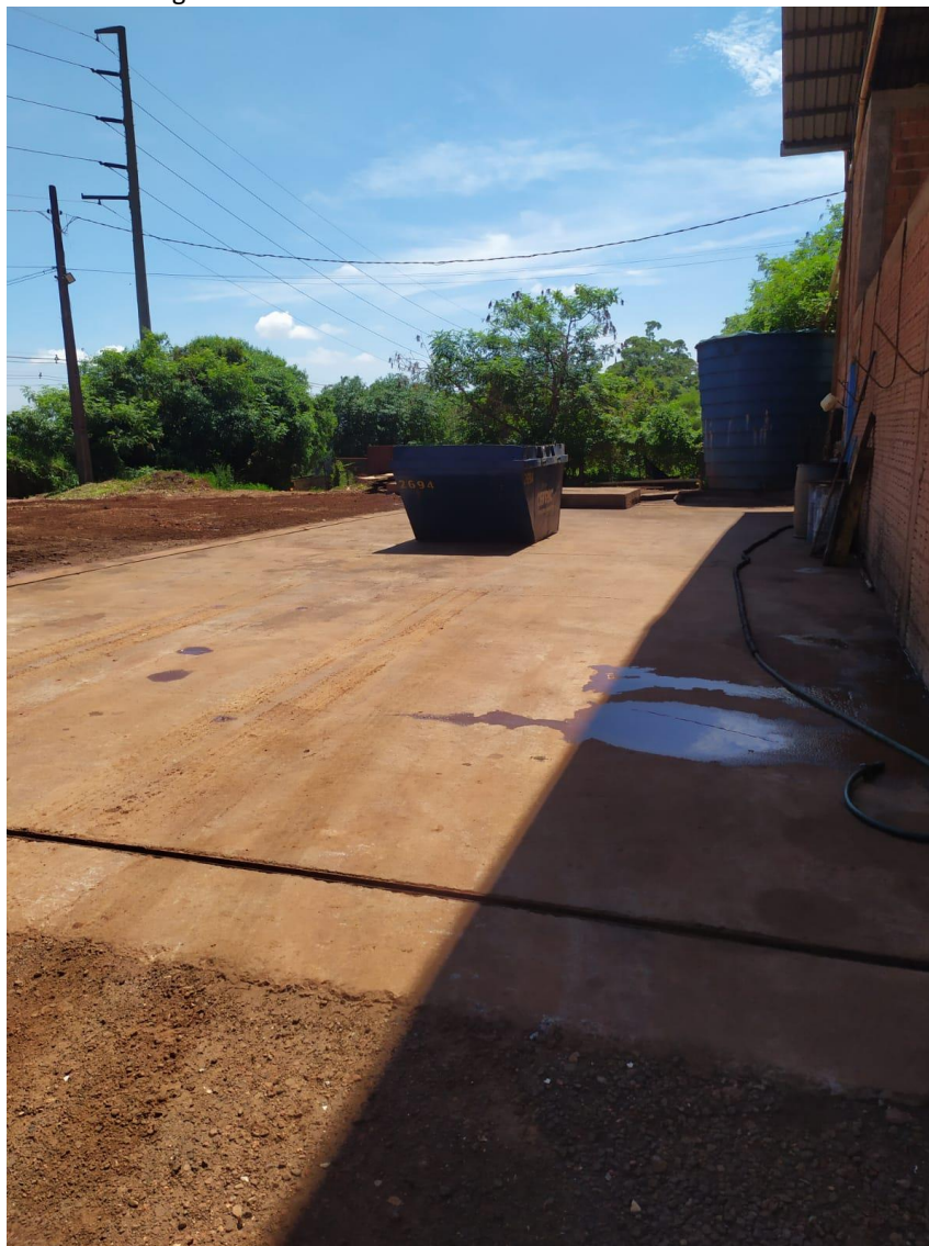
Imagem 22 – Visão das canaletas coletoras do barracão 02
