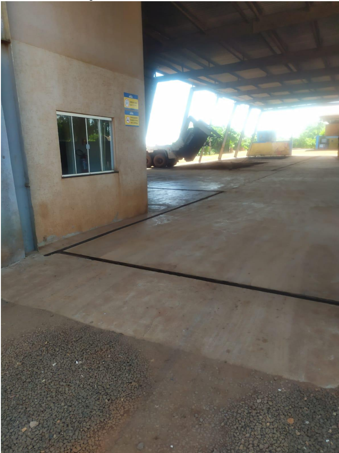
Imagem 03 – Canaletas coletoras ao redor do barracão 01
