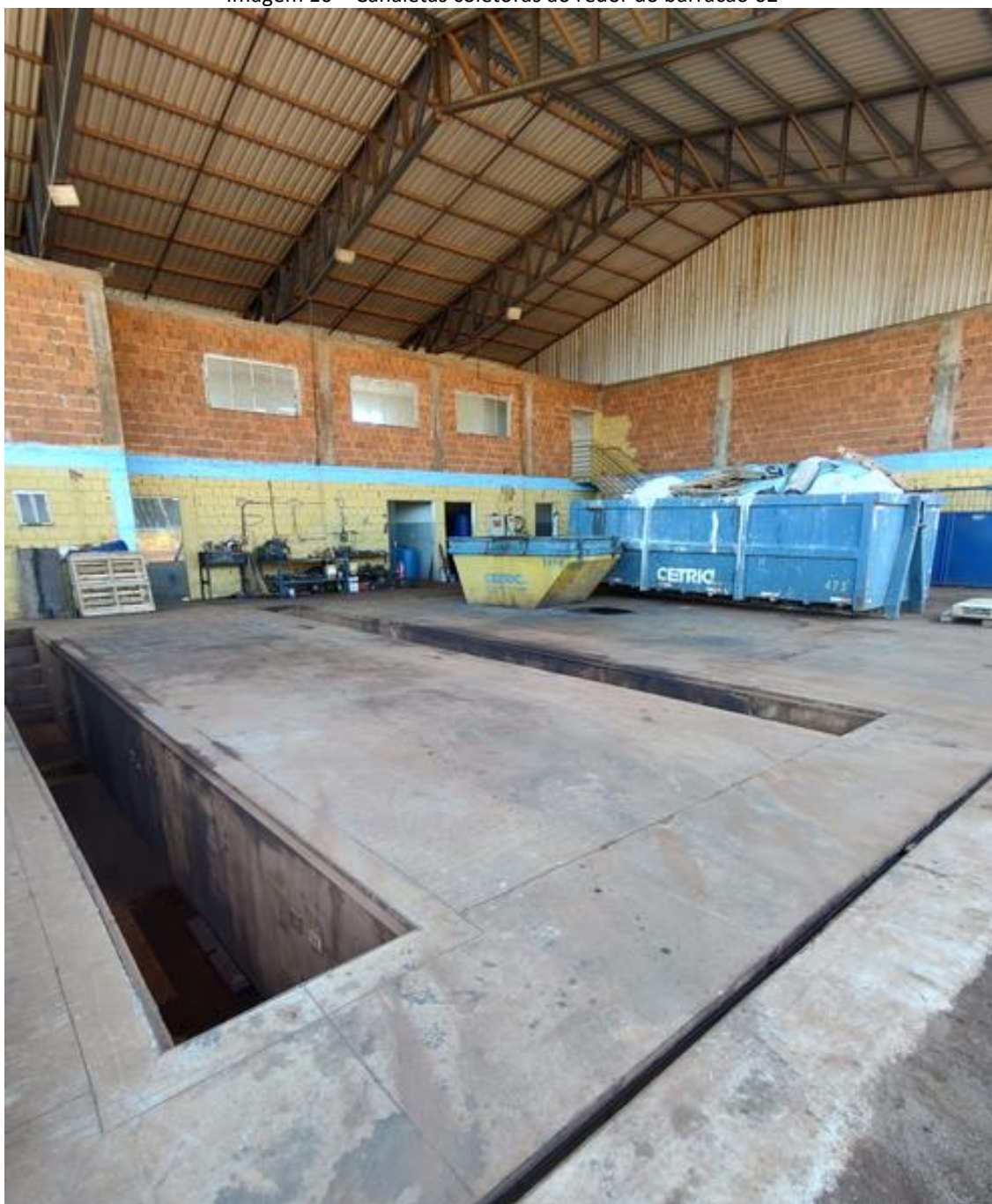
Imagem 10 – Canaletas coletoras ao redor do barracão 02
