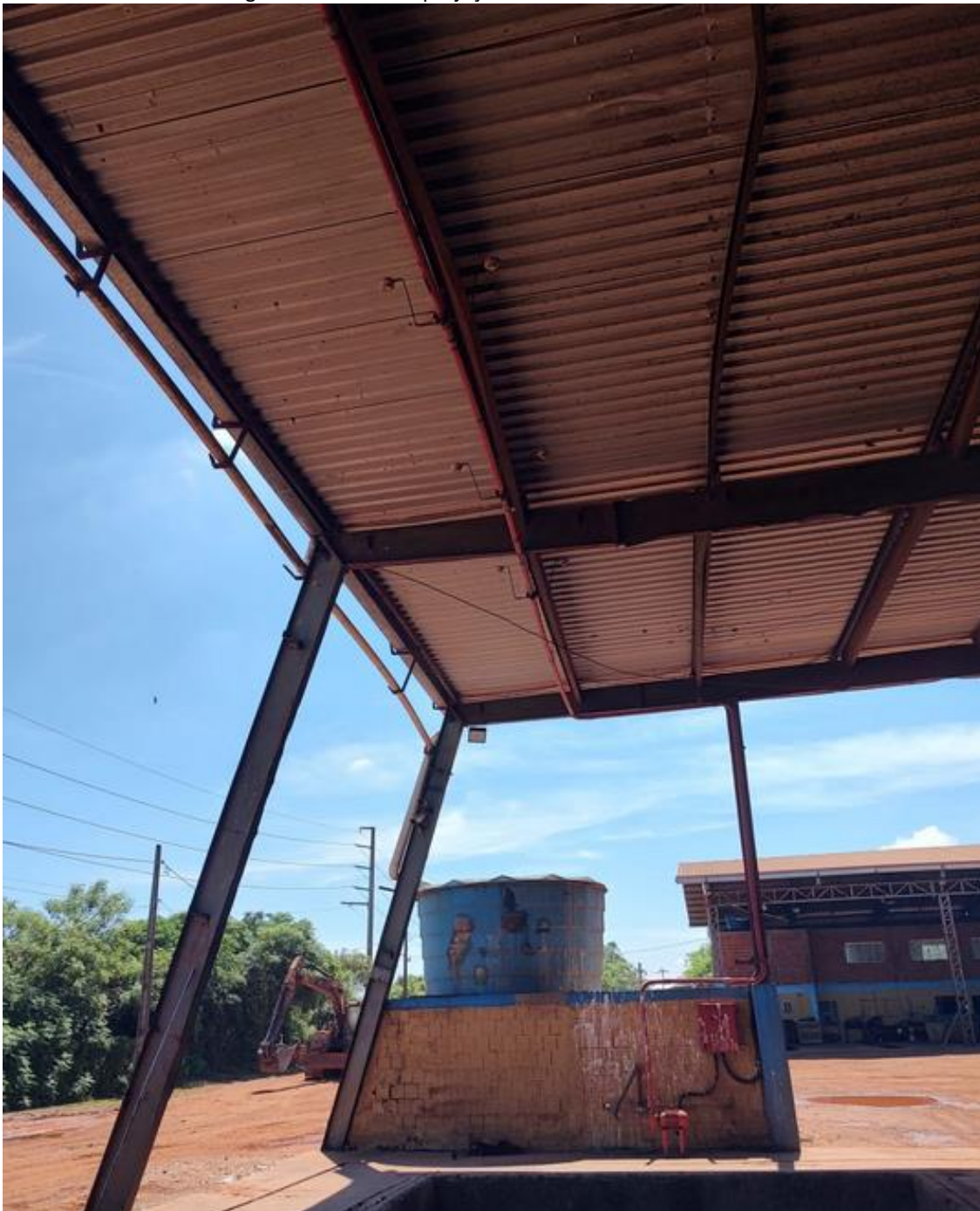
Imagem 52 – Visão da projeção da cobertura do barracão 01
