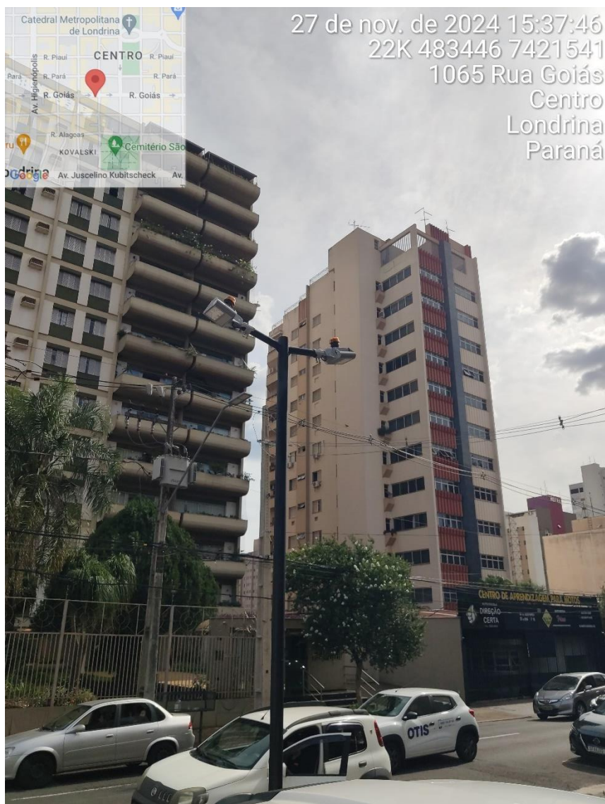
Figura 42 – Ponto de iluminação instalado no estacionamento na divisa do lote com o passeio público
