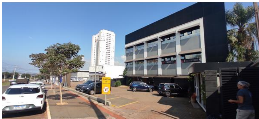
Figura 38: Empreendimento Santa Ana Padaria em conjunto com a Panvel Farmácias, localizado na Rodovia Mábio Palhano. Fonte: Master Ambiental, 2024.
