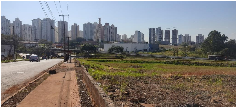
Figura 45: Acesso ao empreendimento pela Rodovia Mábio Gonçalves Palhano. Fonte: Master Ambiental, 2024.
