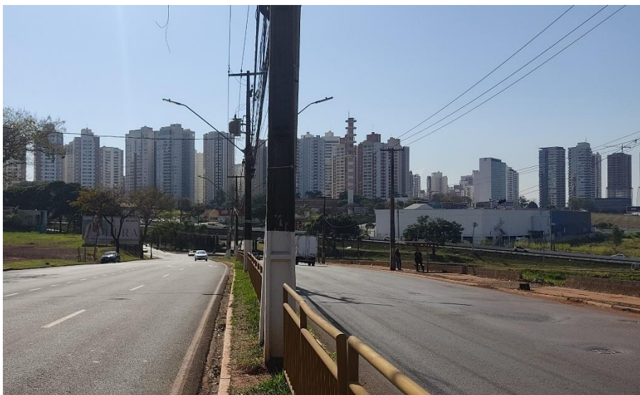
Figura 51: Iluminação Pública na Rodovia Mábio Palhano. Fonte: Master Ambiental, 2024.
