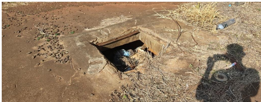
Figura 4: Presença de Poços no interior do lote. Fonte: Master Ambiental, 2024.
