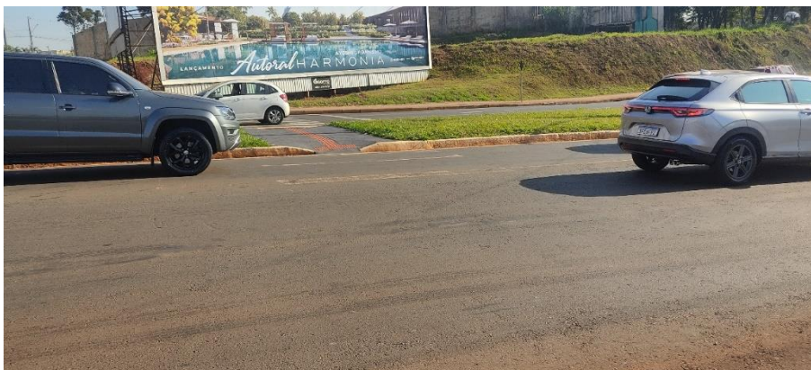
Figura 122: Ausência de sinalização para pedestres no acesso ao oitão, em frente ao empreendimento. Fonte: Master Ambiental, 2024.
