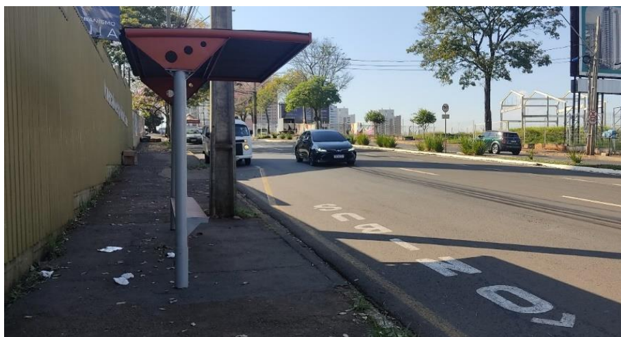
Figura 111: Calçamento na Av. Madre Leônia Milito. Fonte: Master Ambiental, 2024.
