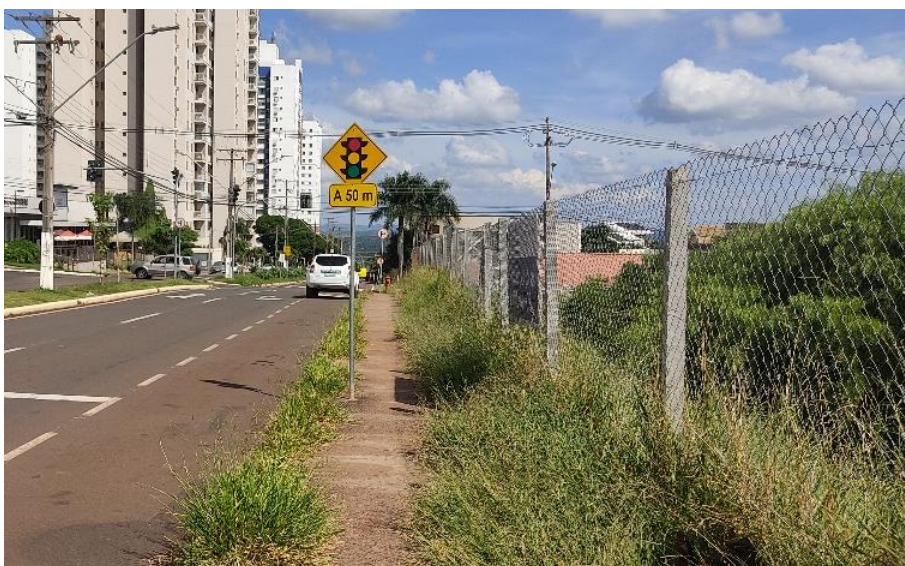
Figura 114: Calçamento na Rua Luís Lercó. Fonte: Master Ambiental, 2024.
