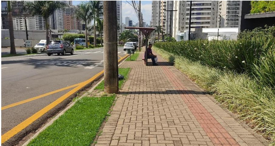
Figura 112: Calçamento na Av. Ayrton Senna da Silva. Fonte: Master Ambiental, 2024.
