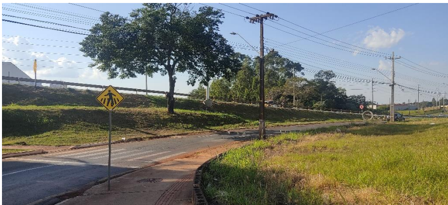
Figura 46: Acesso ao empreendimento pela Rodovia Celso Garcia Cid (Marginal). Fonte: Master Ambiental, 2024.
