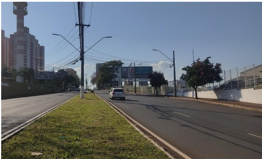
Figura 53: Iluminação Pública na Av. Me. Leônia Milito. Fonte: Master Ambiental, 2024.
