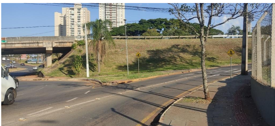
Figura 124: Falta de visibilidade dos pedestres que cruzam a via. Fonte: Master Ambiental, 2024.
