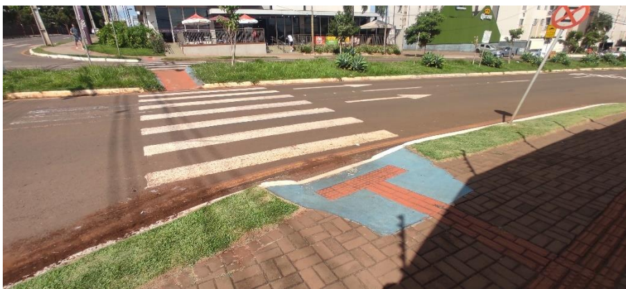
Figura 119: Guia Rebaixada na Rua Luís Lerco. Fonte: Master Ambiental, 2024.
