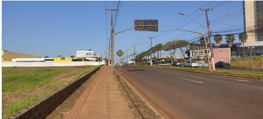
Figura 120: Calçamento lindeiro ao empreendimento: Fonte: Master Ambiental, 2024.
