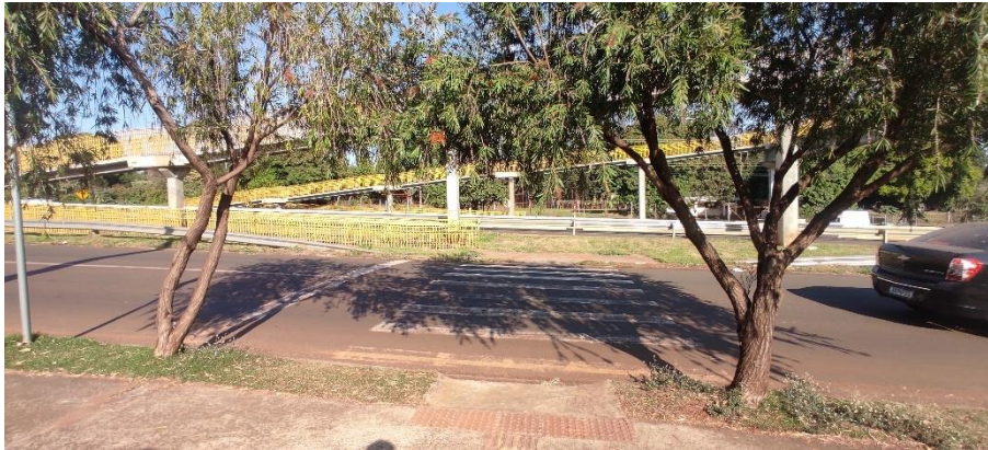
Figura 118: Acesso a passarela na Rod. Celso Garcia Cid. Fonte: Master Ambiental, 2024.
