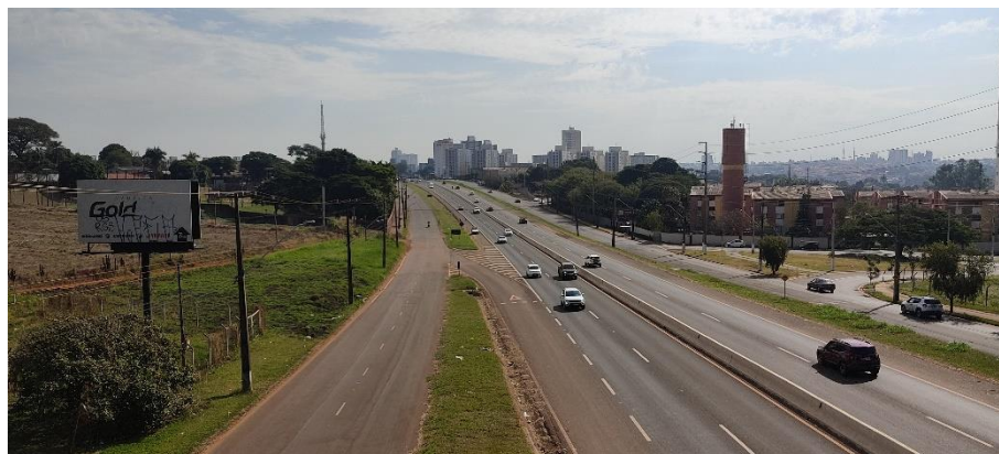
Figura 62: Rodovia Celso Garcia Cid. Fonte: Master Ambiental, 2024.
