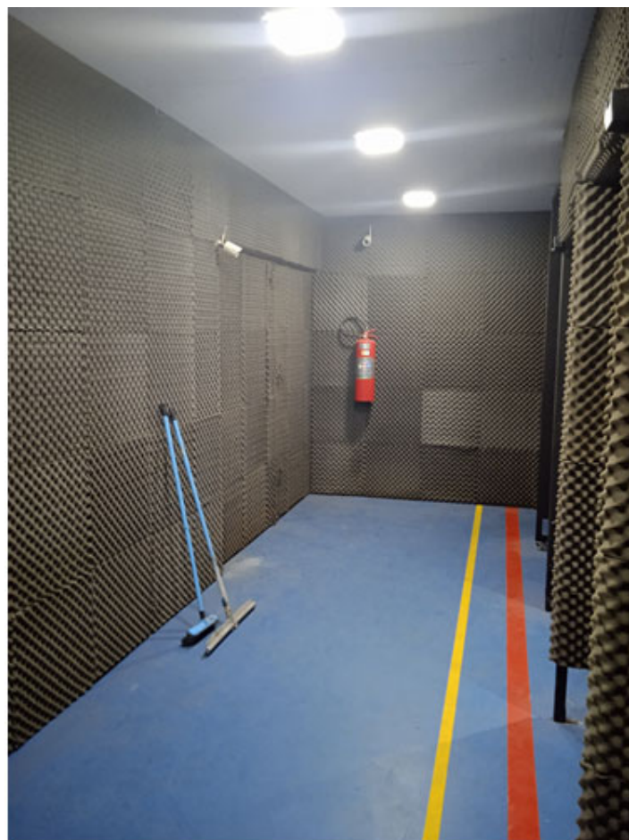
Figura 7: Estande de tiro com isolamento acústico (Fonte: E.A, 2021).
