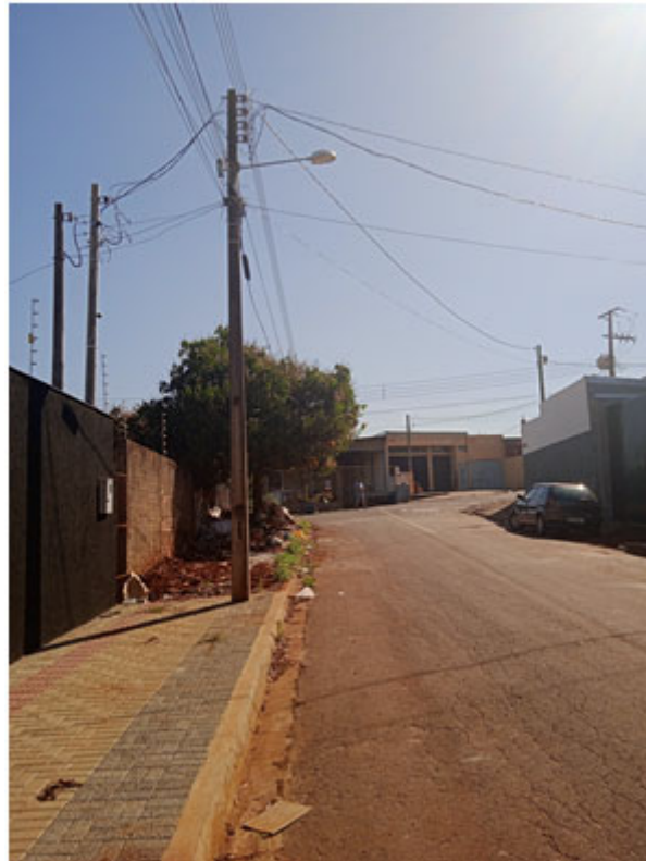
Figura 39: Acesso ao empreendimento pela Rua José Garrido (Fonte: E.A, 2021).
