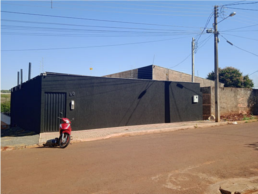
Figura 42: Passeio pertencente ao empreendimento (Fonte: E.A, 2021).
