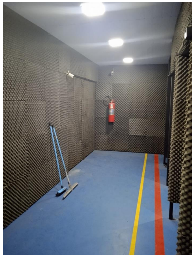
Figura 8: Estande de tiro com espumas de isolamento acústico.
