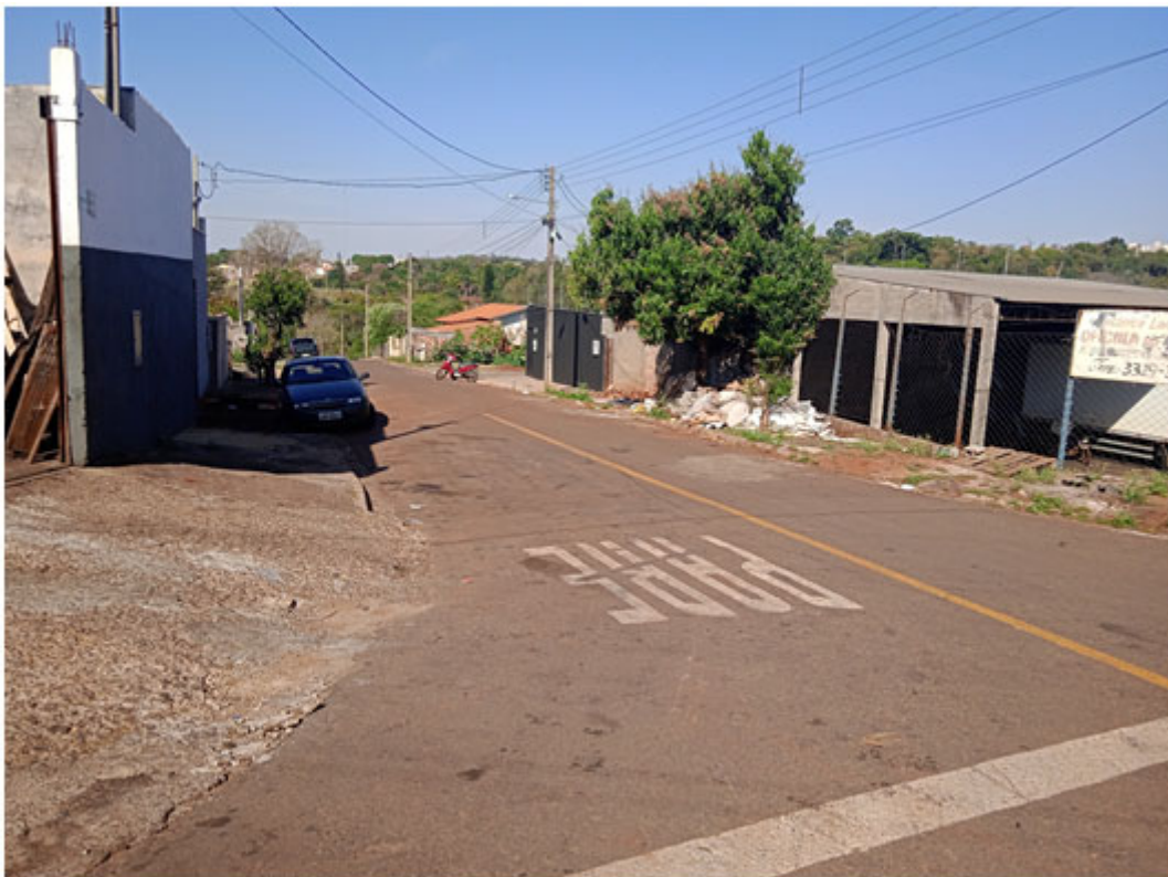
Figura 46: Pavimentação Rua José Garrido (Fonte: E.A, 2021).
