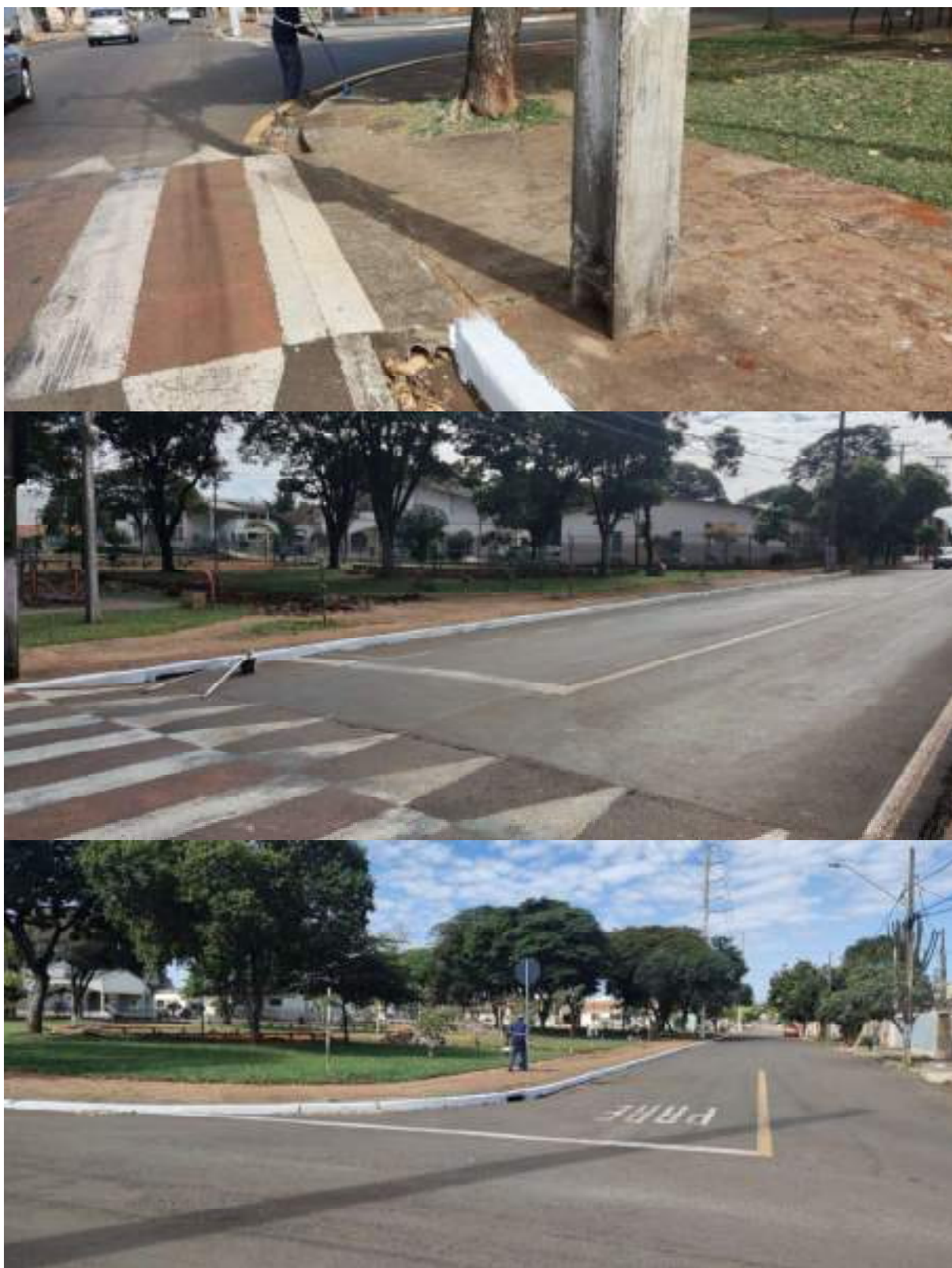
Figura 1: Registros da execução de repintura do meio-fio do calçamento da "Praça I" do Jardim Messiânico, como primeira medida de manutenção. Fonte: PUC, 2023.
