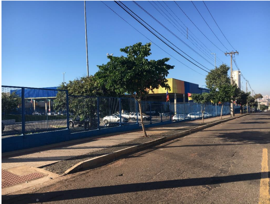
PISO TÁTIL NA CALÇADA DA RUA MANOEL ALVES DE OLIVEIRA
