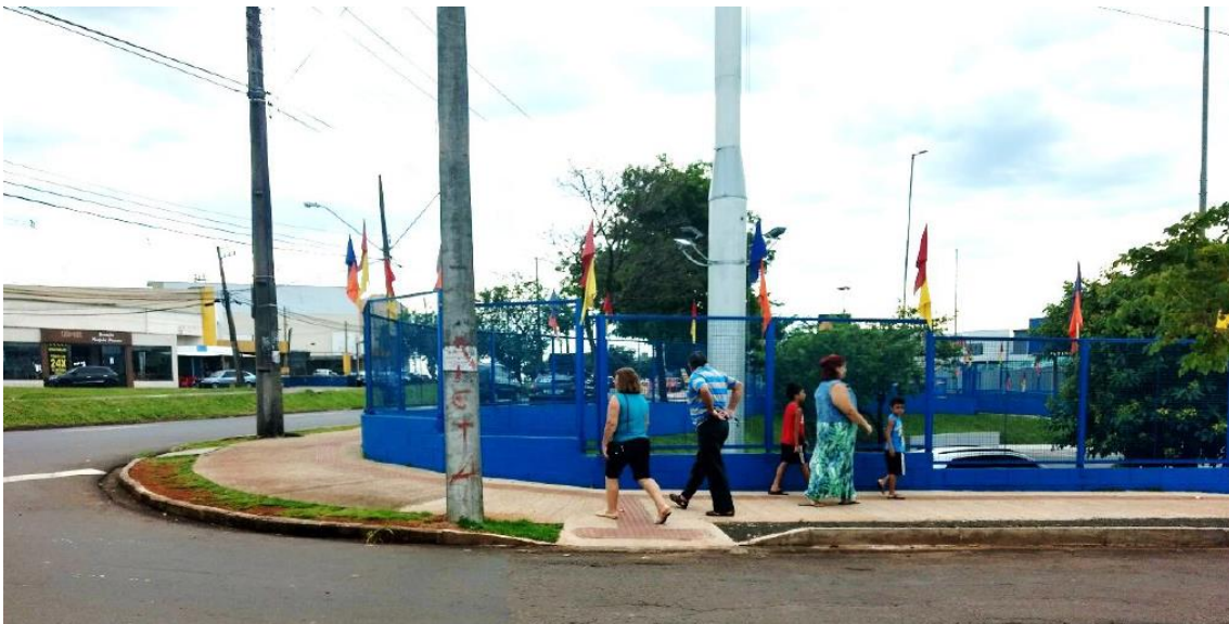
RAMPA NA ESQUINA DA RUA MANOEL ALVES DE OLIVEIRA
