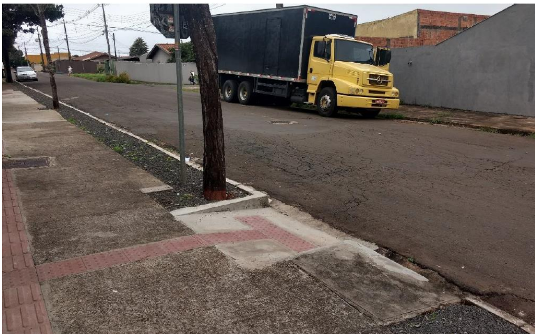
RAMPA NA ESQUINA DA RUA PAULO RENATO GIAROLA
