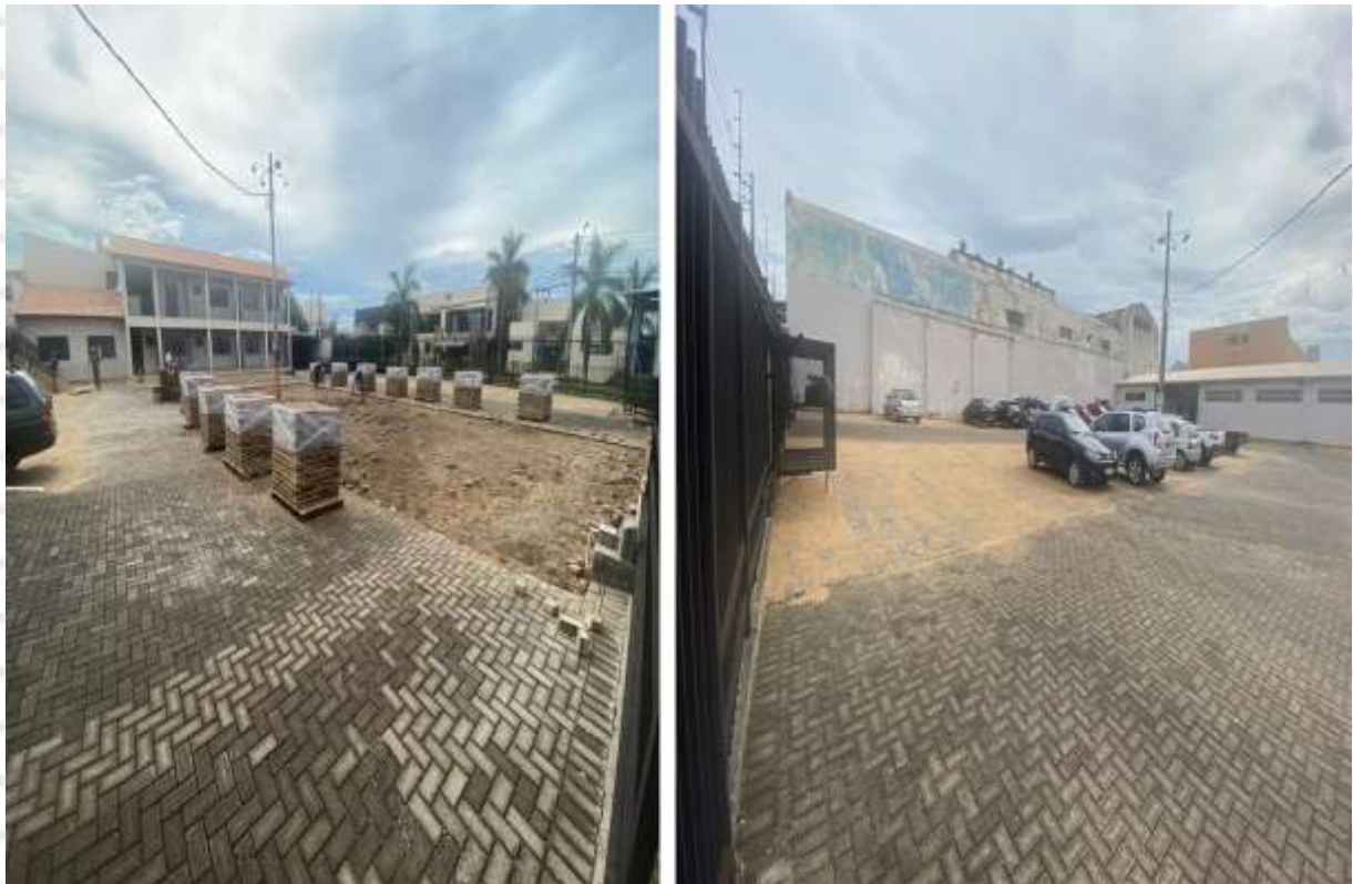
Figura 07: Imagens da troca do piso.
