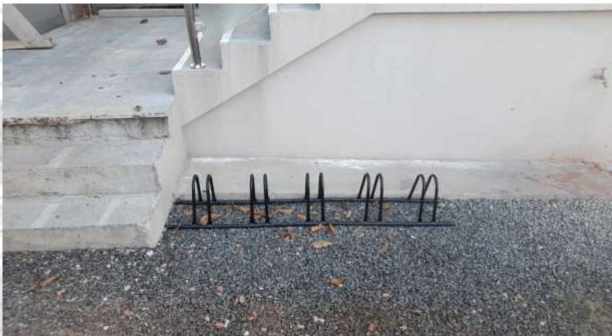
Figura 09: Instalação dos paraciclos.
