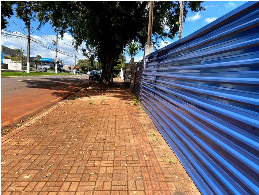
FIGURA 5 VISTA DO CALÇAMENTO EM FRENTE AO LOCAL DO EMPREENDIMENTO.
