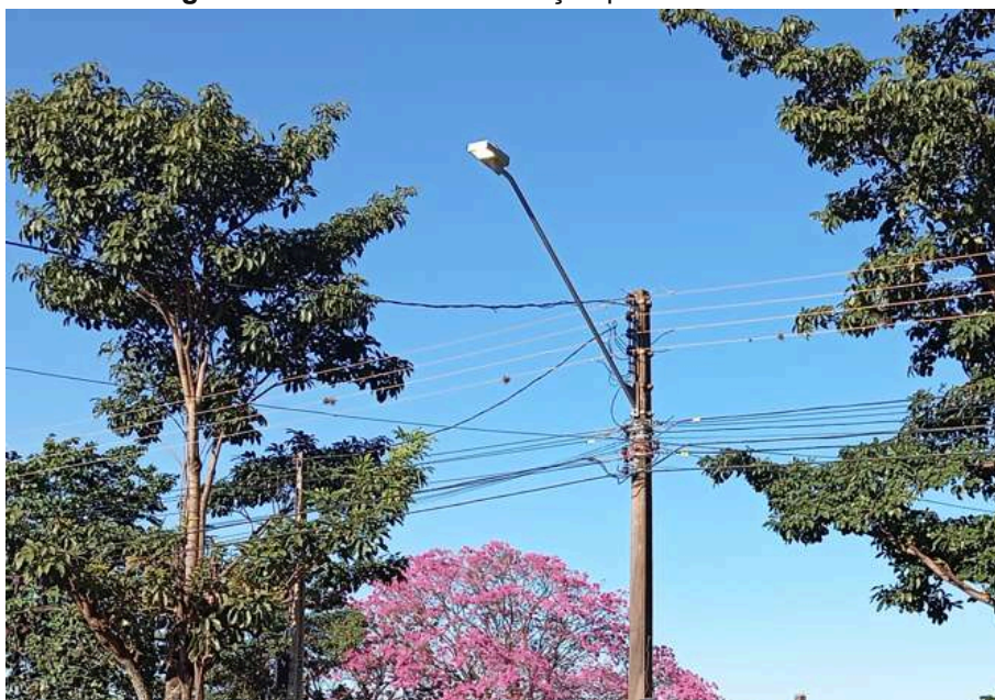
Figura 72- Sistema de iluminação pública no entorno.
