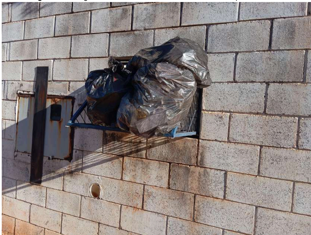
Figura 50- Abrigo de resíduos localizado na fachada do empreendimento.
