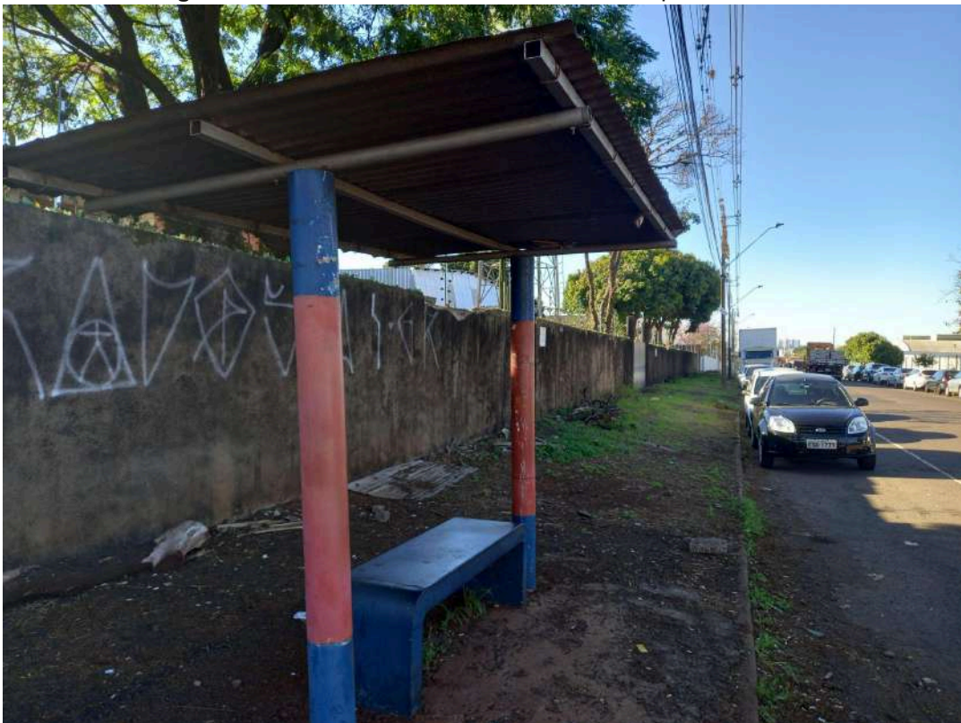
Figura 103- Ponto de Ônibus no entorno do empreendimento.
