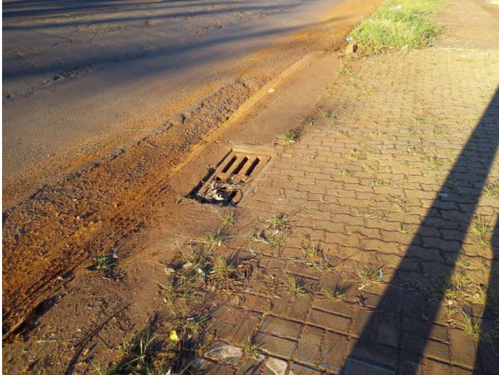
Figura 60- Boca de Lobo – Frente ao empreendimento.
