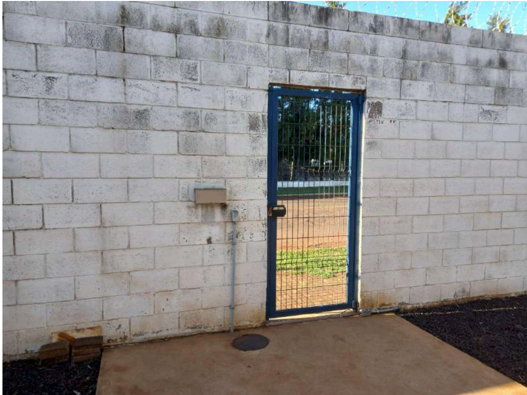
Figura 93- Portão de acesso de pessoas ao empreendimento.
