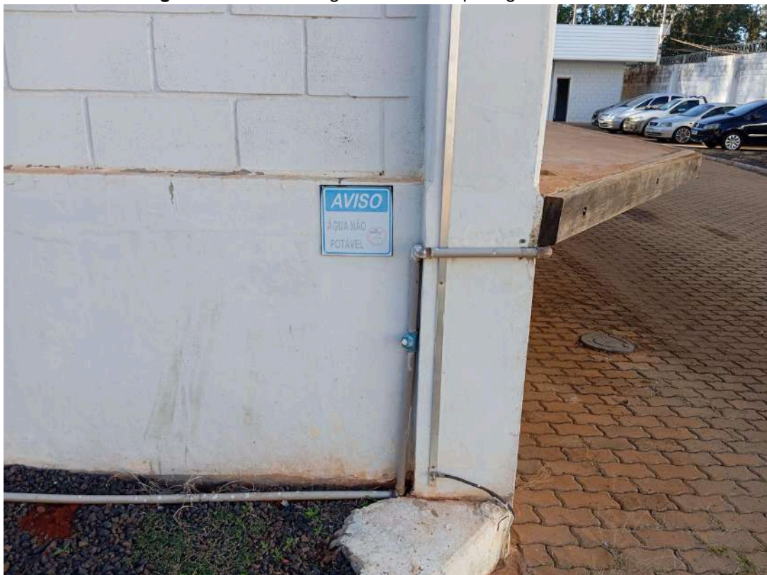
Figura 15- Ponto de água abastecido por águas de reuso.
