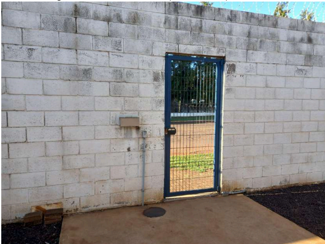
Figura 21- Portão de acesso de pessoas ao empreendimento.
