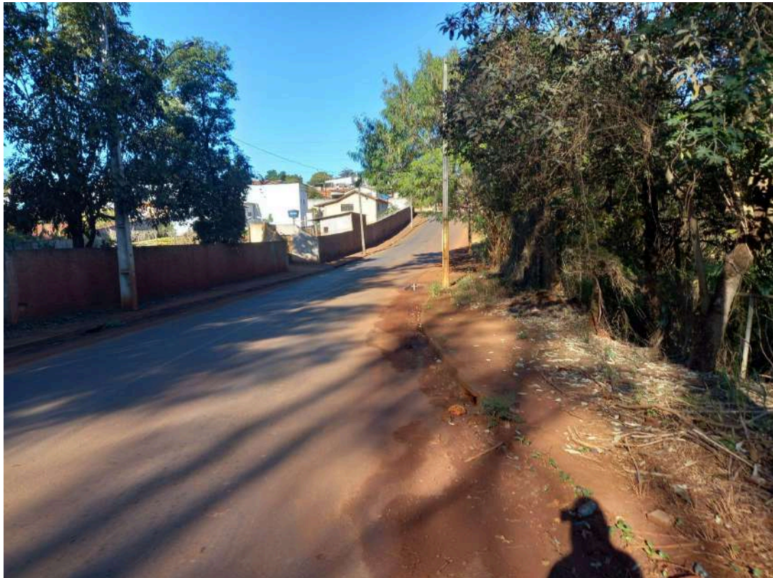
Figura 46- Travessia sobre o Ribeirão Cambé no entorno do empreendimento.
