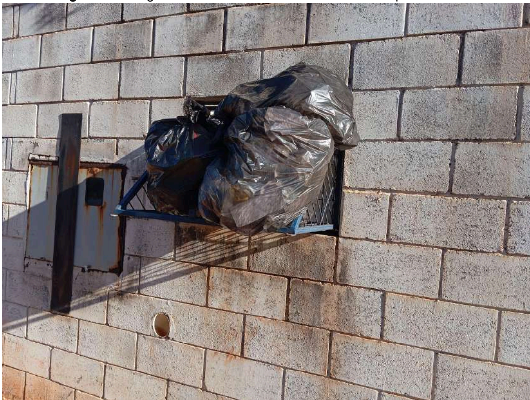
Figura 23- Abrigo de resíduos visto do lado de fora do empreendimento.
