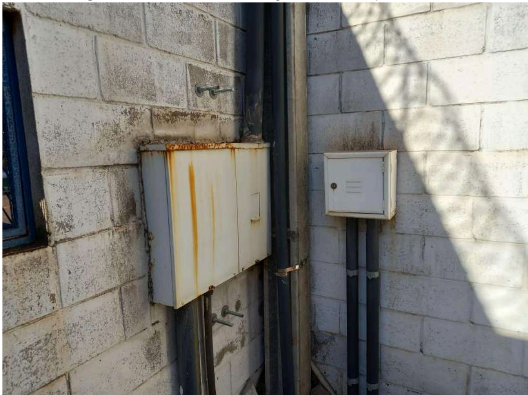
Figura 64- Abastecimento de energia frontal ao empreendimento.
