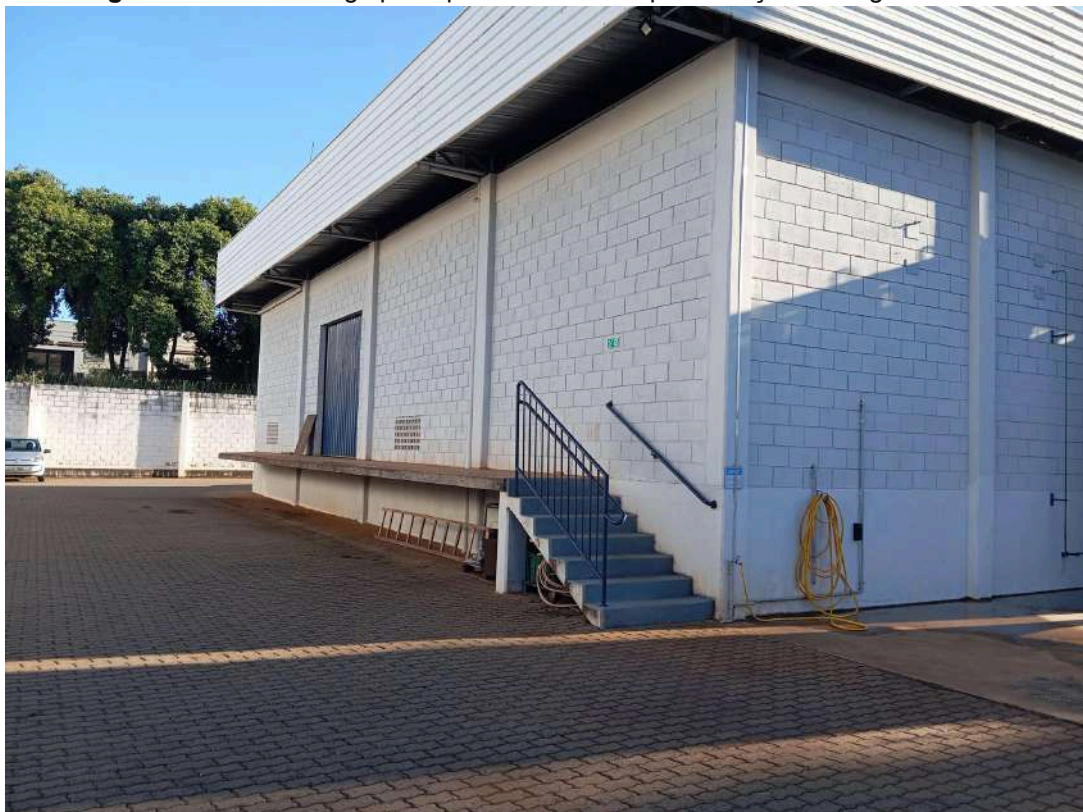
Figura 17- Lateral do galpão operacional com apresentação da segunda baía.
