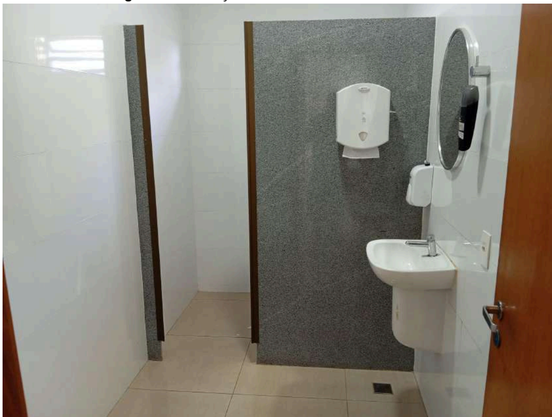
Figura 34- Instalações Sanitárias - Área administrativa.
