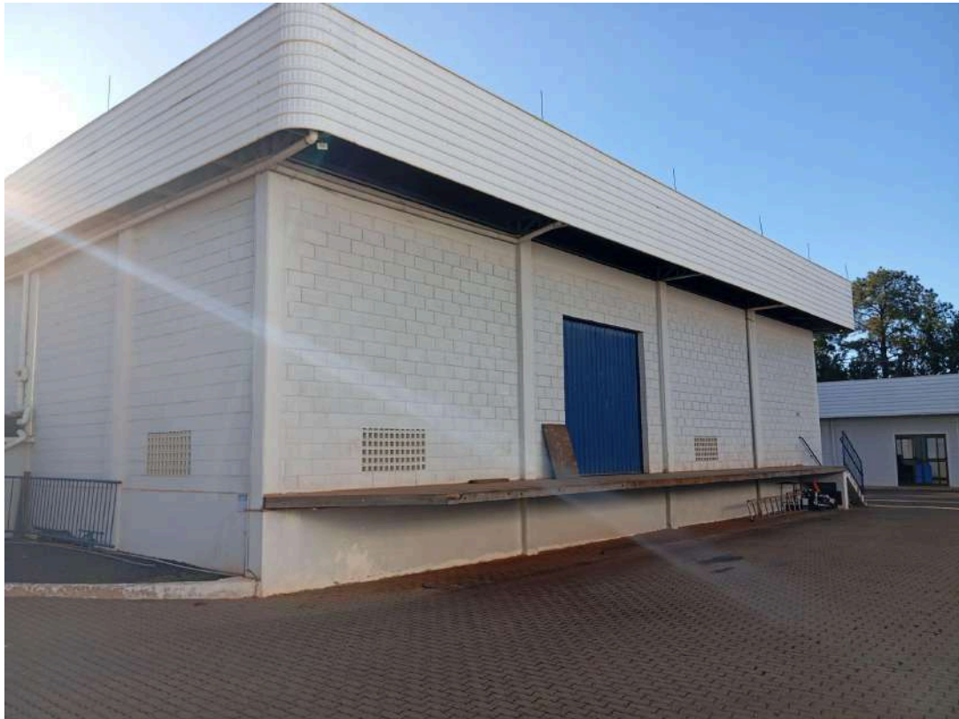
Figura 18- Lateral do galpão operacional com apresentação da segunda baia.
