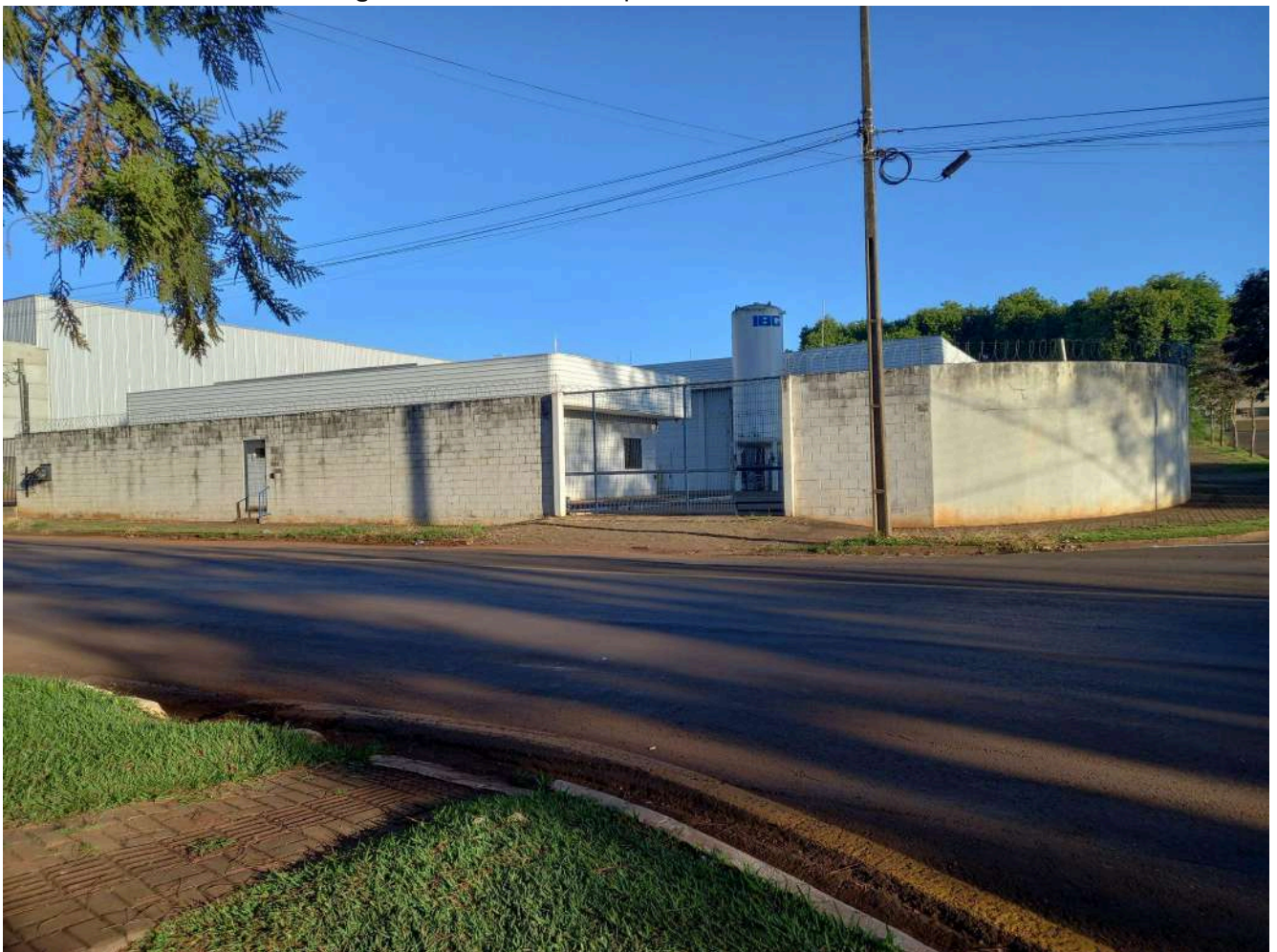
Figura 5- Fachada do empreendimento, vista frontal.
