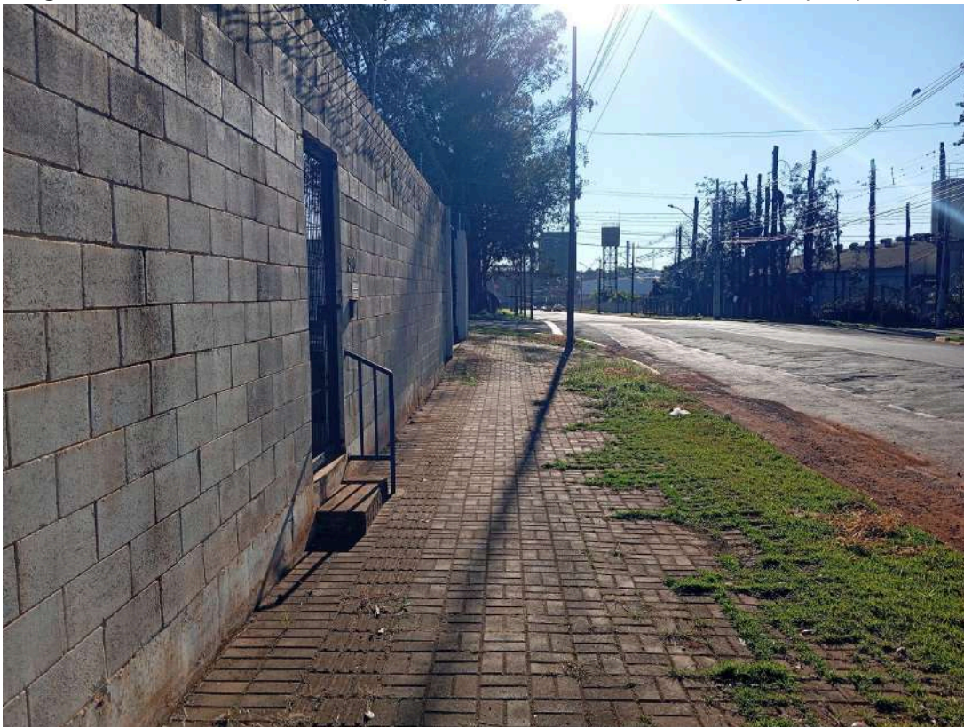
Figura 100- Passeio frontal ao empreendimento com área de drenagem e piso podotátil.
