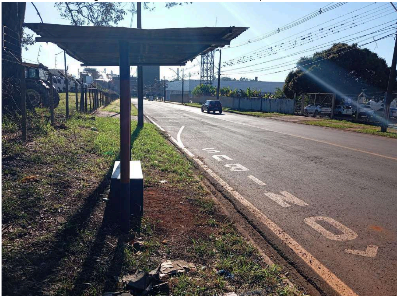
Figura 101- Ponto de Ônibus no entorno do empreendimento.
