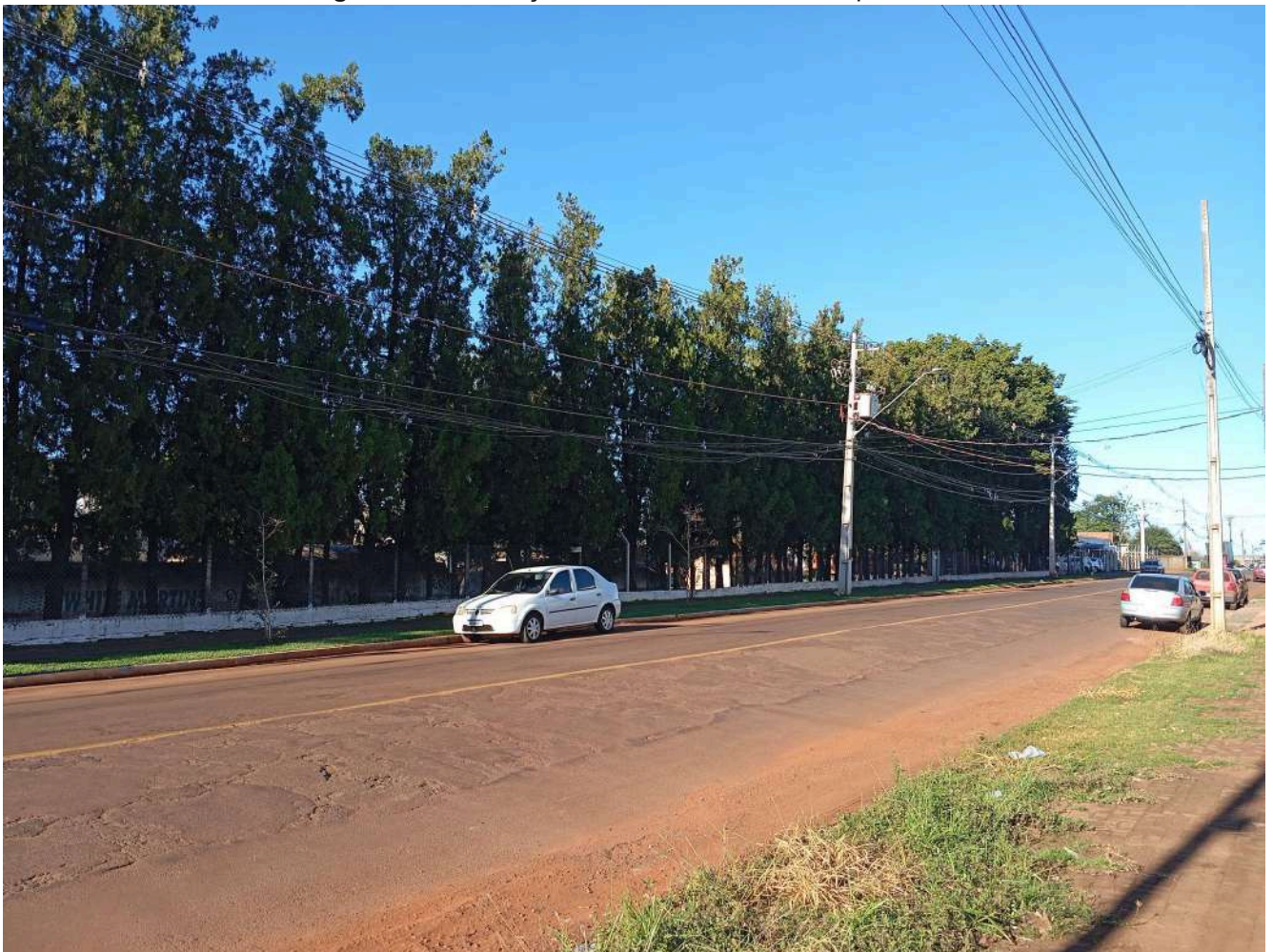
Figura 89- Sinalização horizontal na Avenida Esperanto.
