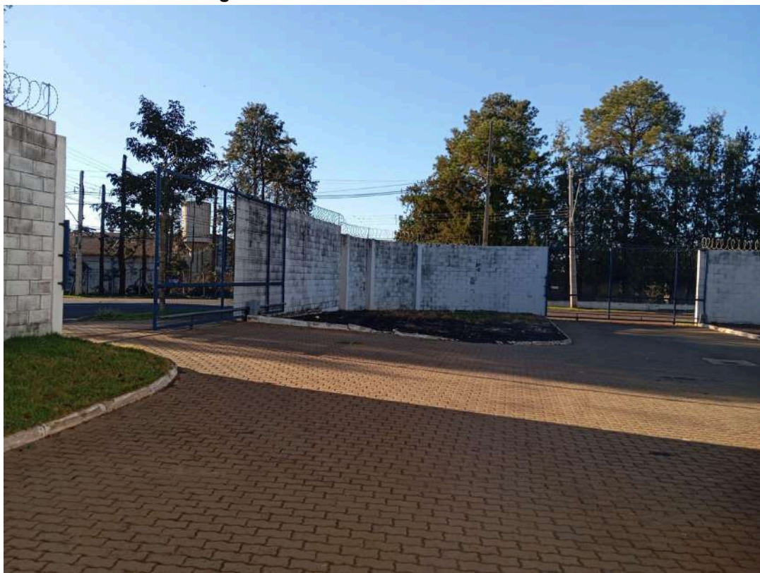
Figura 8- Portões de acesso - Vista interna.
