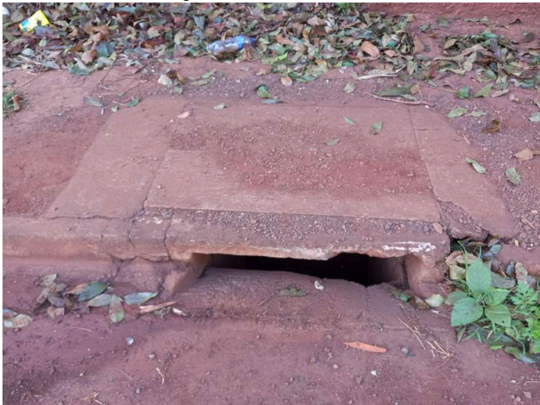
Figura 63- Bocas de Lobo na AID.
