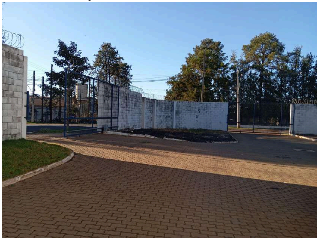
Figura 92- Portões de acesso - Vista interna.
