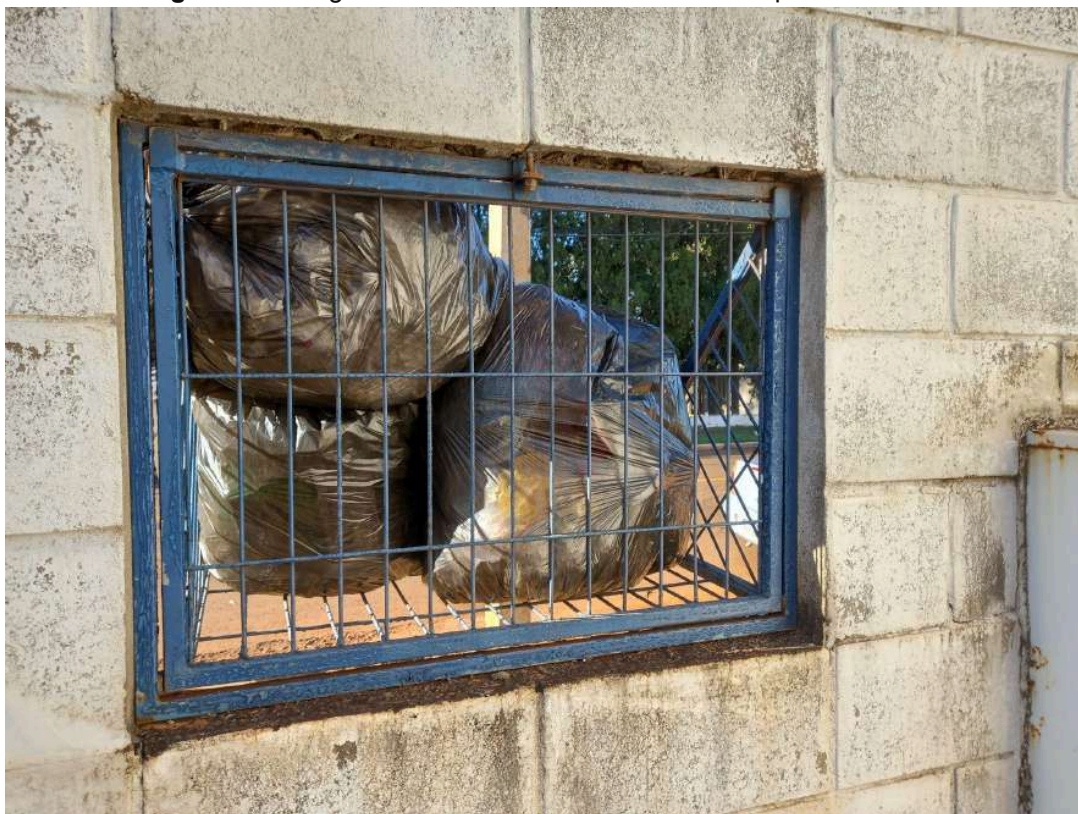
Figura 22- Abrigo de resíduos visto do interior do empreendimento.
