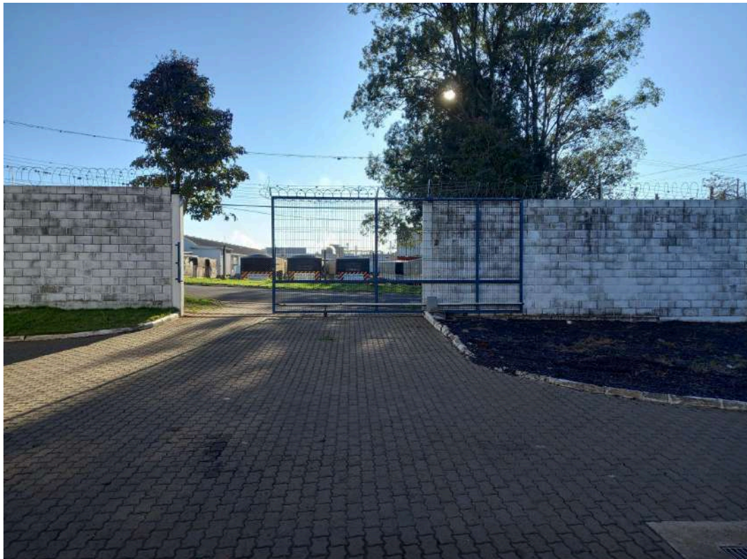
Figura 4- Portão de acesso - vista interna.
