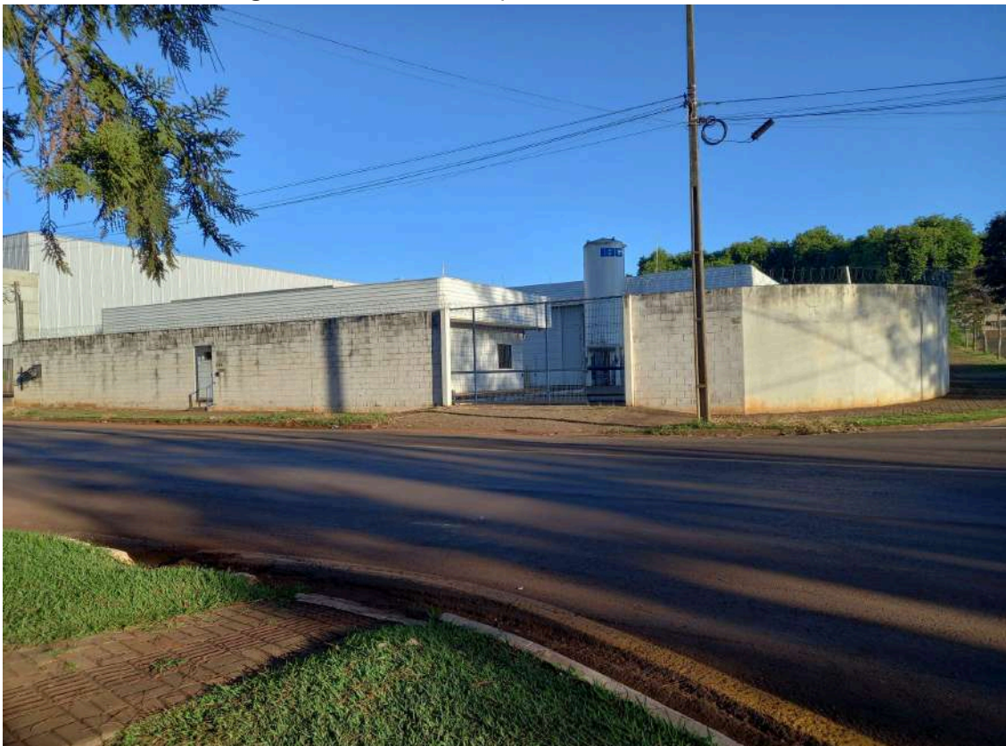
Figura 3- Fachada do empreendimento, vista frontal.
